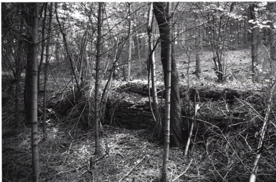
■ 5 Neuensteiner Steige bei Forchtenberg (Hohenlohekreis). Im unteren Teil des Aufstiegs vom Kochertal auf die Hochflache ist die historische Verkehrsverbindung als Hangweg mit talseitigen Trockenmauern ausgebildet (Aufnahme 1995).
