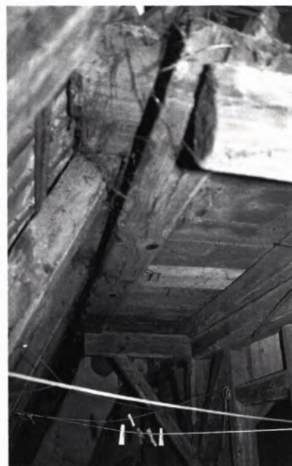
■ 2 Gebäude Marktplatz 10, 1. Dachgeschosß, Südseite. Die Pfetten wurden für die nachträgliche Abwalmung abgesägt. Als Stützkonstruktion wurde in diesem Bereich ein stehender Stuhl eingestellt.
