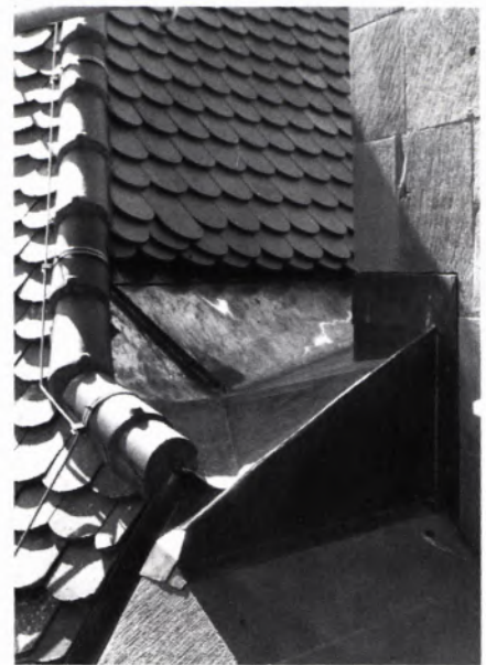
■ 18 Flaschnerarbeiten zur verbesserten Wasserführung vom Mittelschiffdach zum Turm.
