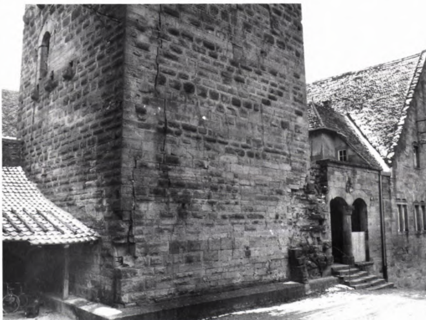
■ 13 Dachstuhl des Ökonomiegebäudes, Schadensbild. Foto 1996, LDA.
