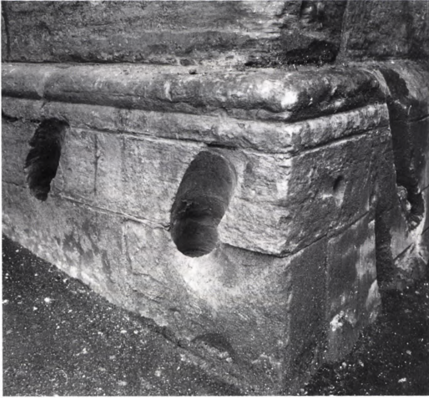
■ 10 Südöstliche Sockelzone am Turmdurchgang. Injektionsbohrungen durch profilierte Steine.
