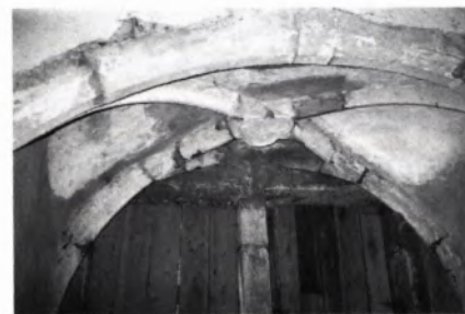
■ 9 Palas, gotisches Kreuzrippengewölbe. Foto 1996, LDA.
