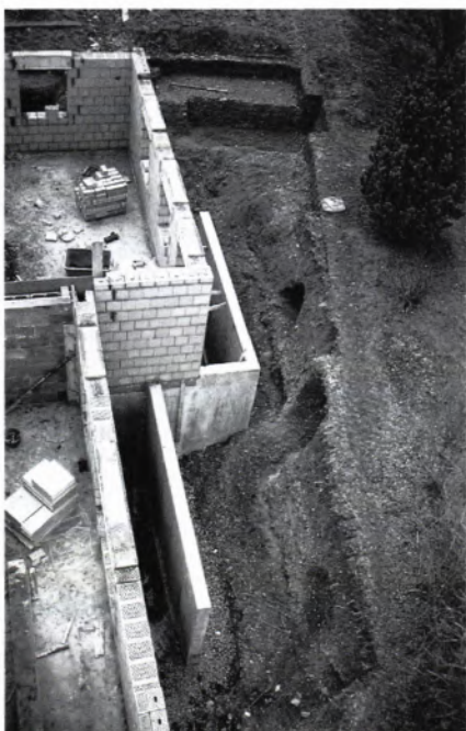
■ 8 Kirchheim am Neckar; im Baugebiet „Lüssen“ am Storchenweg angelegte Baugrube mit angeschnittenen und von Unbefugten angegrabenen fränkischen Gräbern des 7. Jhs. n. Chr.
