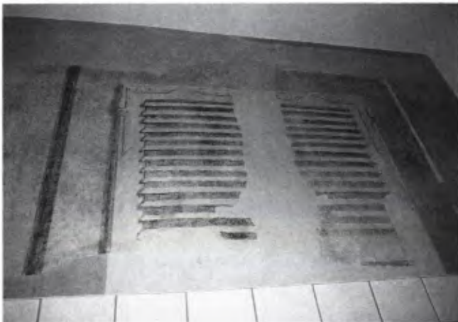
■ 6 Brüstungsfassung in der Mansarde kurz vor Abschluß der Restaurierungs- und Bauarbeiten, Mai 1996. Photo Banzhaf, Verbandsbauamt Bönningheim.
