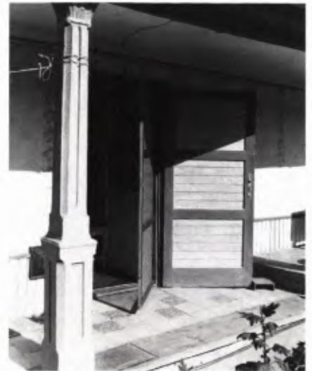
■ 11 Püspöklak. Florian utca 66, Wohnhaus: Straßenansicht mit später zur Ausbildung eines Laubenganges angehobenem Dach.
