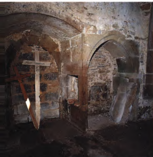
Nordwand des ehemaligen Dormentgebäudes; die früheren Kirchenzugänge für die Nonnen sind längst vermauert. (Zustand September 1996)
