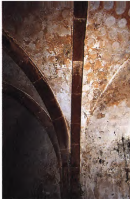
Detail aus dem Kreuzrippengewölbe der Sakristei im Ostflügel der Klausur. Gut zu erkennen in den Feldern zwischen den Steinrippen sind die ockerfarbenen und weißen Ornamentreste aus der Entstehungszeit des Dormentgebäudes.
