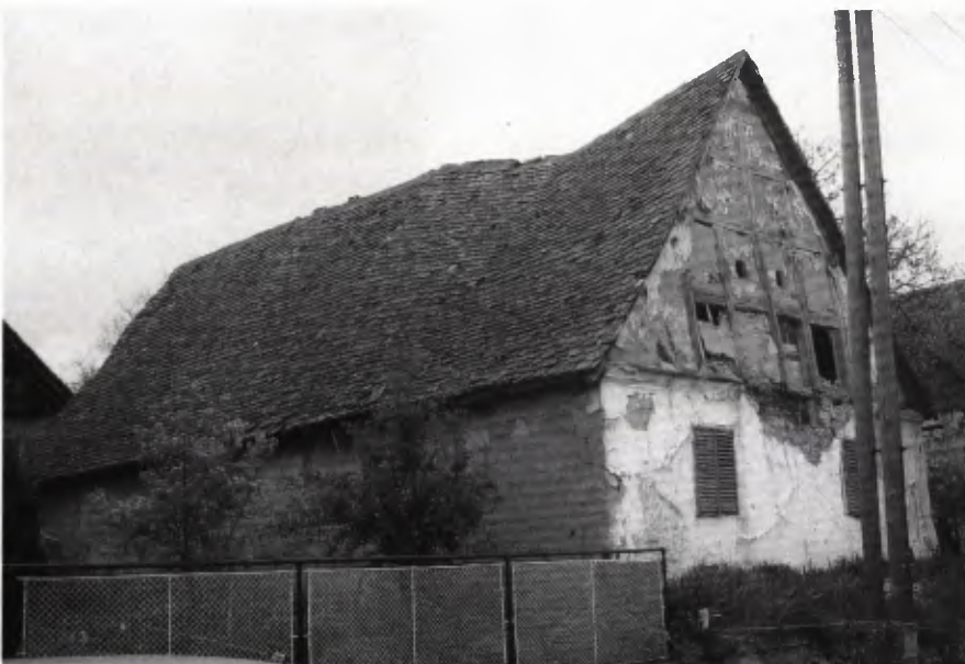
■ 13 Geresd. Dozsa Gy utca 40, Wohnhaus: Straßenansicht mit Fachwerkgiebel und nördlicher Längsseite.
