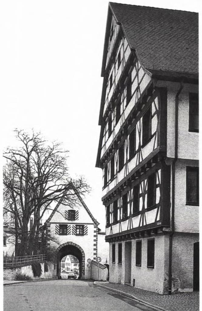
■ Das Zwifalter Tor, entstanden durch einen Umbau der St. Michaelskapelle 1803.
