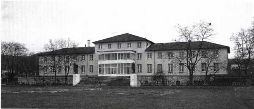
■ 1 Das ehemalige Empfangsgebäude am Ortsrand des Freiburger Flugplatzes, erbaut 1939–42, vom Flugfeld aus gesehen. Der verglaste Anbau vor der Gebäudemitte stammt aus den 50er Jahren. Zur vorgelagerten Terrasse führt eine breite, von zwei Skulpturen flankierte Freitreppe. Foto 1994.
