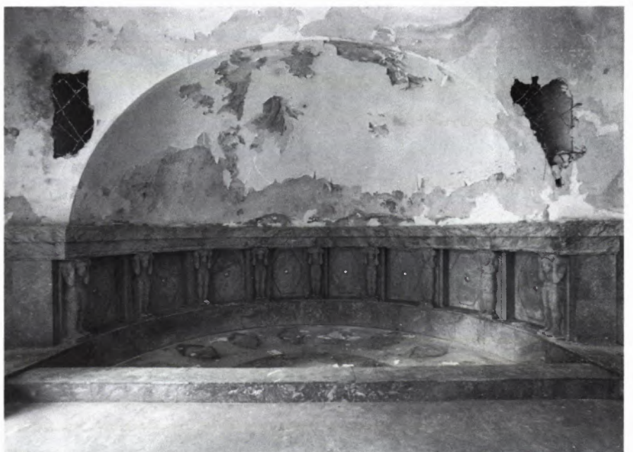
■ 19 Marmorssaal, Zustand der linken Halbkuppel 1986. Photo: I. Geiger, LDA.
