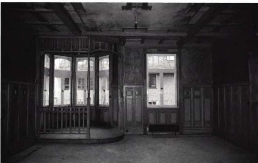
■ 5 Oberdorfstraße 16, Erdgeschoß, Wohnraum.
