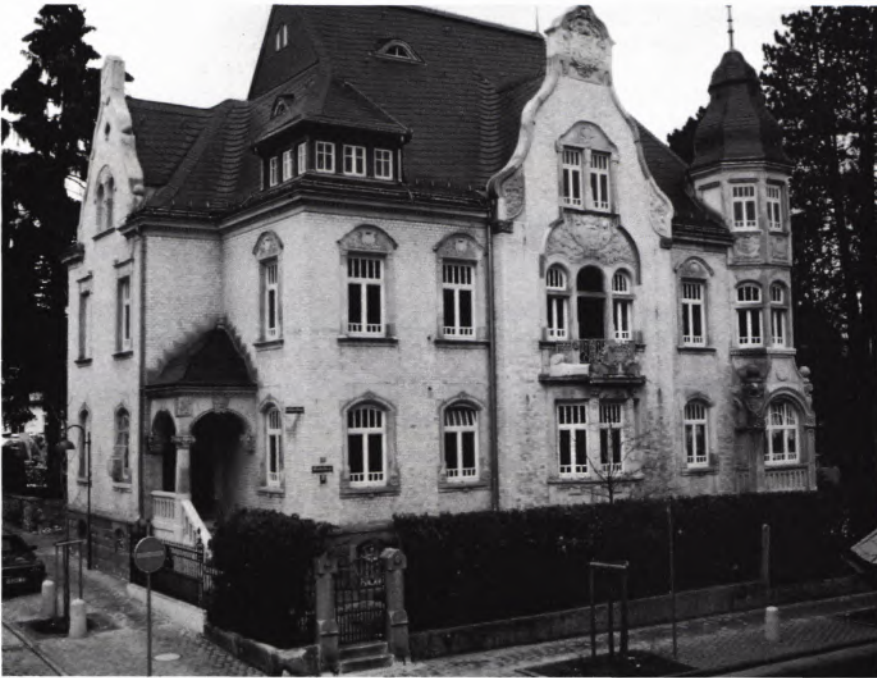
■ 3 VS-Schwenningen, Oberdorfstraße 16, Hauptansicht.
