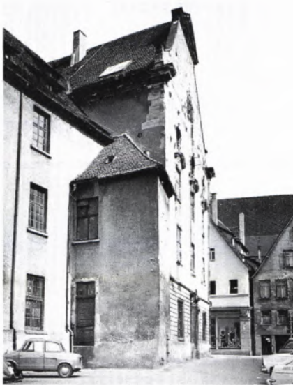
■ 8 Der Prediger in Gmünd, Westfassade mit Portal an originaler Stelle, 1967. (Foto: Stadt Schwäbisch Gmünd, Stadtmessungsamt.)
