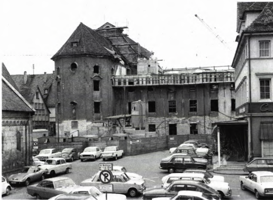
■ 1 Der Prediger in Gmünd, Ostfassade gegenüber der Johanniskirche, Zustand 1970 während des Umbaus. (Foto: Stadt Schwäbisch Gmünd, Stadtmessungsamt.)
