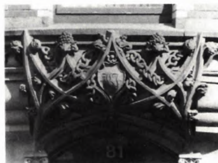
■ 20 Ehem. Schmuck- und Uhrkettenfabrik Kollmar & Jourdan AG. (Bleichstraße 81), Supraporte mit Firmenemblem, Uhrketten und gotisierendem Stabwerk. Roter Sandstein, ca. 1910.
