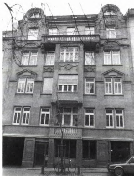
■ 11 Hohenzollernstraße 79, erbaut 1908 als Wohnfabrikhaus nach Plänen von P. Fries und H. Kurr (Pforzheim). Fenster 1989 mit Schallschutzflügeln unter Erhalt der originalen Unterteilung und Jugendstil-Farbverglasung (im Mittelfeld) erneuert.
