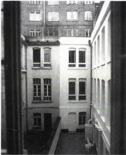
■ 10 Bleichstraße 92/94, Blick aus dem Treppenhausfenster auf die rückwärtigen Fabrikflügel mit Dachterrassen.
