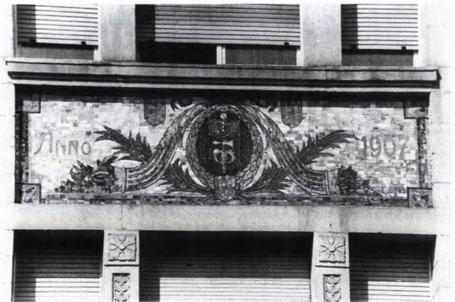
■ 23 Bleichstraße 94, Brüstungs mosaik mit Bauinschrift und Insignien des Goldschmiedehandwerks (vgl. Abb. 7–10).
