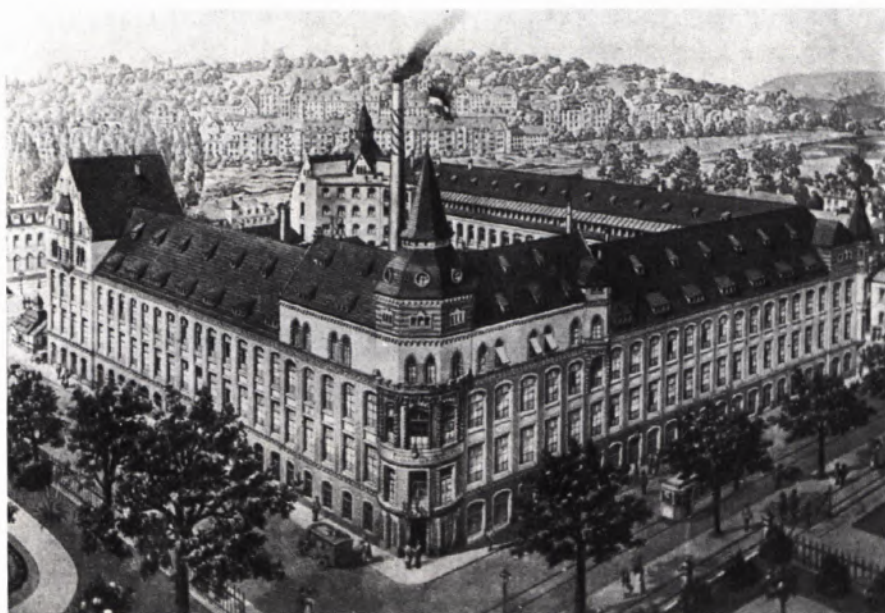
■ 19 Ehem. Schmuck- und Uhrkettenfabrik Kollmar & Jourdan AG. (Bleichstraße 81), erbaut 1901–1910 nach Plänen des Architekten H. Walder (Karlsruhe). Historisches Vogelschaubild (Stadtarchiv Pforzheim). Fabrikbau nach Kriegsschäden vereinfacht wiederhergestellt.
