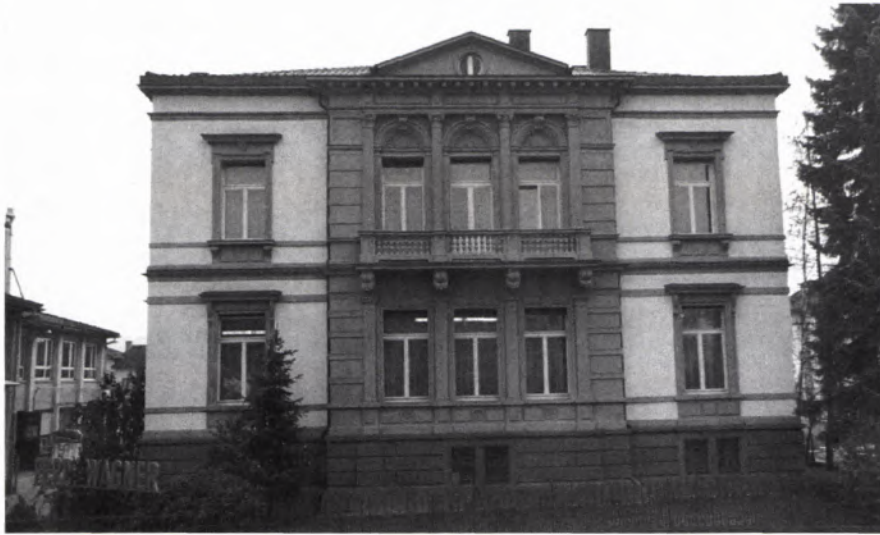
■ 4 Einziger Überrest der gründerzeitlichen Weststadt: die 1877 erbaute Villa des Ringfabrikanten W. Bizer (Tunnelstraße 31). Der zugehörige Fabrikflügel wurde modern wiederaufgebaut (im Bild links angeschnitten).
