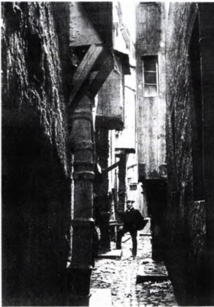
■ 10 Die Entsorgung häuslicher Abfälle erfolgte über Fallrohre in „Ehgräben“ (Konstanz). Foto: G. Wolf.
