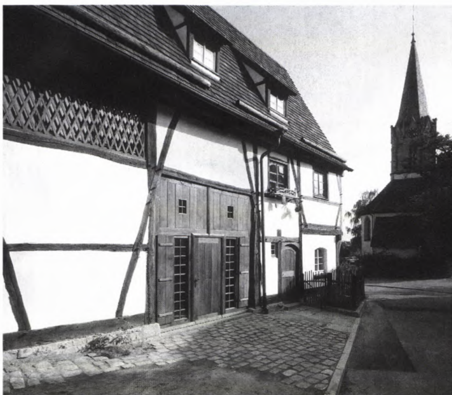
■ 6 Das Haus von der westlichen Traufseite mit der evangelischen Pfarrkirche im Hintergrund, Zustand nach der Restaurierung 1992.
