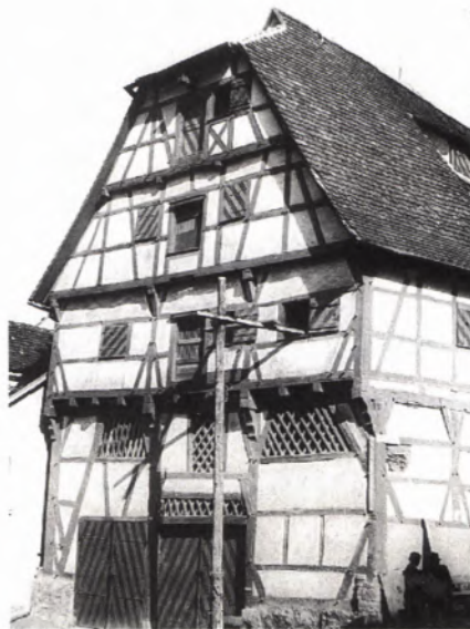
■ 9 Hirtenscheuer in Schwäbisch Hall mit den zum Vorbild genommenen rautenförmig ausgestakten Lüftergefachen. Photo um 1910.
