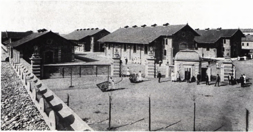
■ 4 Ein Blick vom Dach des Börsen- und Restaurationsgebäudes auf die Hallen des Schlachthofes. Photo ca. 1887.
