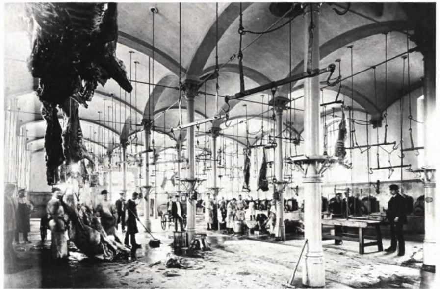
■ 1 Die Schlachthalle für Großvieh in einer Aufnahme unmittelbar nach der Fertigstellung im Jahr 1887.
