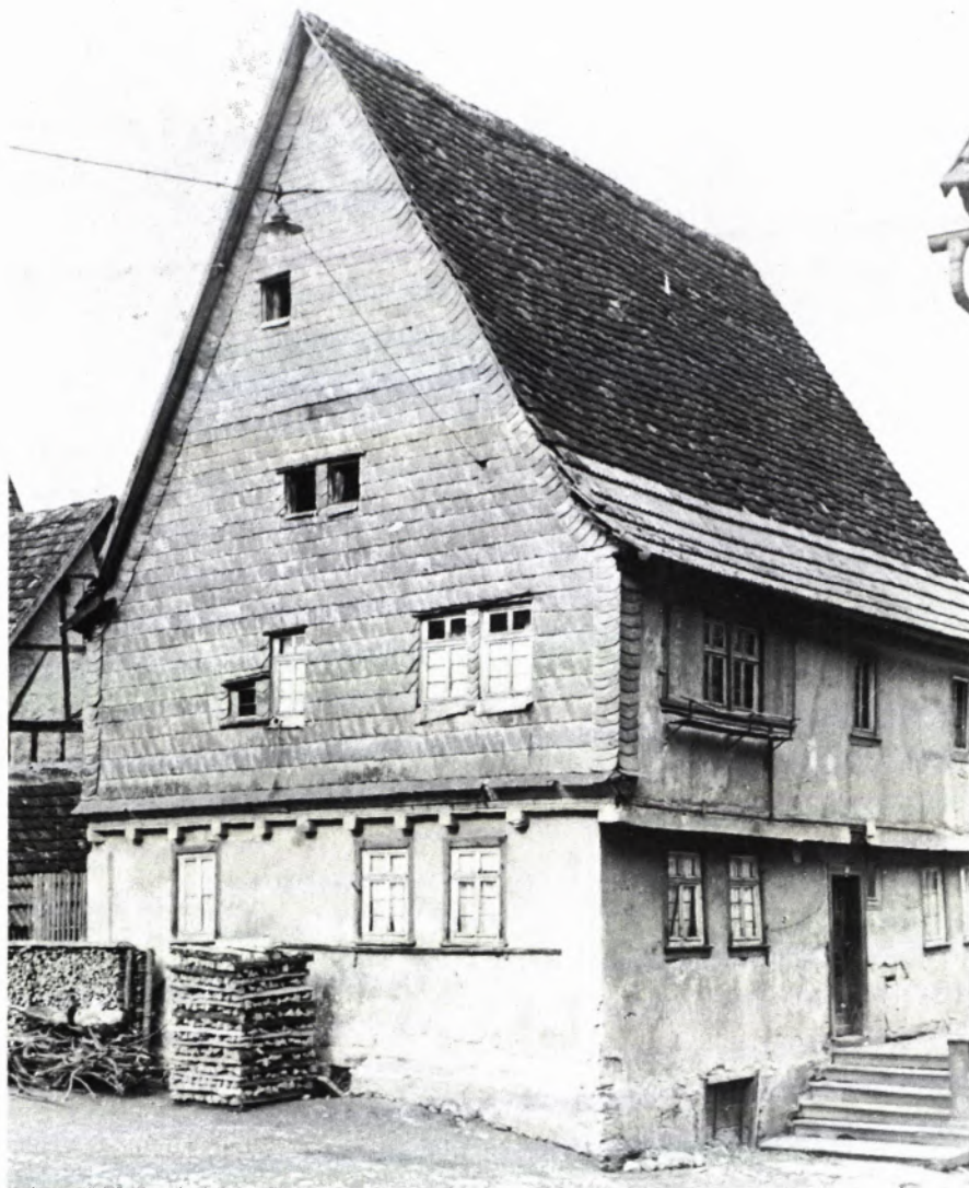
■ 7 Bauernhof Kirchweg 4, ein sog. Streckhof, von 1761, in einer alten Aufnahme von ca. 1925 mit verputztem Fachwerk.
