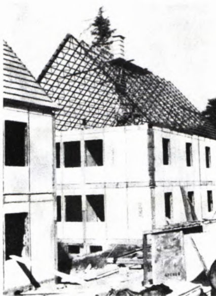
■ 3 Rohbau eines in Messerschmitt-Bauart erstellten Wohnhauses. Die vorgefertigten Konstruktionselemente sind gut zu erkennen.
