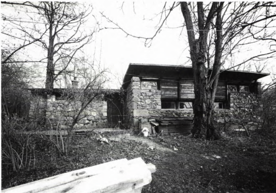
■ 1 Die „Hütte“ von Westen zu Beginn der Renovierungsmaßnahmen.
