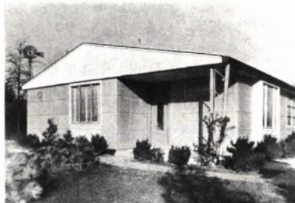
■ 5 Lustron-House USA, Stahlgerippehaus mit Stahltafelverkleidung.
