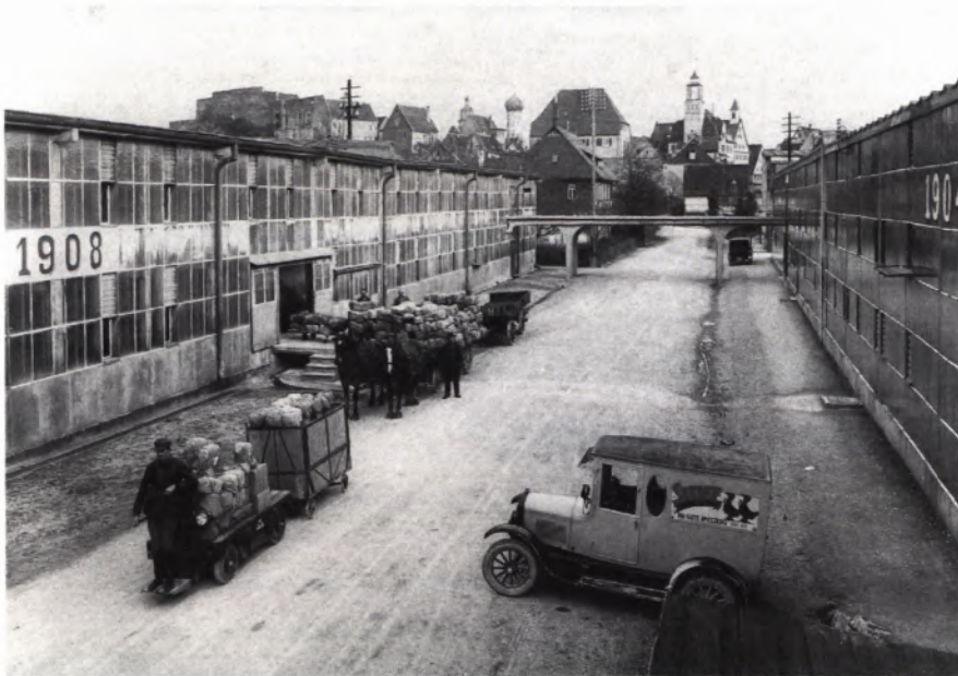
■ 9 Süd- und Westbau, Blick zum Schwibbogenplatz; die beiden Gebäude wurden in Anlehnung an den 1903 errichteten Eisenskelettbau in der leichter herzustellenden genagelten Holzkonstruktion ausgeführt. Foto um 1920. (Foto: Firmenarchiv der Margarete Steiff GmbH, Giengen/Br.)
