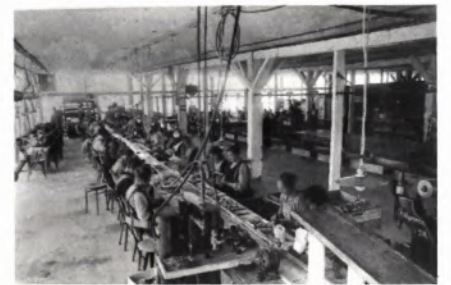
■ 11 Innenansicht Fabrikationsraum in den 1904 und 1908 erstellten Holzskelettbauten. Historische Aufnahme. (Foto: Firmenarchiv der Margarete Steiff GmbH, Giengen/Br.)
