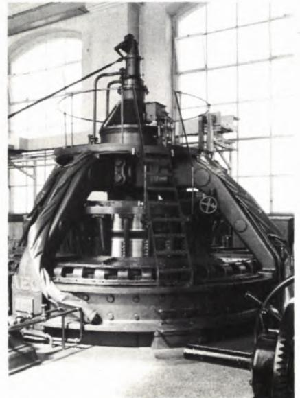
■ 11 Der von der AEG gefertigte Gleichstromgenerator sitzt auf einer von der Firma Voith 1934 gebauten Turbine.
