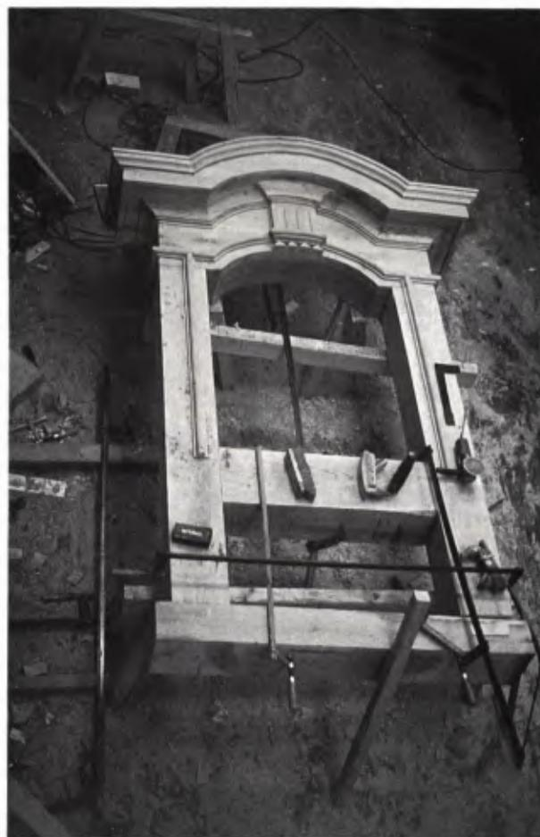
5 WERKSTATTARBEIT an der zerlegten Dachgaube, Holz. Ersetzen und Reparieren mit altem Eichenholz.
