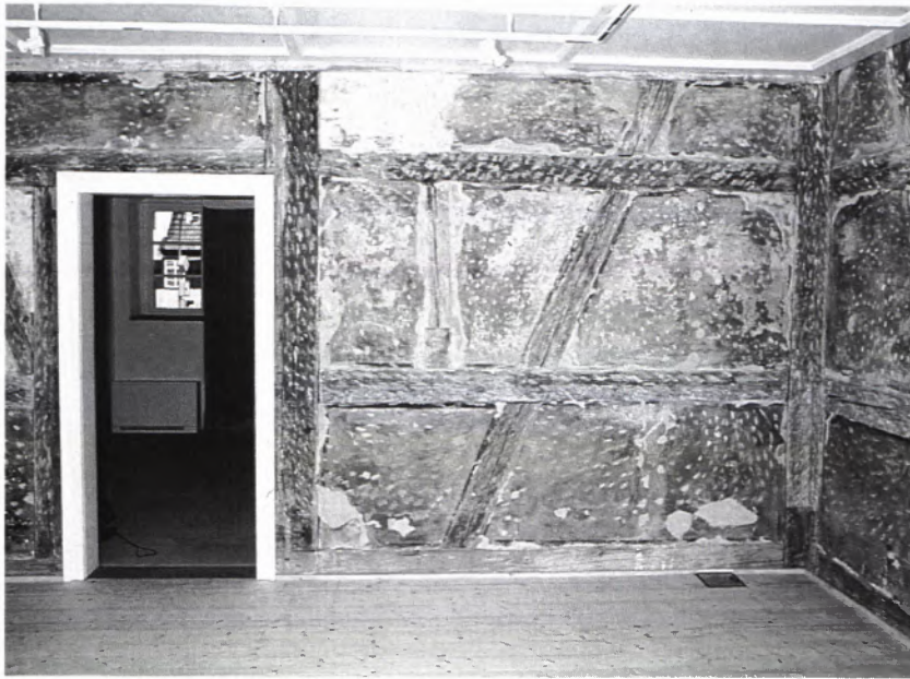
12 WESTLICHE STUBE mit grau gefasstem Fachwerk nach der Freilegung.
