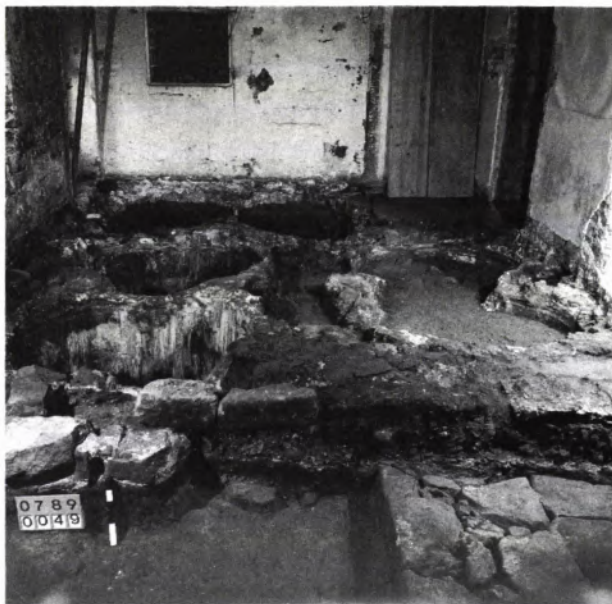
8 CALWER STRASSE 6. NORDOSTRAUM von Norden (Südhälfte). Im Vordergrund die abgebrochene Ostwand des romanischen Nordraumes, dahinter die Überreste der hölzernen, teilweise noch verfüllten Gerberbottiche des 19. Jahrhunderts. Grabung 1989.
