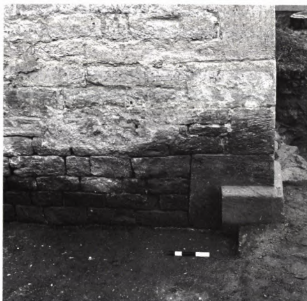
6 CALWER STRASSE 6. SÜDWAND des Kapellenraumes von Süden. Die Grenze des romanischen Mauerwerks liegt auf Höhe der Oberkante des über dem Eckblock verlegten Läufers. Der darüberliegende Verband gehört zur älteren, im späten 15. oder der ersten Hälfte des 16. Jahrhunderts erfolgten Umbauphase. Grabung 1989.
