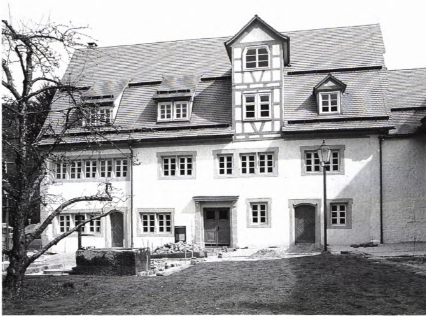
9 WESTFASSADE von Calwer Straße 6, bei Abschluß der Gebäudesanierung (Aufn. April 1991).
