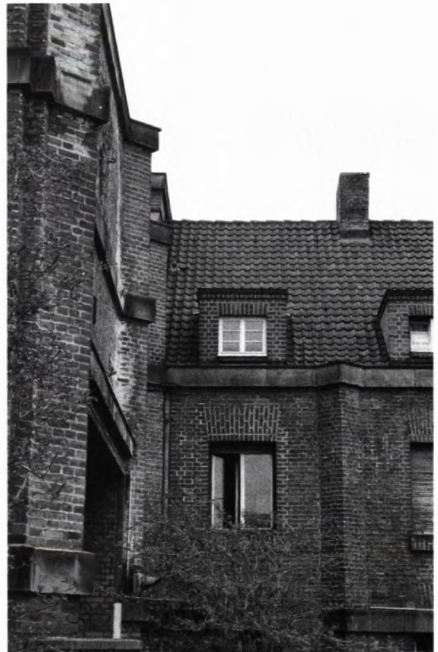
8 DETAIL VON HALLE UND BÜRO- UND WOHNTRAKT des Rhein Stahlwerks in Stuttgart-Feuerbach, Photo März 1991.
