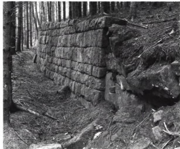
4 MITTLERER GRABEN mit hangseitiger, erneuerter Stützmauer, z.T. verstürzt. Der ehem. Wasserlauf tritt durch den talseitig dammartig ausgebildeten Rand deutlich hervor.
