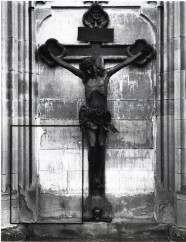
8 SALEM, ehem. Klosterkirche, nördliches Querhaus. Aufnahme von 1935. Die Sockelpartie bis zur dritten Steinlage sowie die unteren Gewändesteine sind Auswechslungen (vgl. dazu auch U. Knapp, 1988, dortige Abb. 1). In den unteren Bereichen hatten sich bereits damals neue Steinschäden entwickelt.
