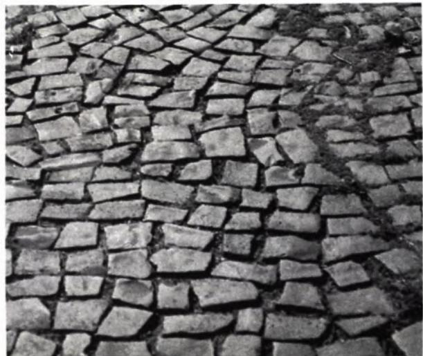
15 PFLASTER – als Alternative zu Asphalt oder – in Fußgängerzonen – zu übergestaltetem Straßen- und Platzbelag ein positiver Beitrag zum Charakter historischer Straßenräume; als kaschierende Abdeckung von modern-funktionalen Tiefbauwerken im Stadtboden einer der fragwürdigen Faktoren innerhalb der aktuellen Altstadtaufwertung.
