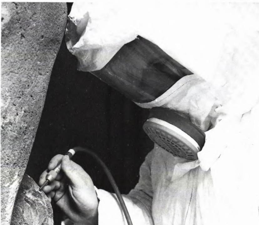
8 ARBEIT mit dem Mikrostrahlgerät, um die letzte Schmutzschicht steinschonend zu entfernen.
