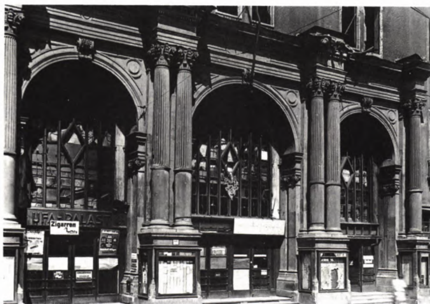
11 HAUPTPORTAL des UFA-Palastes kurz nach dem Krieg.
