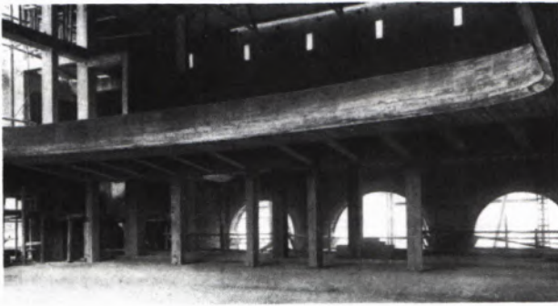
6 DIE STAHLBETONKONSTRUKTION des Balkons im Rohbau. (Aus: J. Vischer, L. Hilberseimer, Beton als Gestalter , Stuttgart 1928.)
