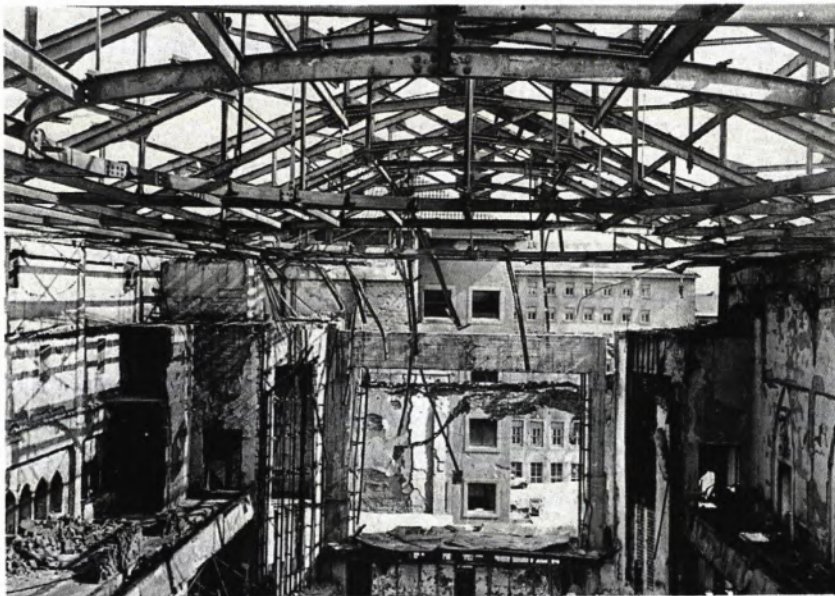
13 DER LICHTSPIELSAAL nach der Zerstörung. Blick gegen die Bühne. Die erhaltene Dachkonstruktion wurde in den heutigen Bau übernommen.
