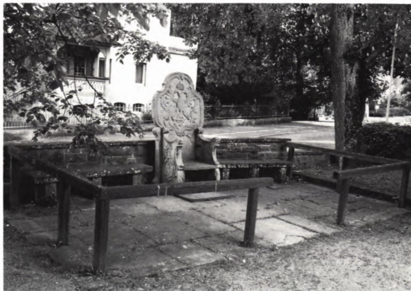
11 DER HOFRICHTERSTUHL mit Beisitzerbänken und Schranken, Blick zur Lorenz-Bock-Straße (ehem. Karlstraße).
