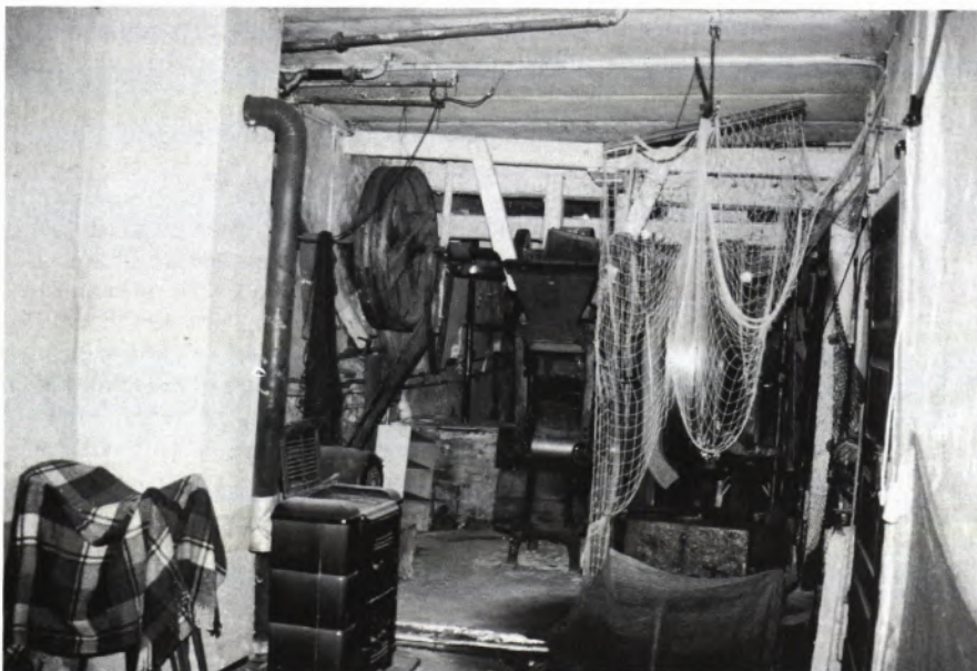
5 QUETSCHMÜHLE für Ölsaaten. Transmissionsantrieb, hinter dem Ofen der zentrale Drehstrommotor. Foto: Stadtarchiv Marbach a. N.
