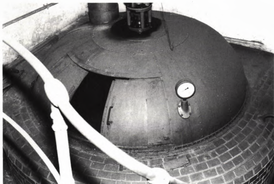
7 PFLUGBRAUEREI in Geislingen a. d. St. Eingemauerte Bräupfanne mit direkter Heizung.
