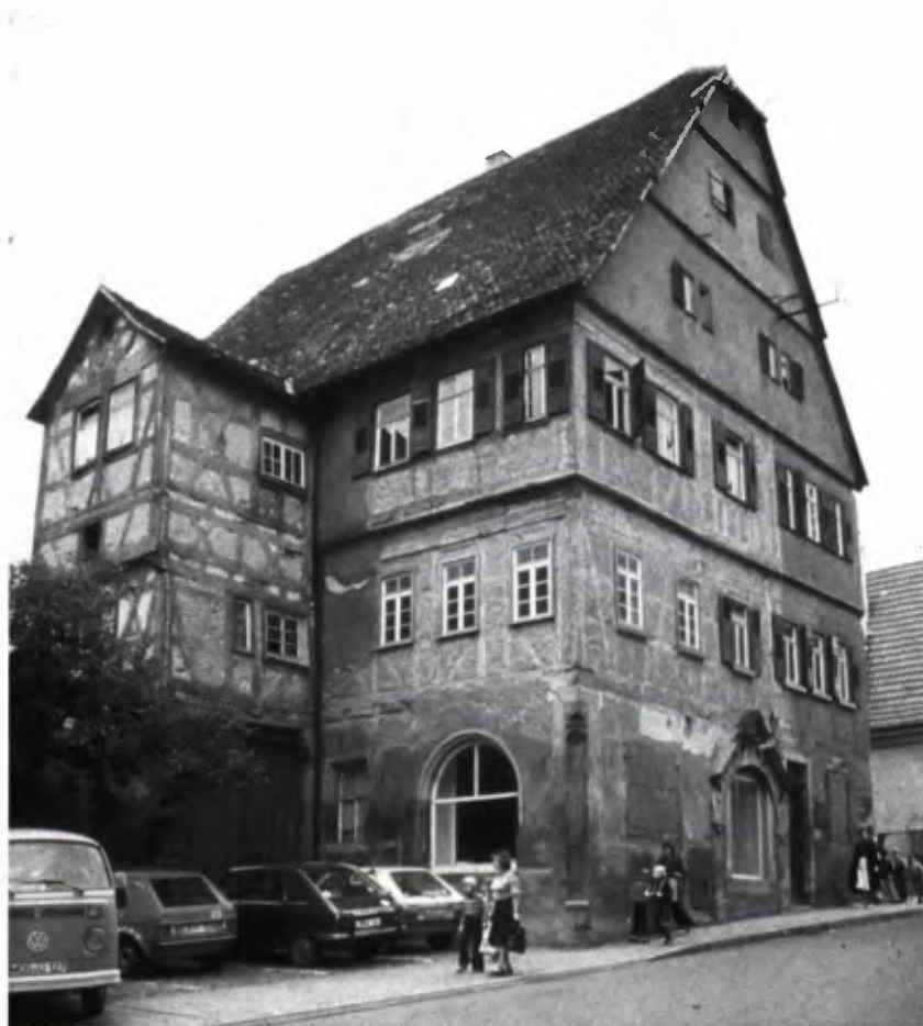
1 DAS HORNOLDHAUS in Bietigheim in einer Ansicht von 1976.
