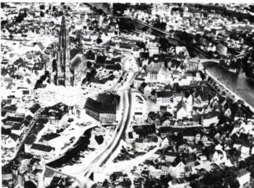
16 ULM, Blick auf die im Bau befindliche Neue Straße, Zustand 1953.
