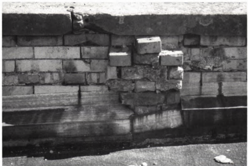
4 DIE KEHRSEITE der Fassade: handwerkliche Flickschusterei, für die Jahrhundertwende keine Besonderheit.
