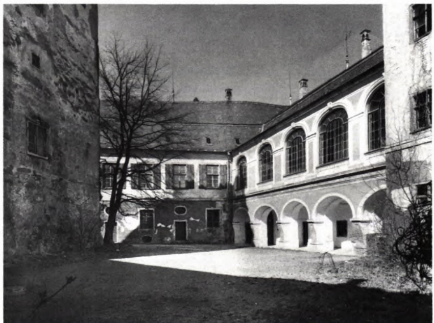
8 BAUGRUPPE aus dem Mittelalter und Frühklassizismus: der Nordgiebel von Bau A und der Arkadengang am Bau D; im Hintergrund der Barockflügel C; Aufnahme 1980.
