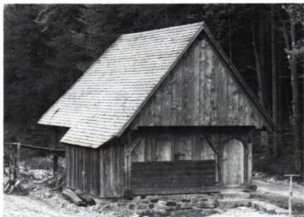
6 GETREIDEMÜHLE des Hochbronner Hofes auf dem Gelände des Freilichtmuseums.
