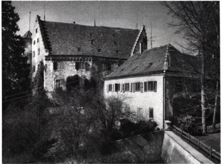
7 BLICK ÜBER DAS „NEUBÄULE“ (E 2) auf die Ostfront des mittelalterlichen Kernbaus (A); Aufnahme 1980.
