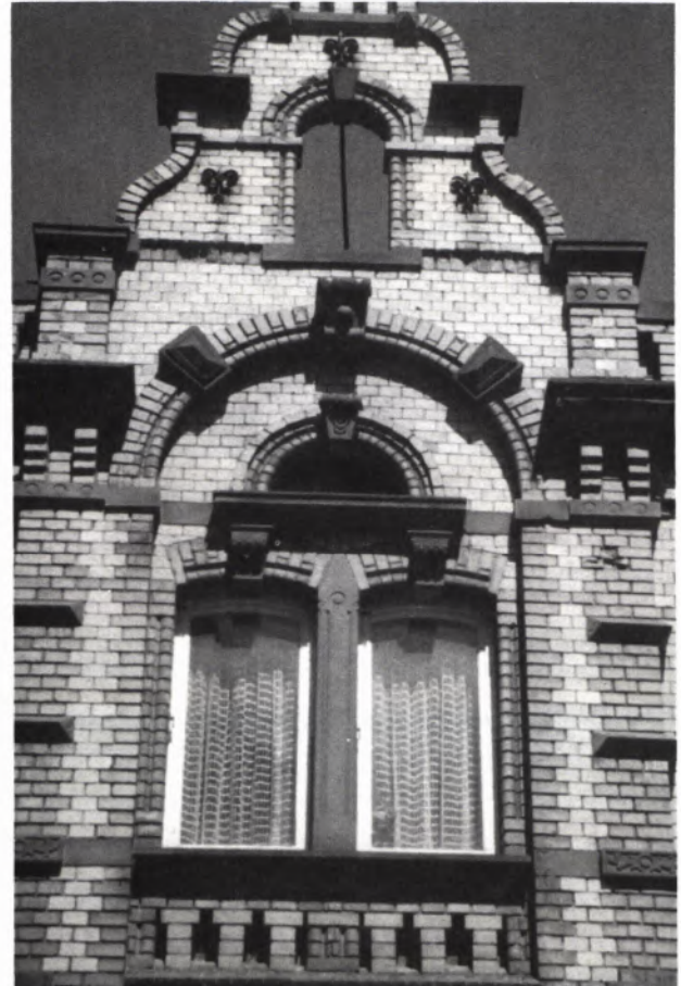
3 KEINE RUINE: Einer der „luftigen“ Quergiebel.
