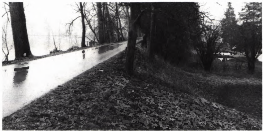
16 DAMM des Aalkistensees, an dessen Westufer, von Norden gesehen.
