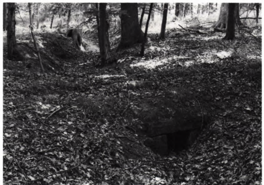
6 IM ALLMENDWALD wird der Graben von einem Weg geschnitten. Die Überführung aus sorgfältig bearbeitetem Sandstein erhält die Funktion des Grabens, während der moderne Feld- und Waldwegebau darauf oft keine Rücksicht nimmt.
