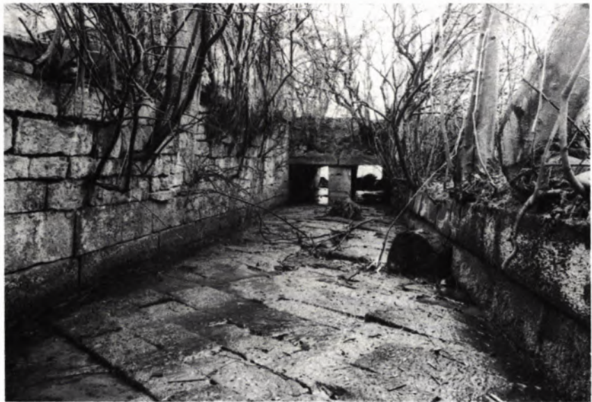
17 KANAL aus Sandstein vom Aalkistensee zur Mühle.
