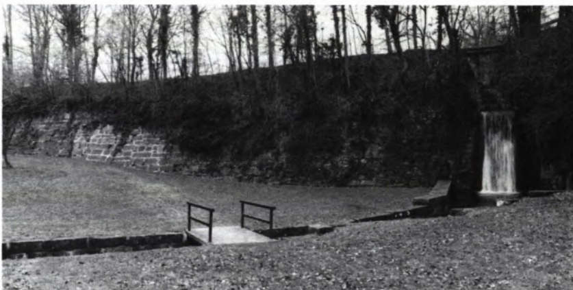
9 DAMM des Tiefen Sees vom Klosterbereich gesehen.
