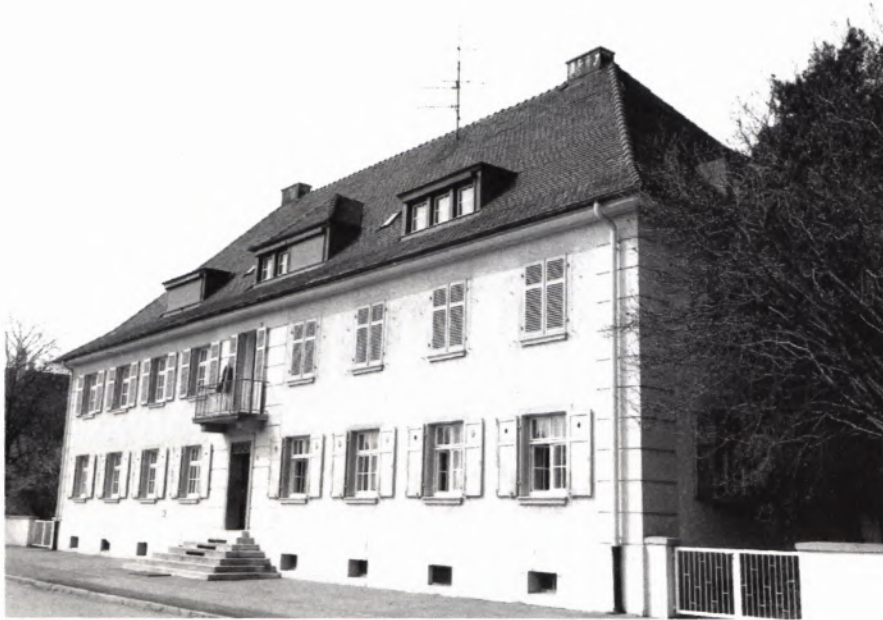
■ 8 Das nachträglich errichtete Beamtenhaus Schloßweg 1.
