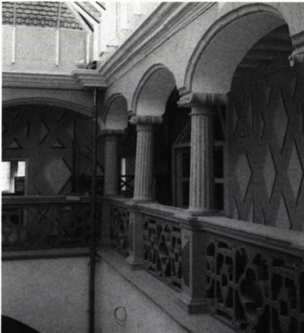
7 BLICK IN DEN LAUBENGANG mit dem gelb gefaßten Sichtfachwerk.
