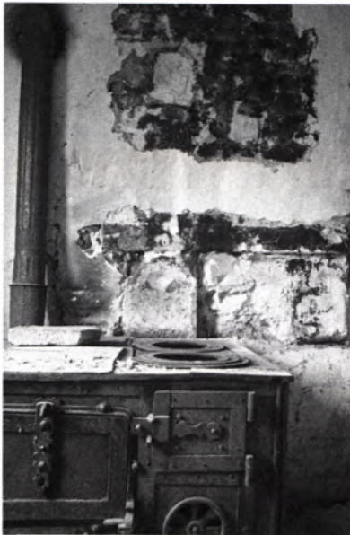
2 VELLBERG, Kreis Schwäbisch Hall, Im Städtle 29 (1584 d), verrußter Wandabschnitt einer Flurküche, unten: Steinfassung der Hinterladeröffnung, oben: Rauchführungslöcher.
