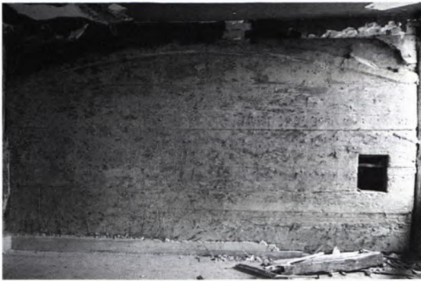
4 ESSLINGEN, Karmeliterstraße 3 (1423 d). Stirnwand einer Bohlenstube mit Basisbohle für die gewölbte Decke.
