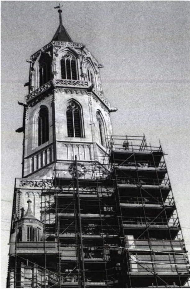
2 u.3 ROTTWEIL, Kapellenkirche. Am Kapellenturm, links, der bereits viele Jahre lang restauriert wird, mußten weite Teile des schwer geschädigten Schilfsandsteins ausgetauscht werden. Nordportal der Kapellenkirche, rechts. Es ist restaurierungsbedürftig, weil eine dunkle Ecke häufig als Toilette mißbraucht wurde. Feuchtflecken und dunkle Zonen weisen auf eine starke Nitratbelastung hin. Die Nitrate sind bis in das vom berühmten Baumeister und Bildhauer Heinrich Parler geschaffene Bogenfeld gestiegen und haben begonnen, es zu zersetzen. Zur Zeit werden Versuche unternommen, den Schaden zu beheben.
