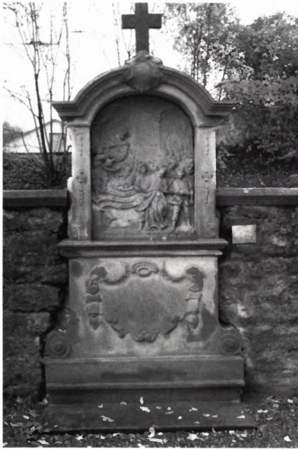
15 u. 16 LAUDA, Main-Tauber-Kreis, Alter Friedhof. Bei der in die Mauer eingelassenen Kreuzwegstation wurde eine Acrylharz-Volltränkung vorgenommen, da das Objekt bereits so weitgehend geschädigt war, daß es nur noch durch diese Maßnahme erhalten werden konnte. Die Aufnahme rechts zeigt ein Detail aus der Kreuzwegstation (der Originalausschnitt ist ca. 20×40 cm groß). In diesem Zustand befand sich das Relief 1985 vor der Behandlung. Die figürlichen Bereiche haben tiefreichende Risse, mürbe Partien und abplatzen-de Schalen, die z. T. hochstehende Schollen bilden.
