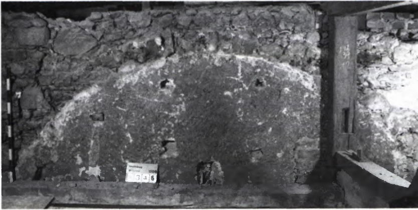
5 ABDRUCK eines Gewölbes im aufgehenden Mauerwerk der Westwand des Waaghause.
