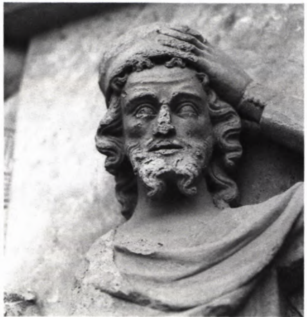
4 u.5 ESSLINGEN, Frauenkirche, Marienportal. Das Tympanon in einer Aufnahme von 1900. Es ist unbeschädigt. Dasselbe Portal im Jahr 1986. Der Zustand vieler Figuren hat sich stark verschlechtert, in einigen Bereichen fehlen bereits Teile. Die hier gezeigte Josefsdarstellung aus der Mitte des unteren Tympanonreliefs zeigt schwerwiegende Steinschäden mit teilweise erheblichen Substanzverlusten besonders an vorspringenden Teilen.
