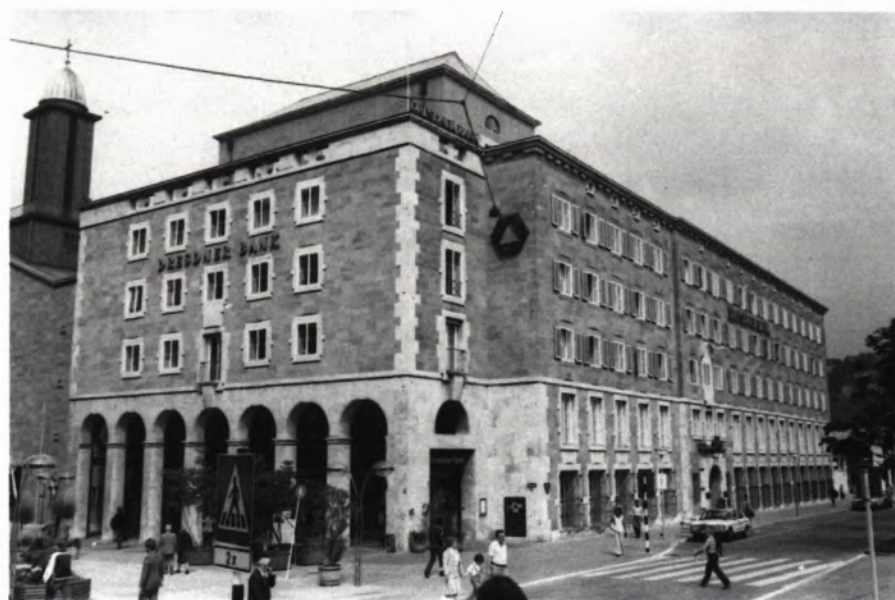
3 STUTTGART, Königstraße 9, Königin-Olga-Bau. Diesem dreiflügeligen, als Stahlskelettkonstruktion errichteten und mit Werksteinfassaden verkleideten Gebäude liegen Pläne von Paul Schmitthenner und Erich Hengerer, 1951, zugrunde. Es ist ein charakteristisches Beispiel für das Bauen der konservativ ausgerichteten Stuttgarter Schule nach 1945 im Zuge des Wiederaufbaus von Stuttgarts zerstörter Altstadt (Foto 1979).
