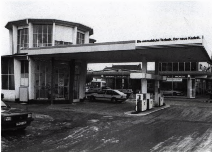
4 FREIBURG; die Tankstelle mit Pavillon und Wartungshalle, Zähringerstraße 40, 1951 von Schelkes, ist eine Stahlbetonskelett-Konstruktion mit den für die Zeit so charakteristischen dünnen Gliedern (die Kante des Tankstellendaches ist verkleidet). Der Pavillon mit seinen trapezförmigen Strebepfeilern verbreitert sich nach oben zu (Foto 1983).
