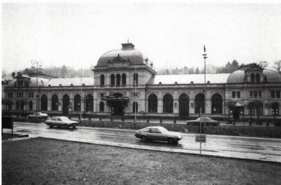
4 DIE HAUPTFASSADE 1988. Blick nach Süden.
