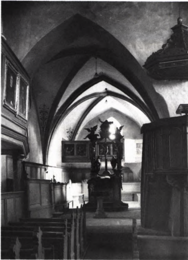
3 BLICK IN DEN CHOR, Aufnahme vor der Renovierung im August 1958. Im Jahr darauf wurde der östliche Zugang vermauert, die Chorempore herausgenommen, der Altar nach Osten versetzt, die Nordempore im Schiff herausgenommen und die Kanzel in die Nordstecke des Schiffes verlegt.
