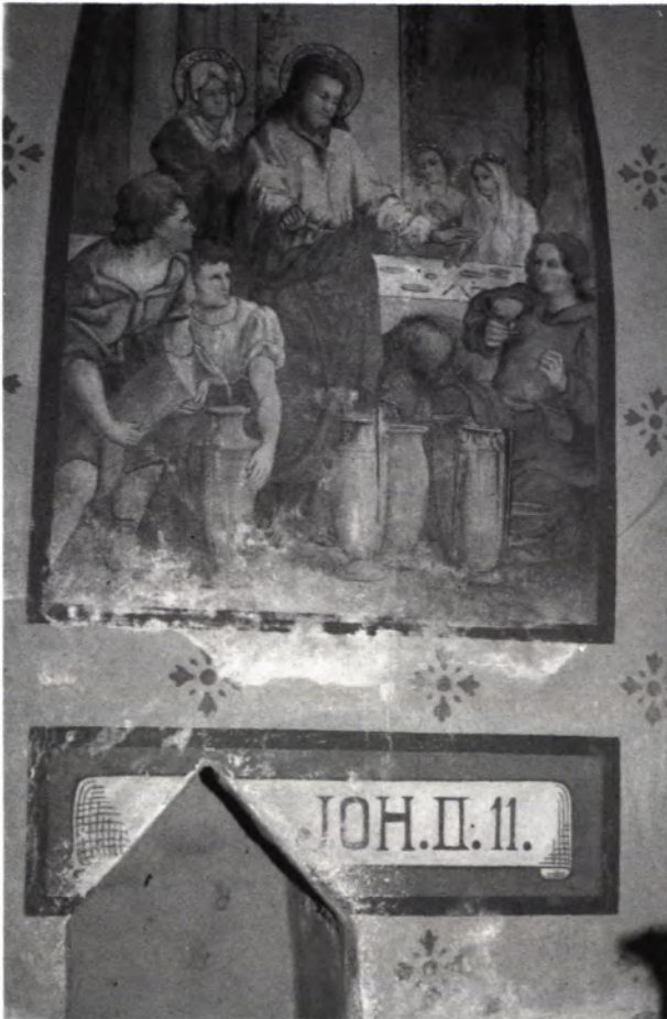
6 u.7 KAUM HATTE DER RESTAURATOR seinen Pinsel aus der Hand gelegt, als Raumfeuchtigkeit und Salze ihre Zerstörungen fortsetzten: Grund für die verstärkten Bemühungen ums rechte Innenklima. Die Schäden konnten gestoppt werden.
