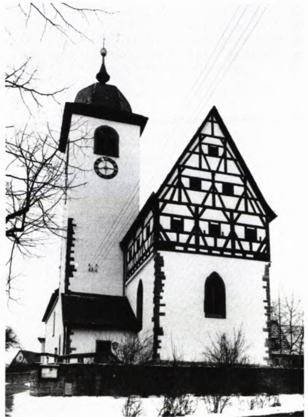
10 OSTANSICHT von Chor und Turm im Februar 1987.
