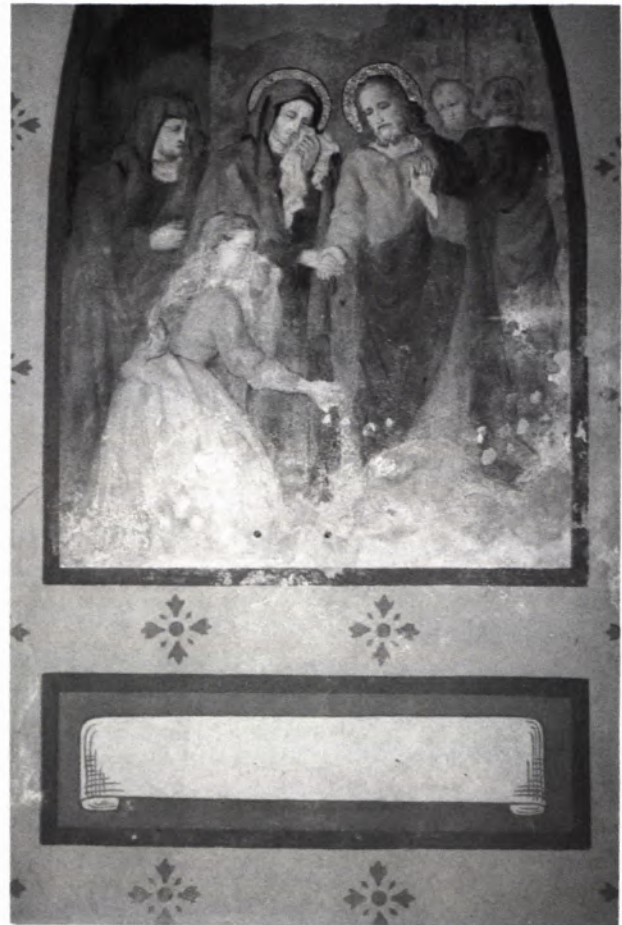
6 u.7 KAUM HATTE DER RESTAURATOR seinen Pinsel aus der Hand gelegt, als Raumfeuchtigkeit und Salze ihre Zerstörungen fortsetzten: Grund für die verstärkten Bemühungen ums rechte Innenklima. Die Schäden konnten gestoppt werden.
