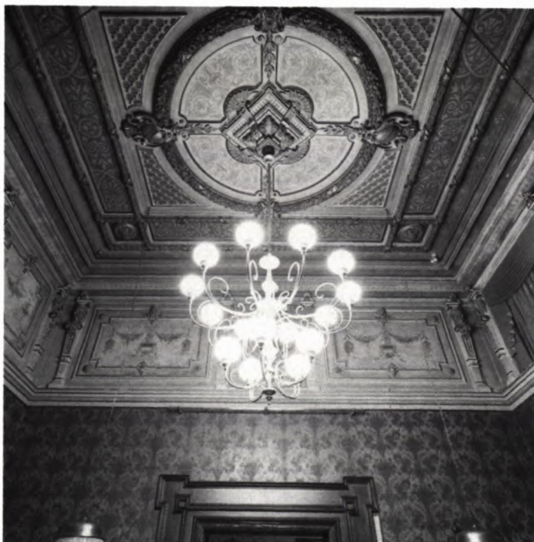
16 FÜRSTLICHER WARTERAUM, 1988; Blick nach Osten auf die Stuckierung des Deckenbereichs.
