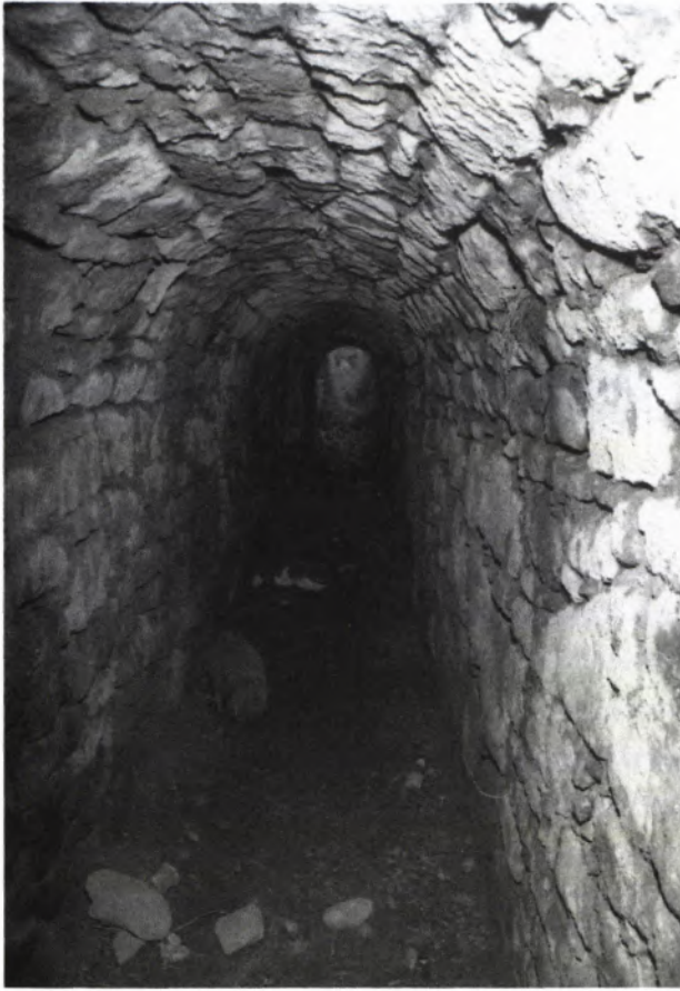
3 GEWÖLBE des Pirschganges vor der Sanierung von 1986.
