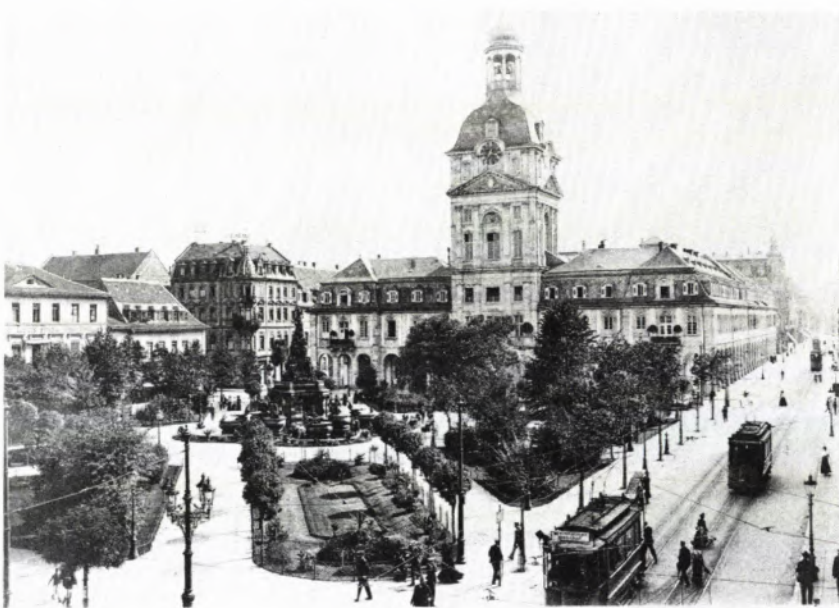
12 PARADEPLATZ und ehem. Kaufhaus 1895, Grünanlage mit zwei- bis viergeschossiger Randbebauung, rechts im Hintergrund das Schloß.
