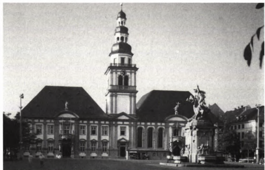
10 ALTES RATHAUS/SEBASTIANSKIRCHE, die beim Wiederaufbau eingeführte Fußgängerpassage ist wieder geschlossen und die historische Farbigkeit wiederhergestellt , Zustand 1987.
