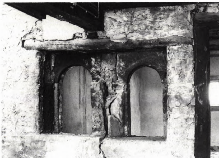
17 BLICK von innen auf das romanische Doppelfenster im 2. Obergeschoß (Südwand). Über der Fensternische der aus drei Holzbalken bestehende Sturz.
