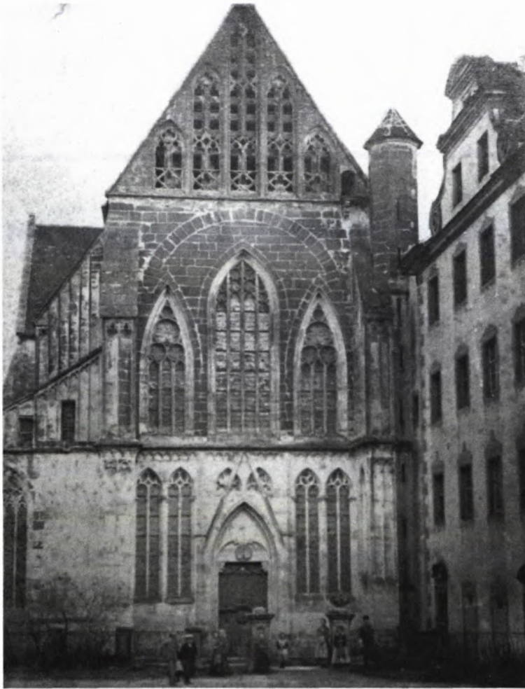
6 WESTFASSADE. Anonyme Photographie um 1870/80. Deutlich zu sehen sind die originalen Maßwerke der Blendfenster, der Wimperg über dem Westportal und die reichen Blattkapitelle im unteren Fassadengeschöß.
