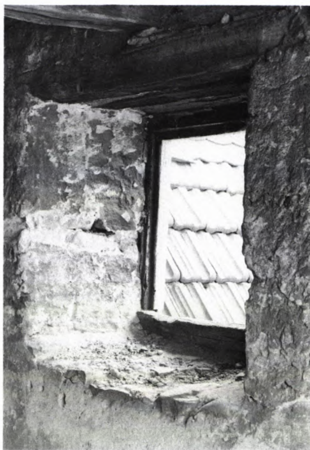
19 INNENANSICHT des Fensters mit Holzgewände auf der Westseite des Steinhauses im 2. Obergeschoß.
