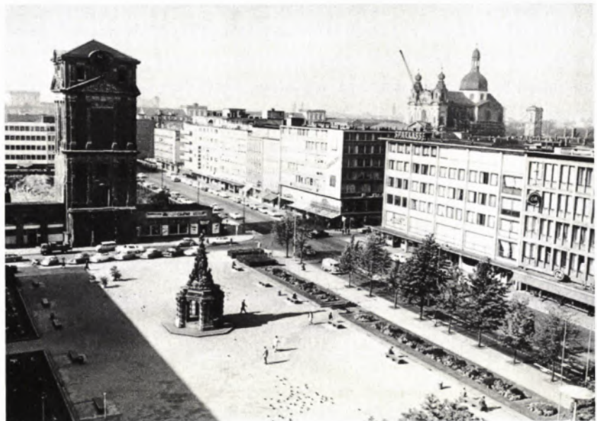
14 GESICHERTE Turmruine des ehem. Kaufhauses, Randbebauung mit fünf- bis sechsgeschossigen Bürohäusern, Zustand um 1964.
