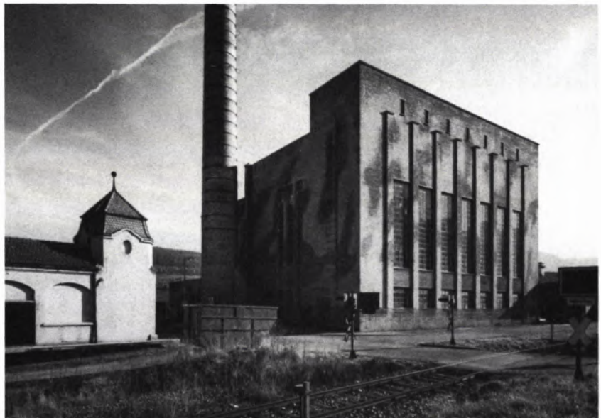
7 EHEM. KESSELHAUS der Baum- wollspinnerei und -weberei Eisenlohr von 1927.
