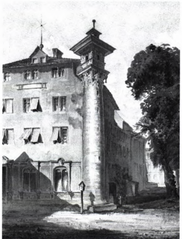
18 STUTTGART, ALTE KANZLEI, dorische Säule von 1598 mit Wasserkasten. Aquarell von 1865.
