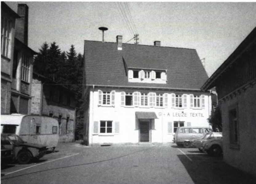
8 BAD URACH, Kreis Reutlingen. Ehem. Baumwollspinnerei Leuze, Fabrikanlage ab 1852. Auf dem Gelände steht noch die ehem. Mühle des 17./18. Jahrhunderts.
