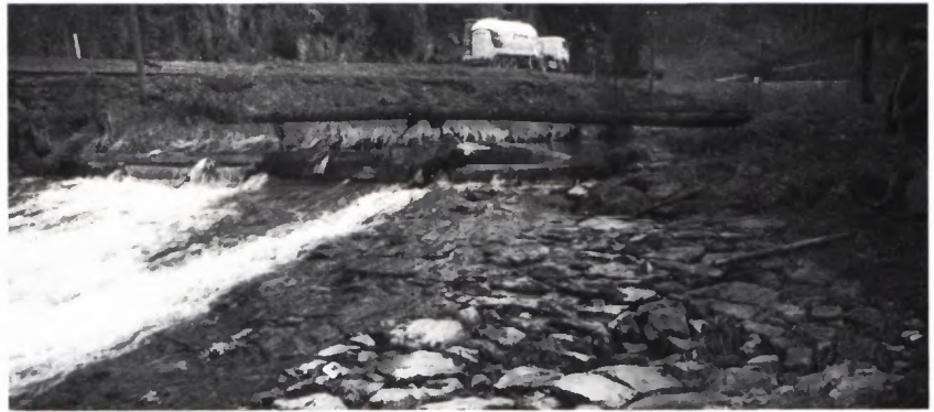
14 FLÖSSERWEHR auf der Schiltach, 1982 noch gut erhalten mit der Staustufe und dem Gamper, einem mächtigen Baumstamm, an dem das Brett zum Verschießen des Fahrloches hing; mittlerweile durch Hochwasser zerstört.
