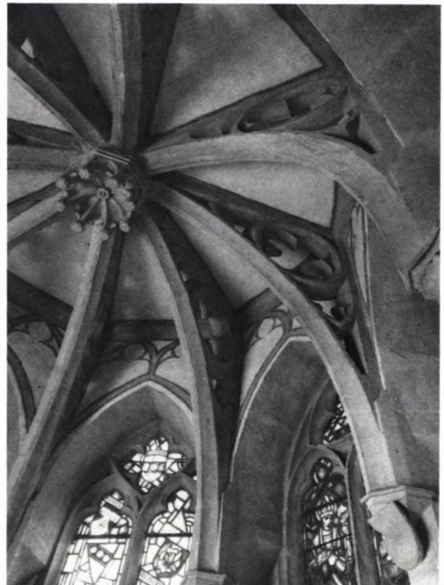
7 GEWÖLBEZONE (um 1400) der Brückenskapelle St. Nikolaus in Calw.
