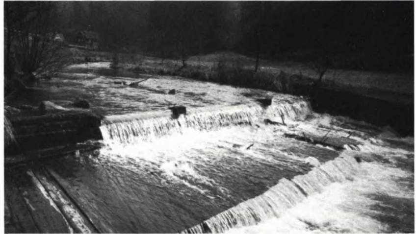
15 RESTE EINES WEHRS auf der Schiltach (Foto 1982). Man sieht hier noch deutlich die Durchfahrt für das Floß und den bohlenbelegten Anfang der Floßfahrt.
