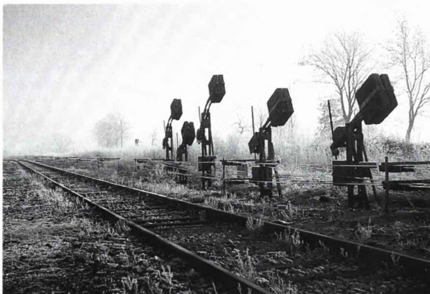
5 SPANNWERKE bei Hochdorf, Kreis Freudenstadt (Foto 1979).
