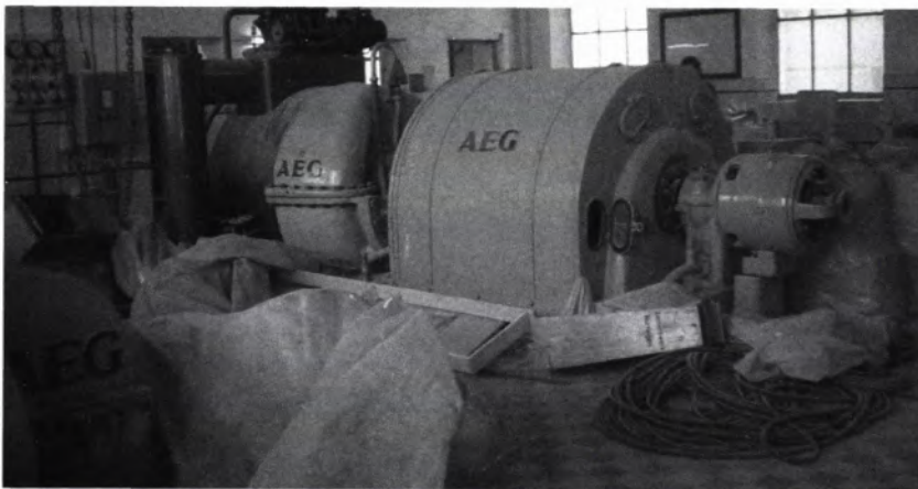
1 AEG-TURBOSATZ, Hochdruckseite mit Regelung aus einem Zementwerk, April 1979.
