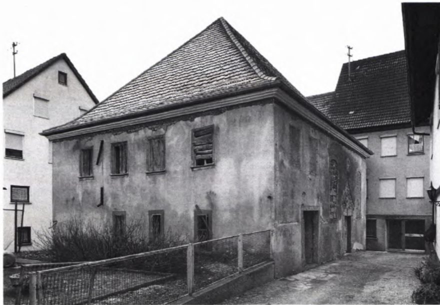
■ 7 Das Äußere von Nordwesten (1990).
