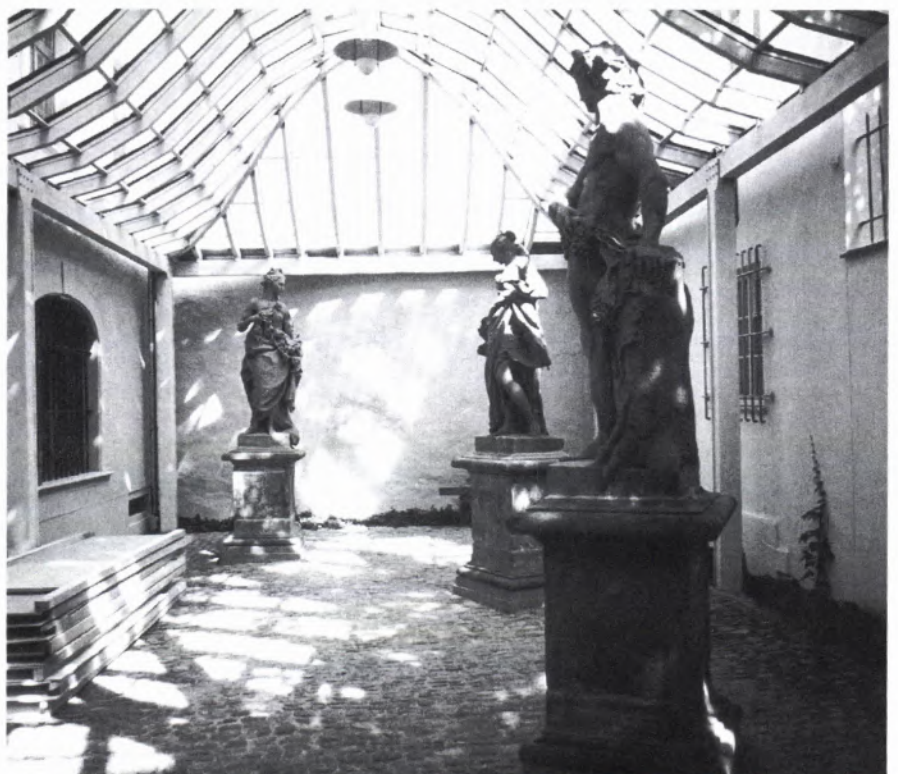
■ 19 Die Originale von Frühling, Sommer und Herbst kurz nach der Versetzung in den Hof des Wentzingerhauses. Die Stützen der Dachhaube sind selbsttragend und nicht im Mauerwerk des denkmalgeschützten Hauses verankert. Das Dachgerüst verursacht starke Schlagschatten auf den Statuen.
