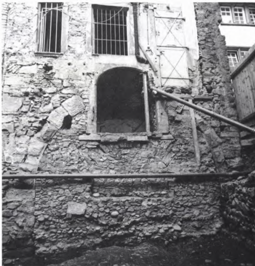
■ 12 Bossenquaderbogen in der Hoffassade des Vorderhaus. Er öffnet den gewölbten Kellerraum zum Hof.
