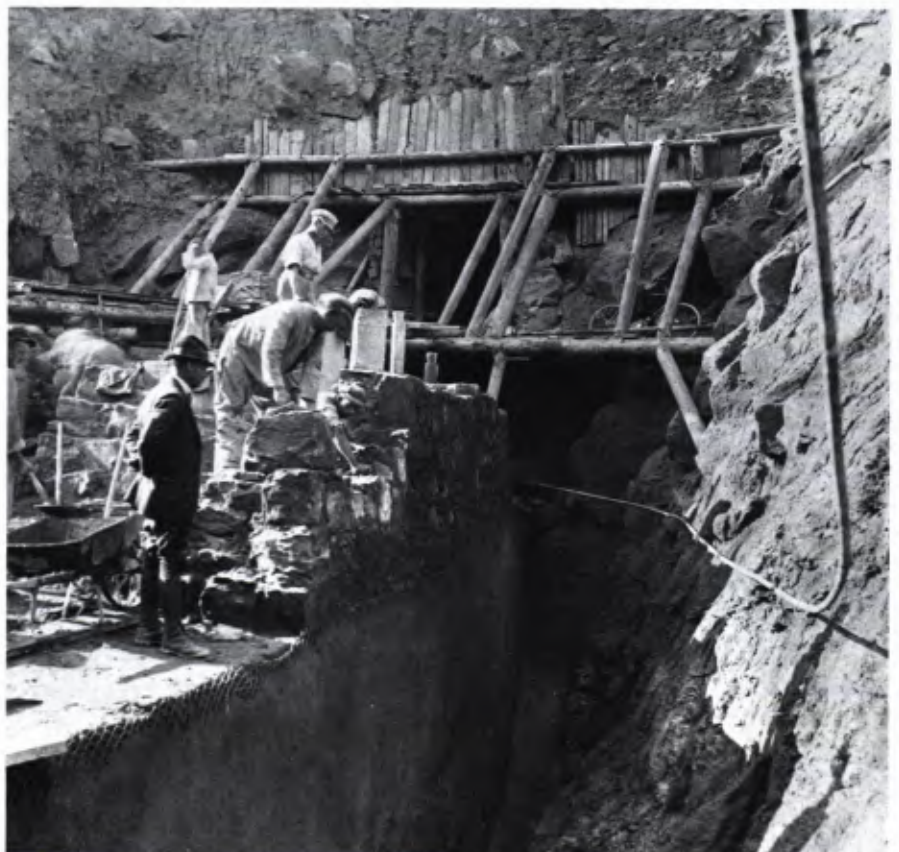
■ 13 Heimbach-Stauwand während der Bauzeit 1920, Luftseite.
