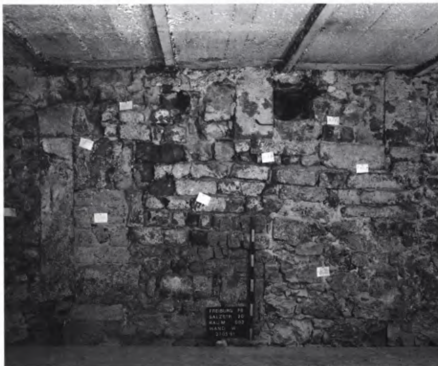
■ 9 Die südöstliche Quaderecke des Kernbaues (1127d) mit zugehörigem Kleinquadermauerwerk. Links ist die gegen die Ecke gesetzte Tür (1158d) zu erkennen und rechts oben die in die Mauer eingebrochene Tür (1183d).
