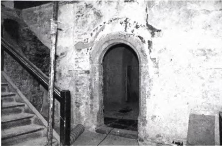
■ 20 Flur im 1. Obergeschoß, Raum 201, vor der Restaurierung.
