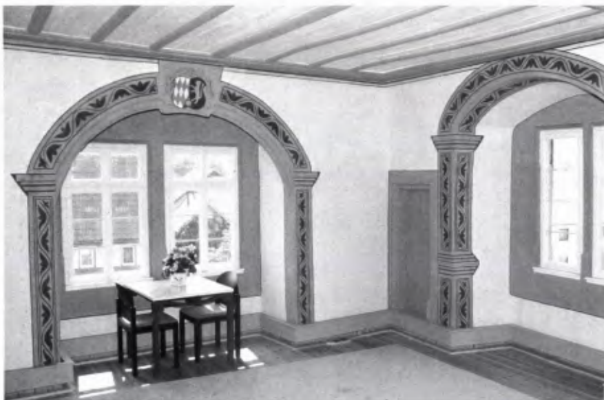
■ 11 Blick in die große Stube im 2. Obergeschoß, Raum 305, nach Süden. Der Schlußstein des Bogensturzes der großen Fensternische trägt ein spiegelverkehrtes kurpfälzisches Wappen. Decken und Innenwände waren mit Holz getäfelt. In der Raumecke befindet sich der Zugang zum nicht mehr vorhandenen Wehrgang.
