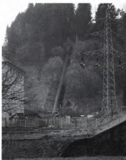
■ 3 Wasserschloß mit Druckrohr (Kraftwerk Bettenhausen).
