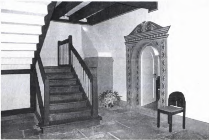
■ 12 Der Flur im 1. Obergeschoß, Raum 201. Aus der Umbaumaßnahme im Jahr 1529 stammt die Massivwand mit Rundbogenportal und Kamin.
