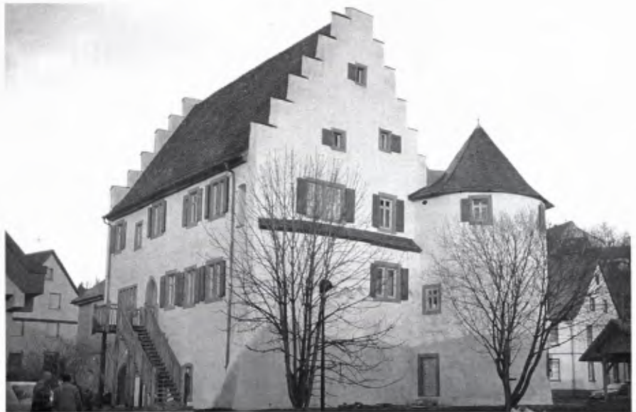
■ 1 Ansicht von Schloß Dallau, Südfassade.
