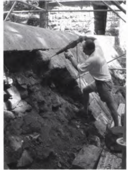
■ 11 Heimbach-Staumauer während der Sanierungsarbeiten 1995.
