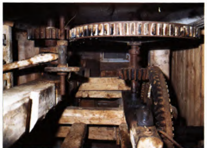
Zum Michelshof in Titisee-Neustadt, der 1917 abgebrannt ist, gehörte die ca. 200 Jahre alte Mühle. Mit ihr wurde eine Drahtseiltransmission für den ca. 300 m entfernten Hof betrieben. Große Teile der maschinellen Ausstattung sind noch vorhanden. Die Mühle soll daher als Anschauungsobjekt erhalten werden.
