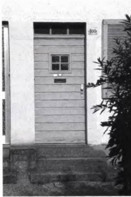
■ 14 und 15 Die ursprünglichen Türen sind oft noch erhalten: Baugruppe an der Körner- und Kleiststraße; Bauhöferstraße.
