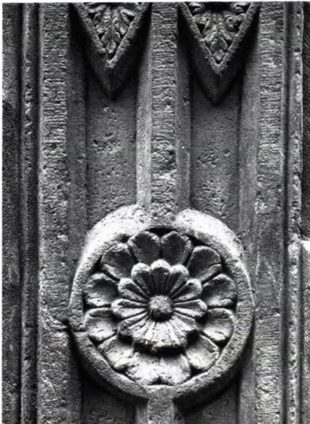
DETAIL VOM RELIEFSCHMUCK AUF DER STIRNSEITE DES MITTLEREN ARKADENPFEILERS VON HAUS NR. 33.
