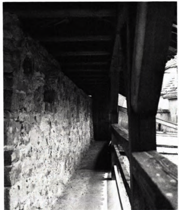
BLICK IN DEN ERNEUERTEN WEHRGANG. Bei der Rekonstruktion des Wehrganges über der 1963 verstürzten Stadtmauerpartie wurden die überlieferten Maße und Materialien zum Vorbild genommen. Über eine Treppe ist der Wehrgang auch vom Maueräußeren her zugänglich.
