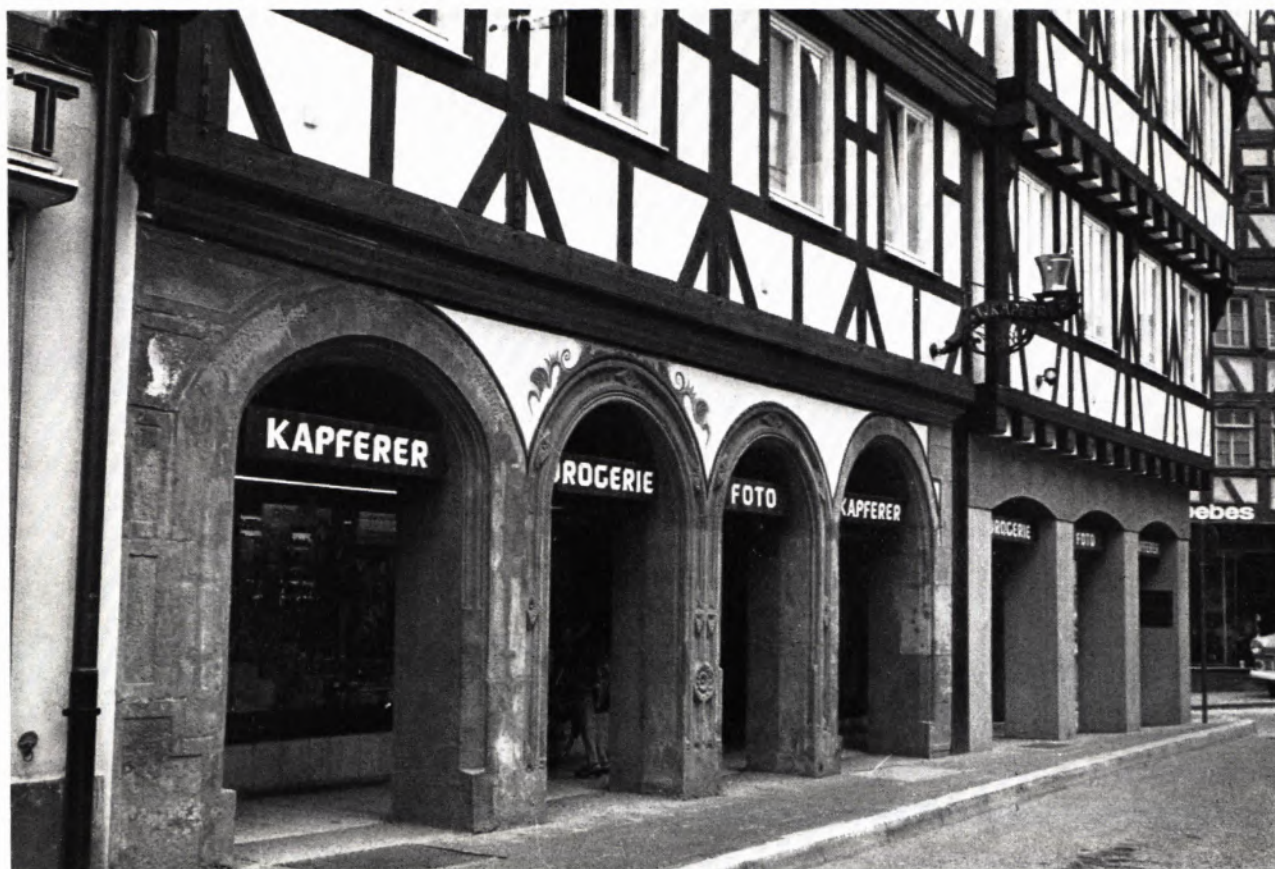
DAS ARKADENGESCHOSS NACH DEM UMBAU VON 1968. Bei Gebäude Nr. 33 (vorne) wurden die alten, über massiven Pfeilern ruhenden Bogenöffnungen belassen, gegen die sich die neue Arkatur an Gebäude Nr. 35 in Material und Form bewußt absetzt.
