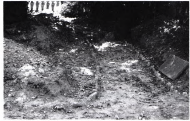
7 MATHILDENGARTEN. Zur Südostecke hinaufführende Rampe.
