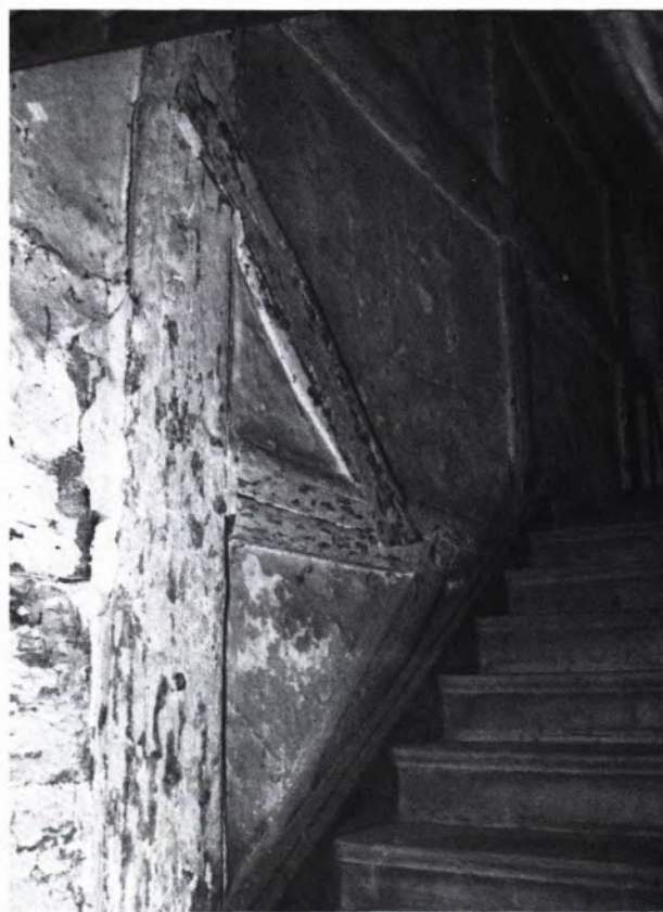
9 GIEBELWAND eines Hauses in der Wessenbergstraße mit innen sichtbarer verblatteter Konstruktion ähnlich wie Abb. 8.
