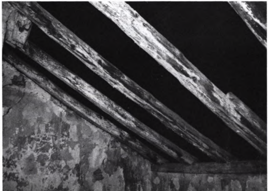
15 PULTDACHSTUHL eines Turmelementes im hinteren Parzellenbereich an der Rosgartenstraße. Dendrochronologische Altersbestimmung steht noch aus.
