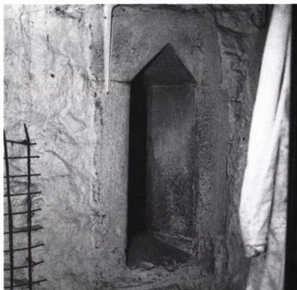
5 FENSTERGEWÄNDE des 13. Jahrhunderts im Kellergeschoß eines barock umgestalteten Baus an der Gerichtsgasse.
