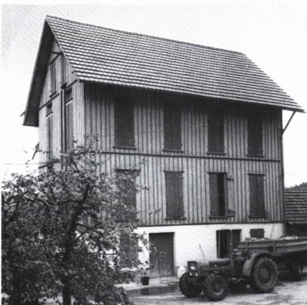
2 „HOPFENDARRE“ des Hofguts Schwanden bei Tett nang aus dem Jahre 1898. Beispiel für ein landwirtschaftliches Gebäude dieser Art im Raum Tett nang. In der Region Bodensee-Oberschwaben ist die Bezeichnung Hopfendarre hierfür üblich, obwohl der Begriff „Darre“ im eigentlichen Sinne allein die Trocknungseinrichtung oder den Trockenraum meint.
