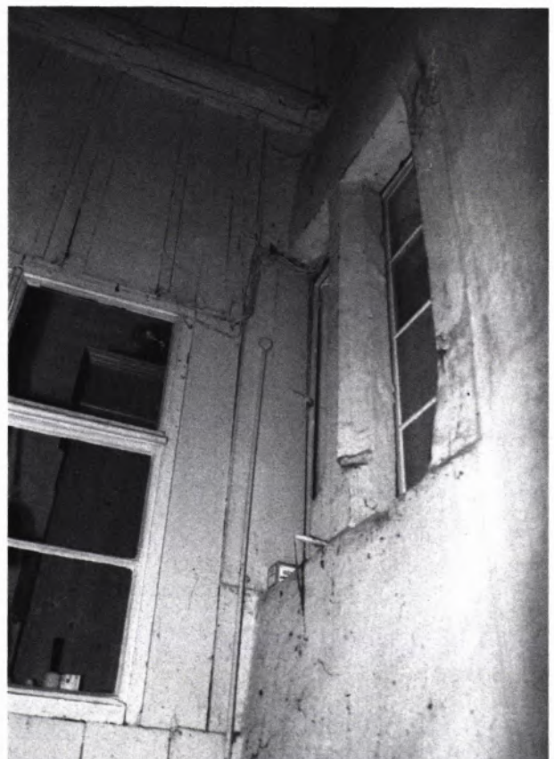
13 FENSTER eines Turmelementes an der Wessenbergstraße. Das Fenster öffnet sich zu einem engen Lichtschacht; der Turm wird von jüngeren mittelalterlichen Baustrukturen ummantelt.
