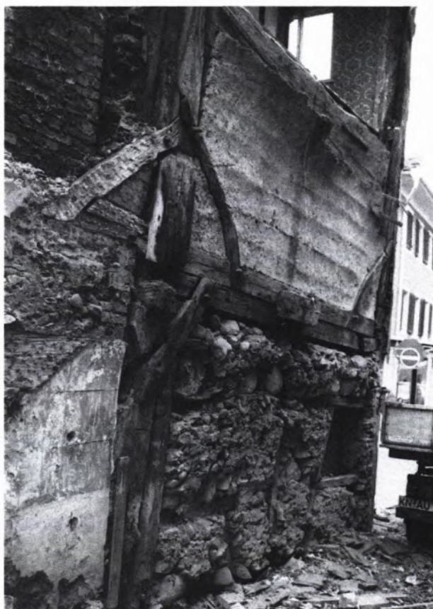
8 GIEBELWAND eines Hauses in der Kreuzlinger Straße mit Bohlen-Ständer-Konstruktion.
