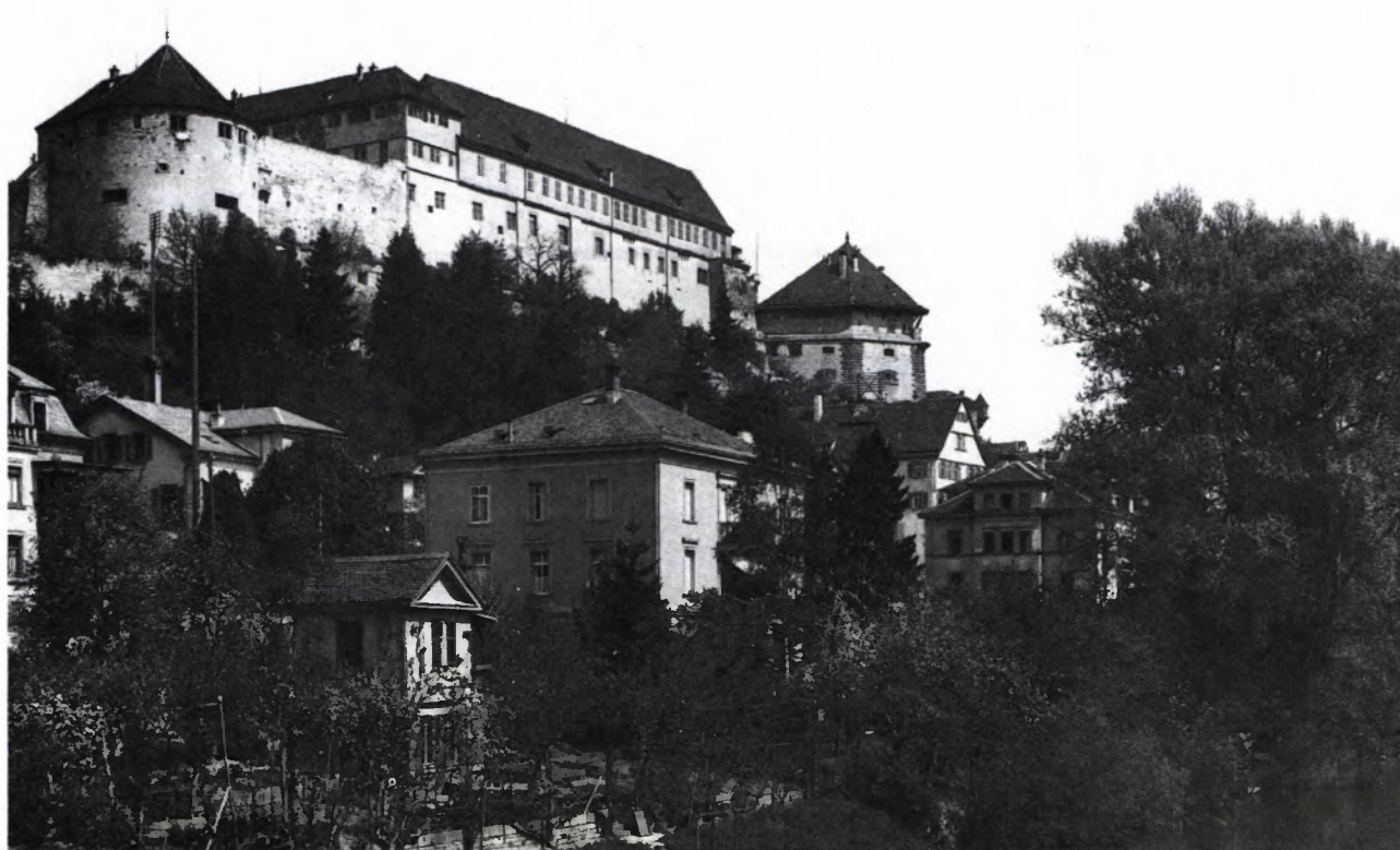
7 SÜDWESTANSICHT um 1930. Die gemalten Architekturrahmungen der Erdgeschoßfenster am Südflügel sind noch zu erkennen. Der um 1970 renovierte Rundturm links (Haspelturm) zeigt noch Verputz (heute steinsichtig).
