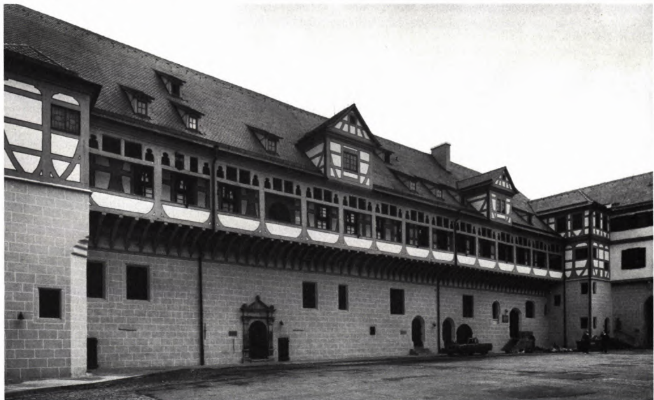
10 BLICK AUF DEN RENOVierten SÜDFLÜGEL mit seinem ockergelben Fachwerk und der gemalten Sockelquadrierung.
