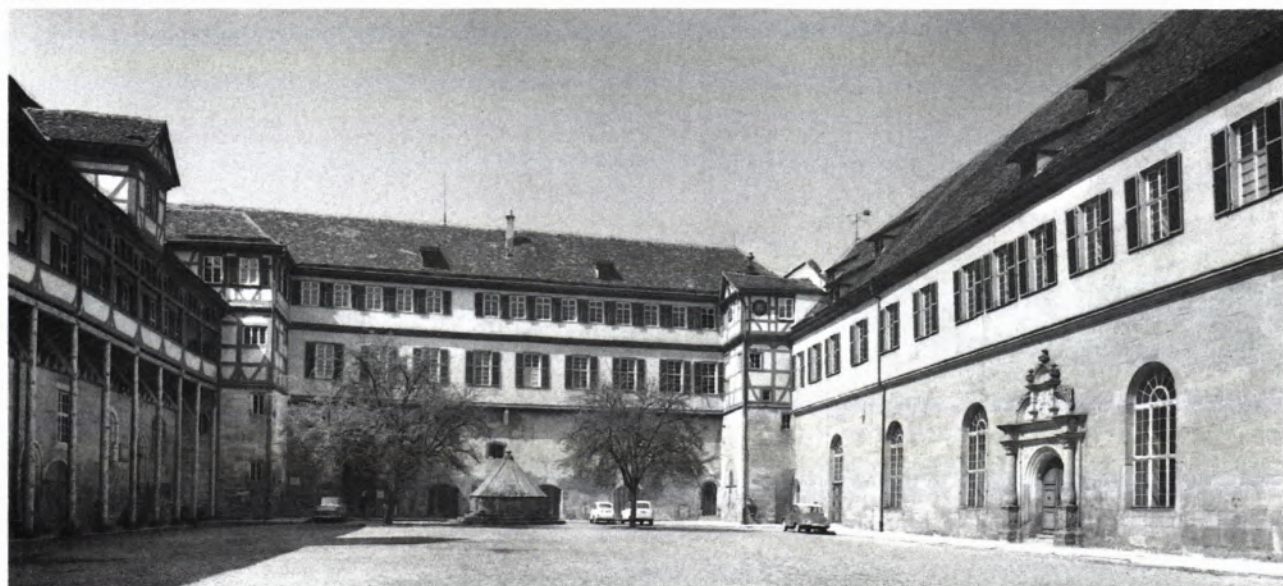
8 BLICK IN DEN SCHLOSSHOF nach Westen 1965. Die Südgalerie mußte bis zur jetzigen Instandsetzung wegen Einsturzgefahr abgestützt werden.
