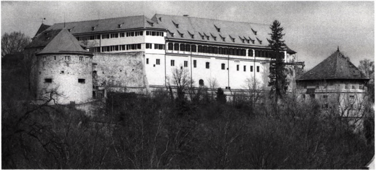
9 SÜDWESTANSICHT nach der Renovierung mit wieder freigelegtem Fachwerk.
