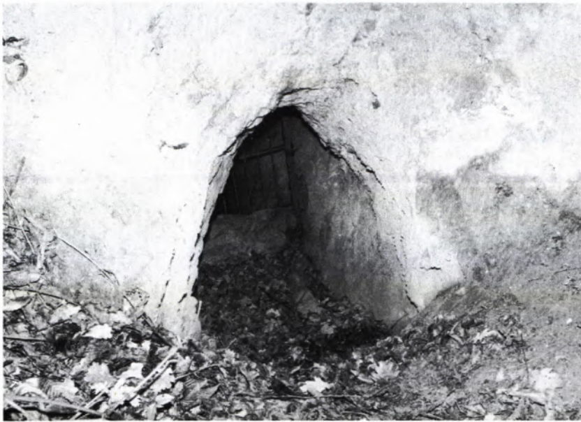
6 LUFTSCHACHT oder unteres Wetter des Bergwerks in Schriesheim, Rhein-Neckar-Kreis. Bis zur Freilegung des Stollenmundlochs war dies der mögliche Zugang in den Berg.
