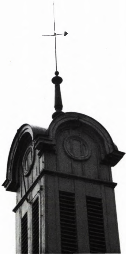
11 REILINGEN (Rhein-Neckar-Kreis), Rathaus. Auf dem Dachreiter befindet sich noch der historische Blitzableiter mit Nordpfeil.
