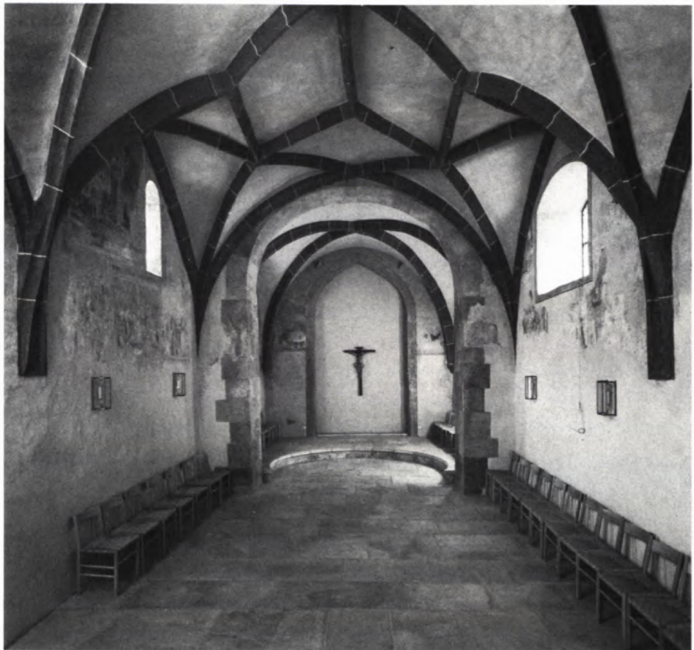
6 NIKOLAUSKAPELLE nach der Instandsetzung (1983). Die romanische Apsis ist im Fußboden des Chors zu erkennen.
