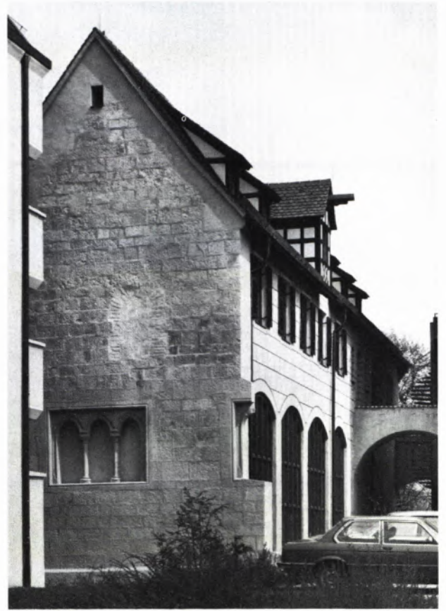
8 WESTWAND des Steinhauses 1983. Das Drillingsfenster konnte bis auf die Kapitelle rekonstruiert werden.
