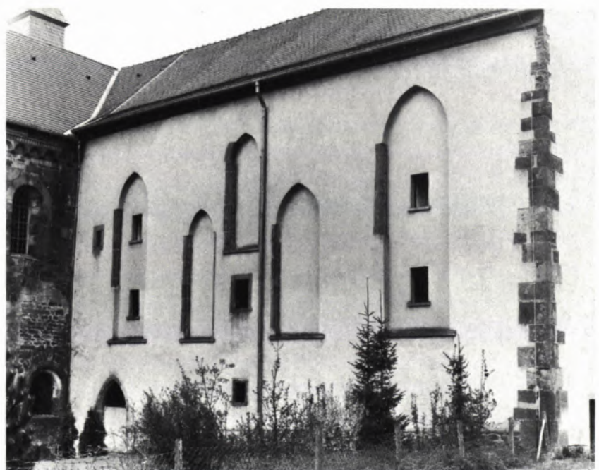
7 NORDWAND des Langhauses mit den Resten der Fenster aus Periode II und III. Zustand 1979.
