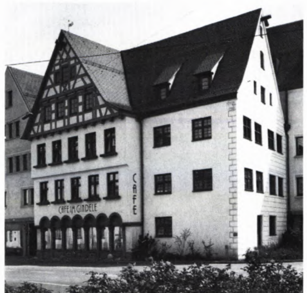
17 FASSADE von „Gindele-Nord“ mit wiederverwendetem Giebelfachwerk und „Gindele-West“, 1983.
