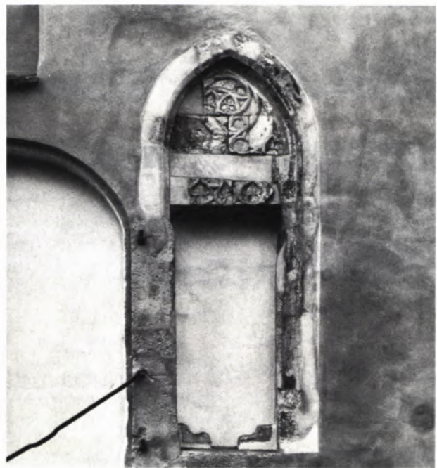
6 BEI DER RESTAURIERUNG der Chorostwand wurde eine gotische Tür mit Blendmaßwerk freigelegt.
