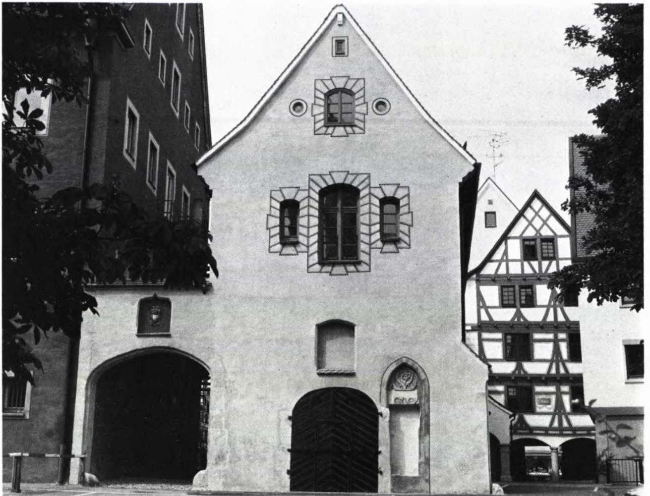
1 CHORANSICHT der Nikolauskapelle. Das obere Stockwerk wurde später aufgesetzt. Das Scheunentor stammt aus der Zeit der Nutzung als Kalk- und Sandstadel. Rechts Durchblick auf den Fachwerk-Zwischenbau von 1598 mit neu hinzugefügtem 3. Obergeschoß und Giebel.
