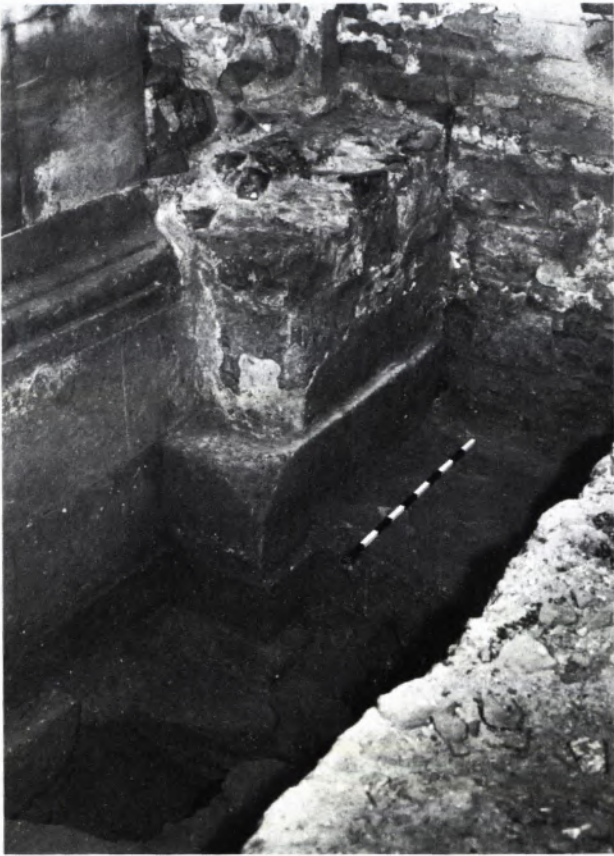
3 ANSATZ der südlichen Langhausarkade (um 1160) mit jüngerem Ausbruch und stehender Langhauswand.
