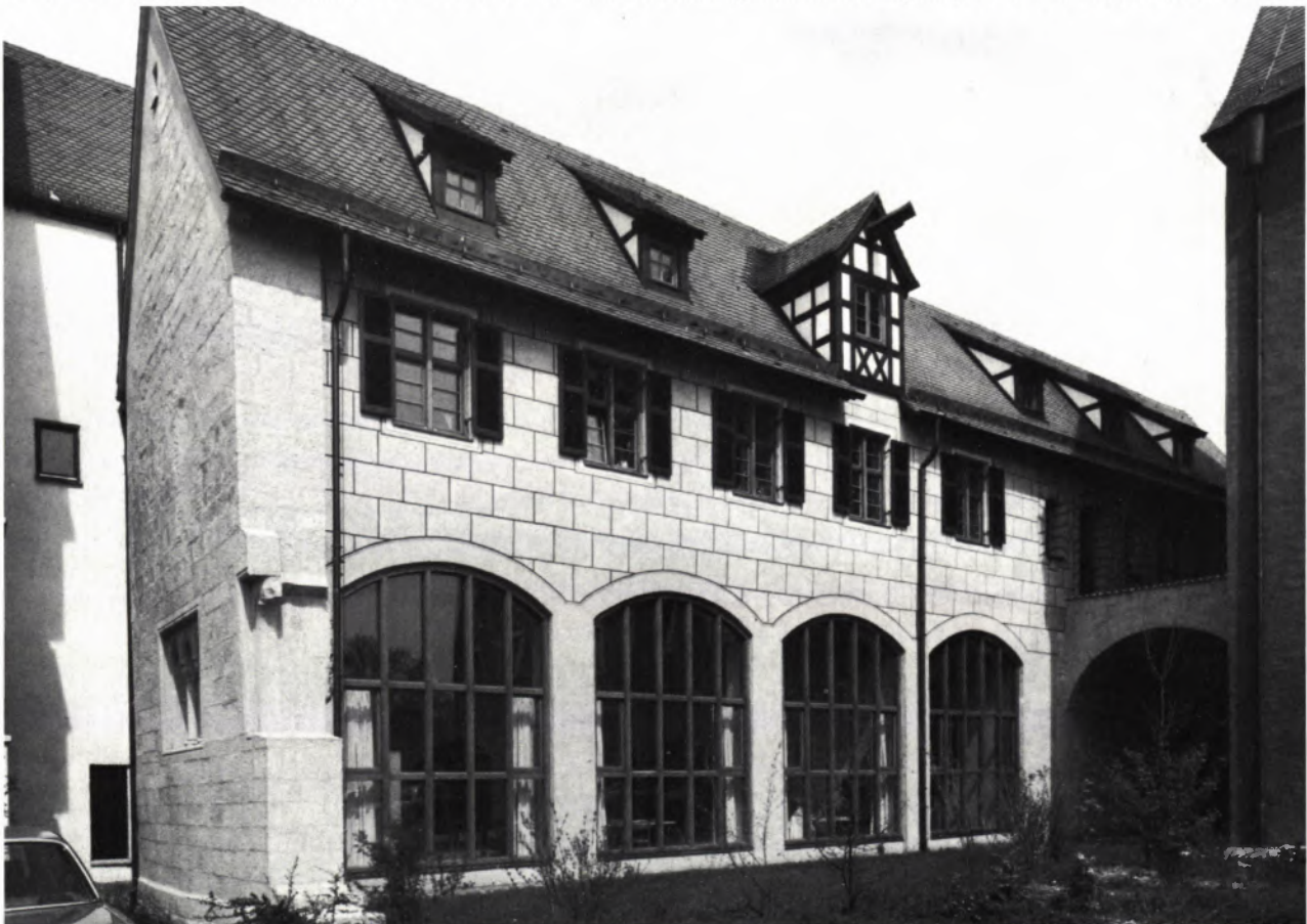
10 DIE SÜDWAND des Steinhauses 1983: Die aus der Scheunennutzung stammenden Öffnungen wurden wiederhergestellt.
