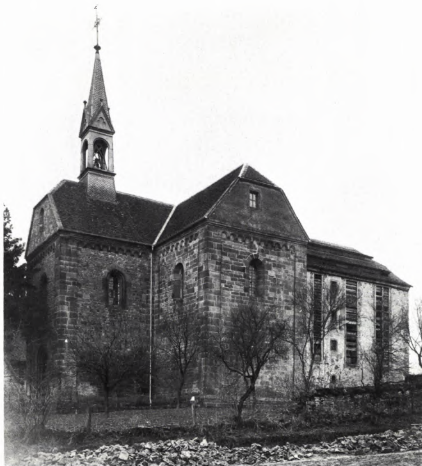
2 KLOSTERKIRCHE Lobensfeld von Nordosten. Am Langhaus sind deutlich die großen Öffnungen für die Nutzung als Tabakscheuer zu erkennen. Zustand um 1900.
