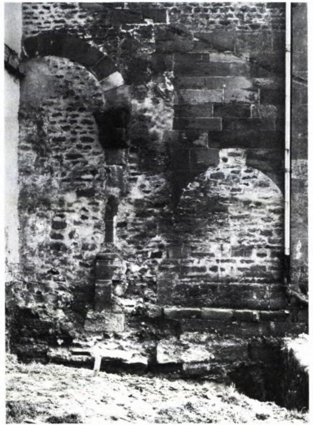
4 SÜDLICHE Querhauswand mit Ansatz des Seitenschiffes und vermauertem Zugang zum Kreuzgang (1974).
