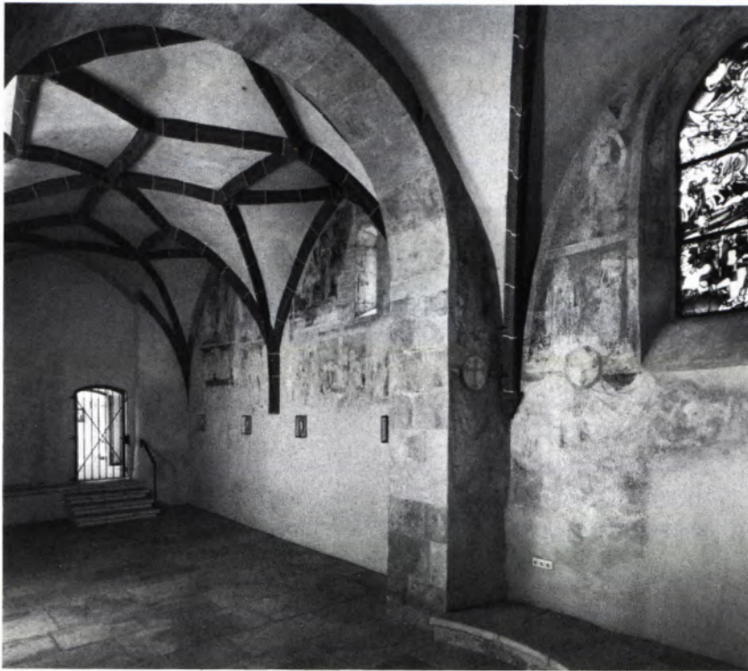
11 NORDWAND des Schiffs der Nikolauskapelle nach der Sanierung, 1983.
