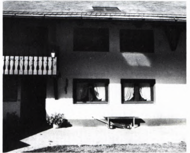
6 AUFGEMAUERTER Wohnteil und untypische breitrechteckige Fenster mit großflächigen Scheiben am gleichen Hof (1983).
