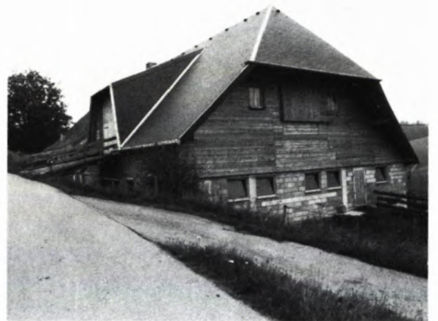
8 STALLTEIL dieses Hofes (1983) mit Krüppelwalmdach und Asbest-Zement-Schieferdeckung.
