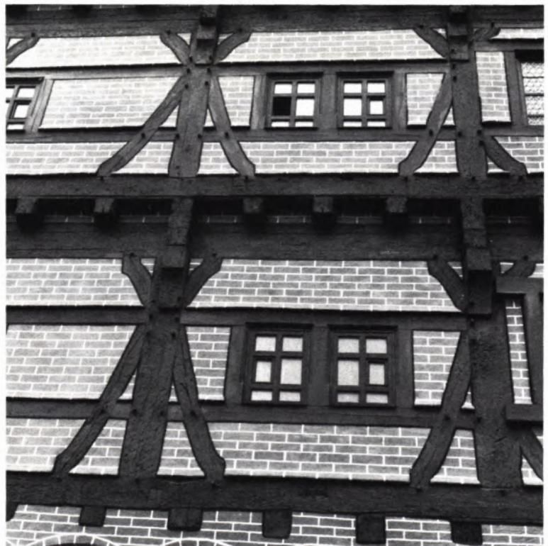
6 FASSADENAUSSCHNITT mit aufgemalter Ziegelausfachung. Über den horizontalen Hölzern (Schwellen und Riegeln) ist der zum Schutz dieser Hölzer dienende vorspringende Formstein sichtbar.
