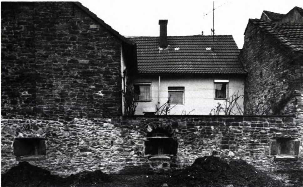
14 ZWINGERMAUER mit Schießscharten im Bereich hinter Jägerstr. 58 (von Norden).
