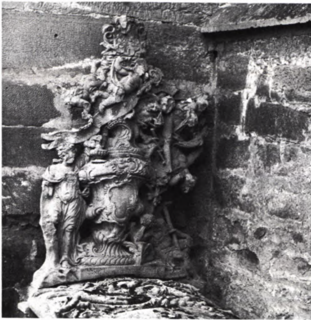
17 und 18 ÖHRINGEN, Grabmal des 18. Jh. bei der St.-Anna-Kapelle; Foto 1982. In der Frontalansicht kann der Eindruck entstehen, als seien die zahlreichen Beschädigungen des figurenreichen Aufbaus am Kopfende der Tumba durch gewaltsames Abschlagen verursacht. In der Seitenansicht wird deutlich, daß die Substanzverluste durch die starken Aufspaltungen des Sandsteins bedingt sind.
