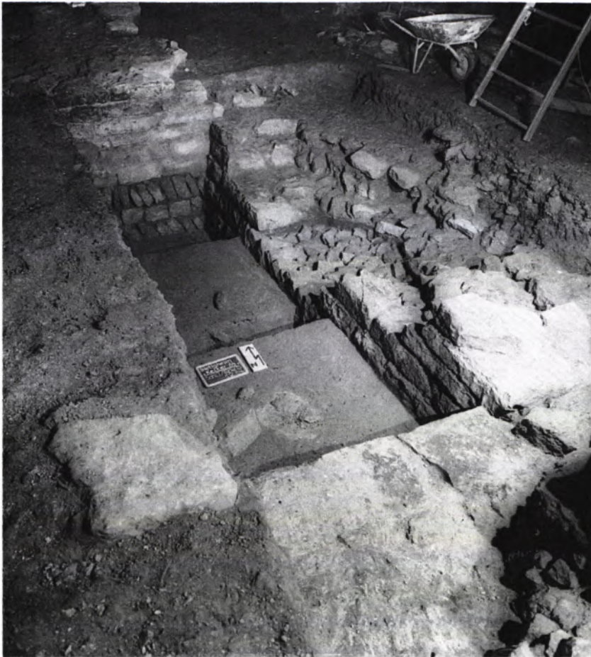
5 NORDOSTECKE im Innern des Wehrturmes. Im Fundamentbereich, der aus unvermörteltem Mauerwerk besteht, wechseln Schichten im Läuferverband mit Rollschichten.
