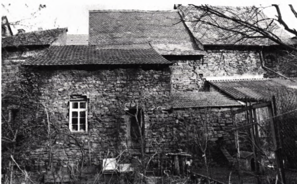
13 ZWINGERMAUER und Stadtmauer im Bereich hinter der Kelterstrasse westlich des Basler Tores. Die Rückwand des Schuppens im Vordergrund besteht aus der Zwingermauer (Kelterstr. 30), die Stadtmauer dient als Rückwand der dahinterliegenden Scheunen. Graben weitgehend aufgeschüttet (Blick von Süden).
