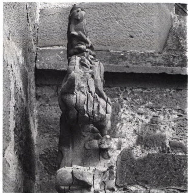
17 und 18 ÖHRINGEN, Grabmal des 18. Jh. bei der St.-Anna-Kapelle; Foto 1982. In der Frontalansicht kann der Eindruck entstehen, als seien die zahlreichen Beschädigungen des figurenreichen Aufbaus am Kopfende der Tumba durch gewaltsames Abschlagen verursacht. In der Seitenansicht wird deutlich, daß die Substanzverluste durch die starken Aufspaltungen des Sandsteins bedingt sind.
