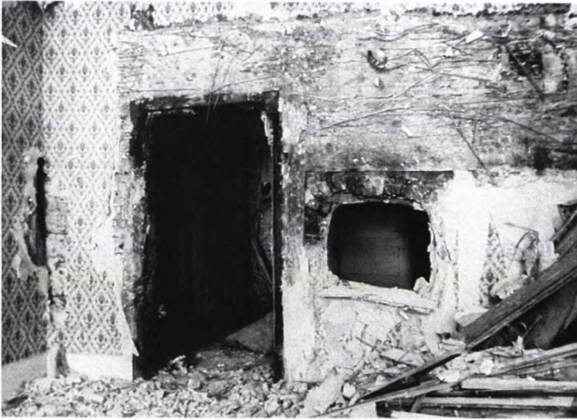
10 ESSLINGEN, OTTILIENPLATZ 9 (um 1395 datiert). Aus den Bohlen geschnittene Hinterladeröffnung.
