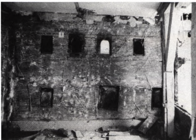
13 ESSLINGEN, HAFENMARKT 6/8 (1331 datiert). In Bohlenwand eingeschnittene Fensteröffnung (13. Jh.?).
