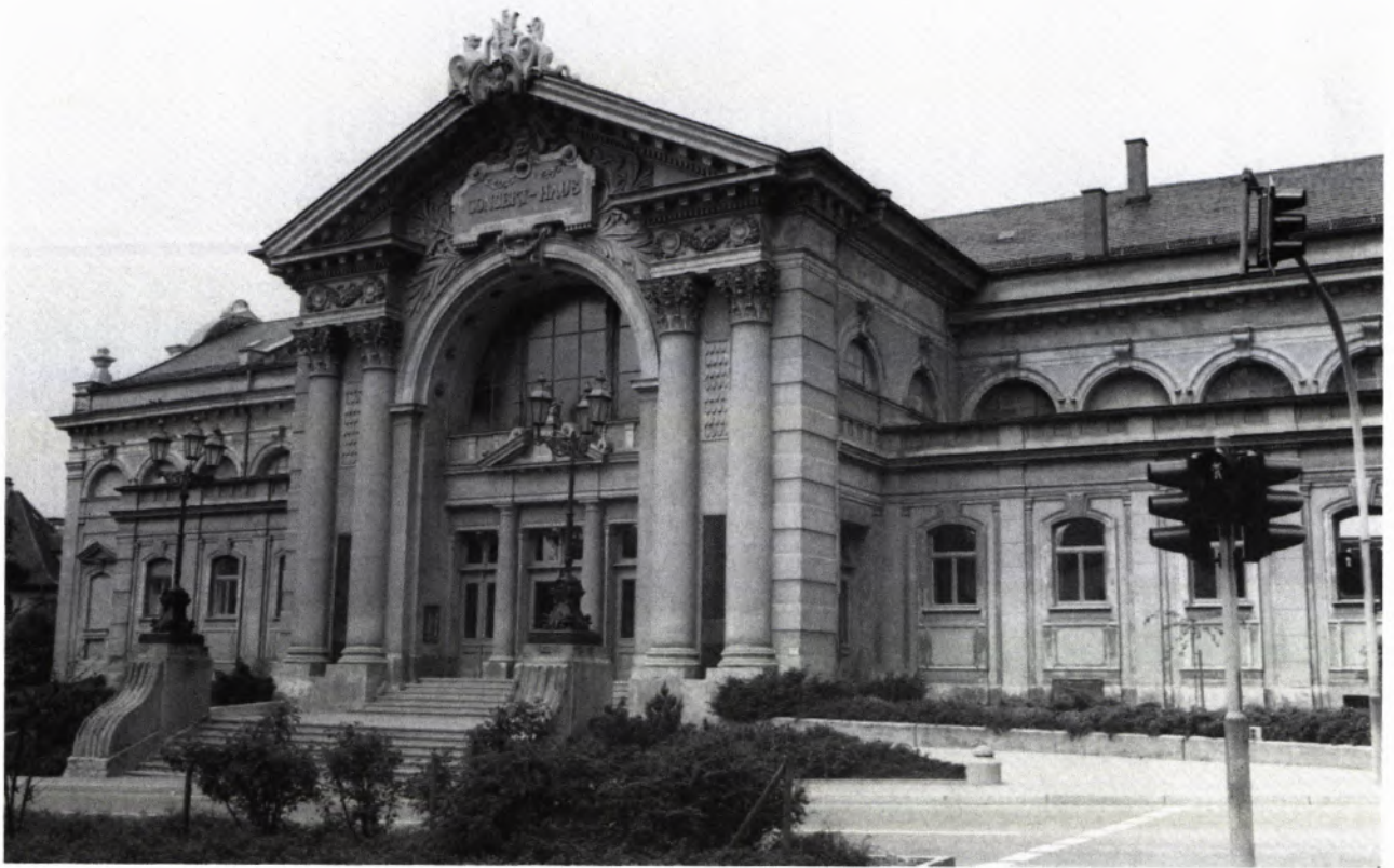
2 HEUTIGE ZUGANGS- UND EINGANGSSITUATION.
