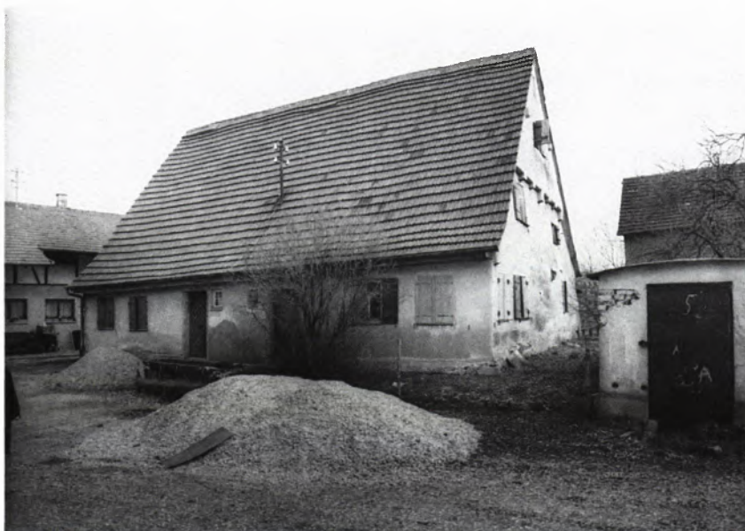
1 HAUS FREITAGSHOF 11 vor der Untersuchung 1981 von der Westseite.
