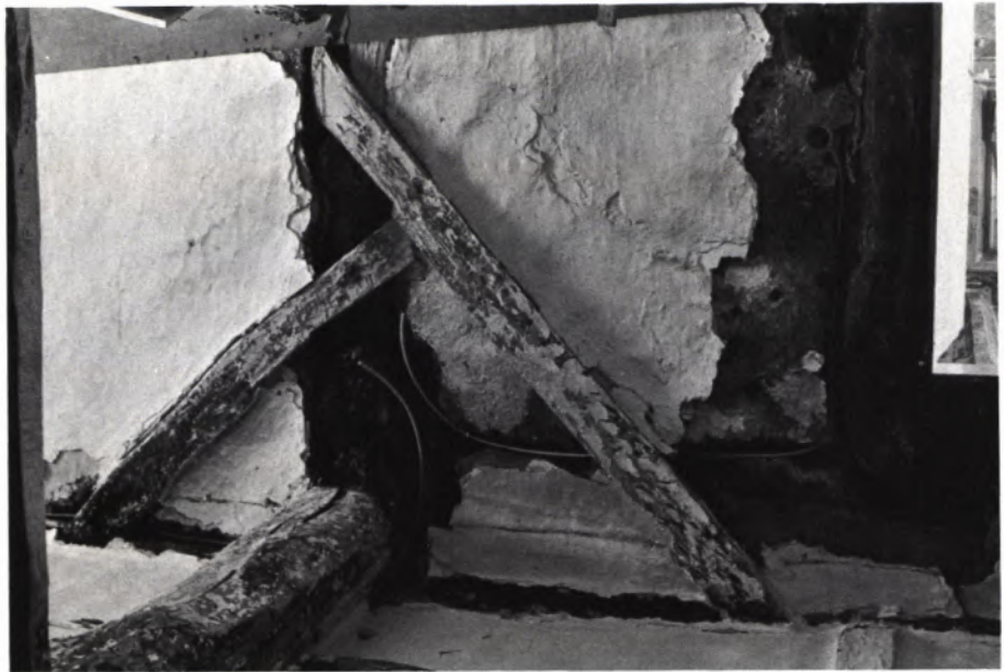
7 KOPFZONIGE AUSSTEIFUNG des mittleren Bundständers (Querachse II), Obertorstraße 74. Die relativ flache Neigung der Gefügehölzer ist ein typisches Merkmal der frühen Fachwerkbauten im 14. Jh.
