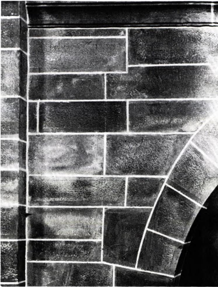
VERZÄHNUNG DES QUADERMAUERWERKS VON ARKADENWAND UND CHORBOGEN. Der Bau der jetzigen Kirche muß bald nach seinem Beginn um 1100 für längere Zeit ins Stocken geraten sein. Das wird unter anderem bewiesen auch durch die „unebene“ Verzahnung, mit welcher das Quaderwerk der (späteren) Arkadenmauer des Schiffes an die früher aufgeführte Chorbogenwand angeschlossen wurde.
