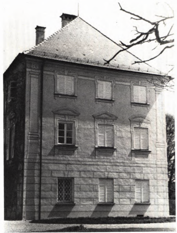
ARCHITECTURMALEREI AM SÜDLICHEN SEITENFLÜGEL VON NIEDERSTOTZINGEN. Die Grau in Grau gehaltene Malerei illusioniert täuschend die an anderen Gebäudeteilen (Abb. unten) in Stein gearbeiteten Architektur- und Zierglieder.
