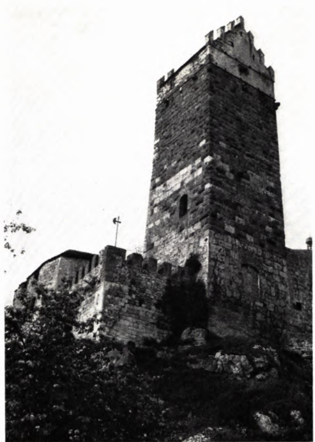
DER BERGFRIED VON KATZENSTEIN. Mit seinen fast zweieinhalb Meter starken Mauern ist der bald 17 Meter hohe Turm ein gewaltiges Bollwerk. Markant der Unterschied vom ebenflächigen Quaderbau des Sockels (10./11. Jh.) zum Buckelquadergemäuer staufischer Zeit (13. Jh.). Sechs Meter über Grund der rundbogige Einstieg. Der Dachaufsatz mit Zinnengiebeln 17. Jahrhundert.
