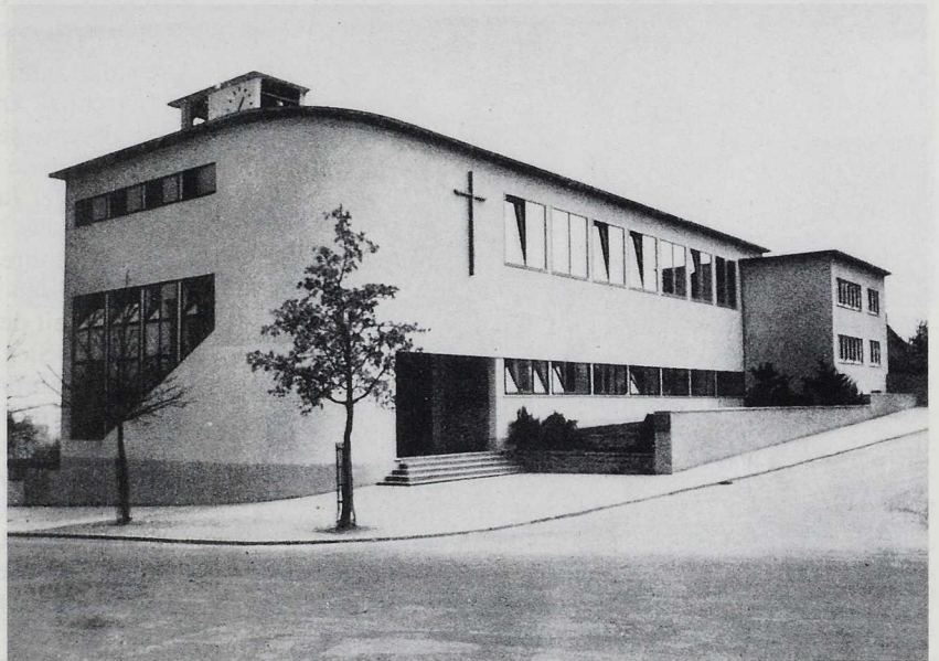
7 STUTTGART, ev. Brenzkirche in ihrer ursprünglichen Gestalt. Nach einem Wettbewerb im Jahre 1930 wurde der Bau 1932/33 von Alfred Daiber als Gemeindezentrum mit Kirchenraum, Gemeindesaal, Kindergarten und Wohnungen errichtet.
