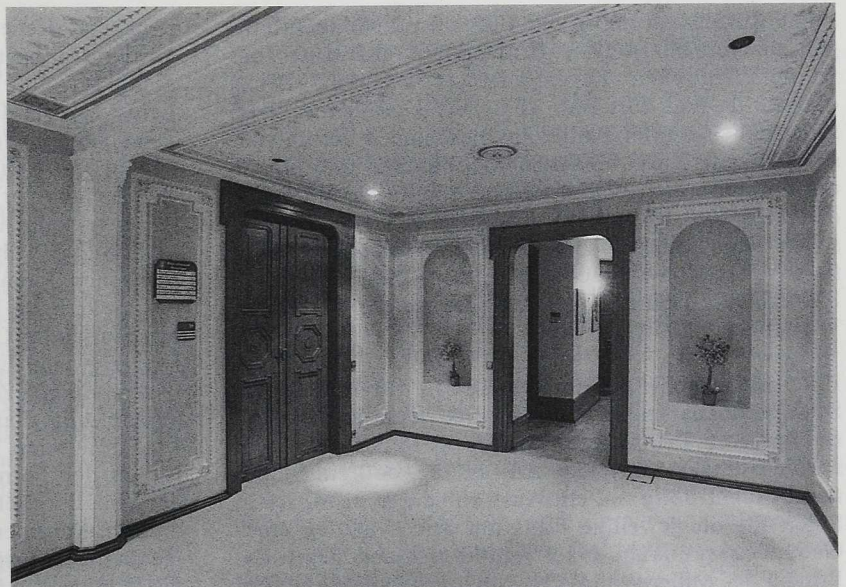
7 TREPPENHAUS 1985 instand gesetzt. Es präsentiert sich in der freigelegten und teilweise rekonstruierten Raumfassung einer zweiten Phase, die die kräftige Farbgebung der Leinsschen Gestaltung nicht mehr wiederholte.
