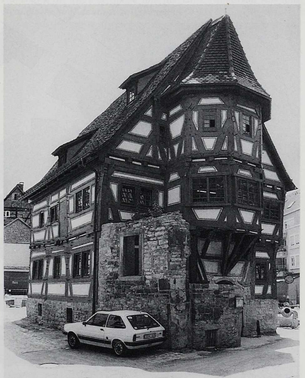
2 DIE GLEICHE ANSICHT 1984, die Bauteile des 19. Jh. sind entfernt: Anbau und seitliche Aufstockung.
