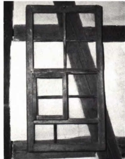
10 SCHIEBEFENSTER aus der Gegend um Rottweil (Innenseite). Dreizonig mit hochrechteckigem Schieber, unterschiedlichen Glasmaßen, wohl vor dem 18. Jh.
