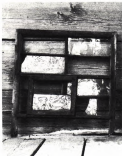
14 ALTES SCHIEBEFENSTER von den Gesindekammern im Obergeschoß des Unteren Gschwendhofs in Gütenbach bei Furtwangen aus dem 18. Jh.
