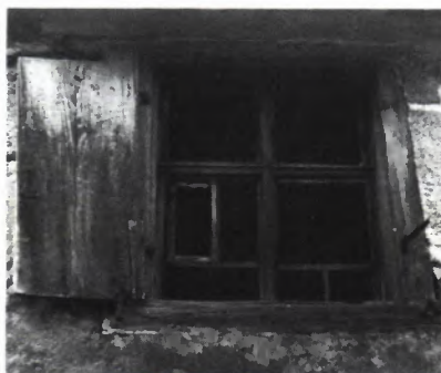
19 KREUZSTOCKFENSTER aus der Barockzeit mit Schieber im Drehflügel, die Sprossierung ist verloren. Aus Pfohren bei Donaueschingen.
