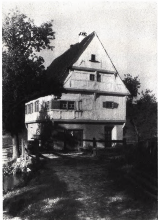
13 BAUERNHAUS bei Hayingen-Indelhausen bei Zwiefalten in einer Aufnahme um 1900. Das Gebäude des 16. Jh. hat noch Schiebefenster an der Eckstube. Die Übertünchung des Fachwerks geht auf die Zeit um 1800 zurück (vgl. Heft 1/80 dieser Zeitschrift).
