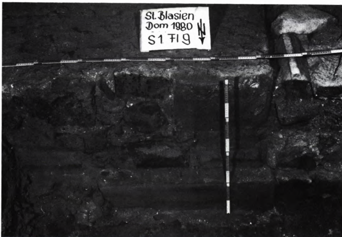
9 ARKADENWAND zwischen Mittel- und Südseitenschiff von Norden gesehen. Rechts die nachträglich vermauerte erste Arkade im zweiten Joch mit dem gotischen Gewölberippenfragment. Links daneben die teilweise durch Feuer beschädigten Quader der Pfeilerstirn.
