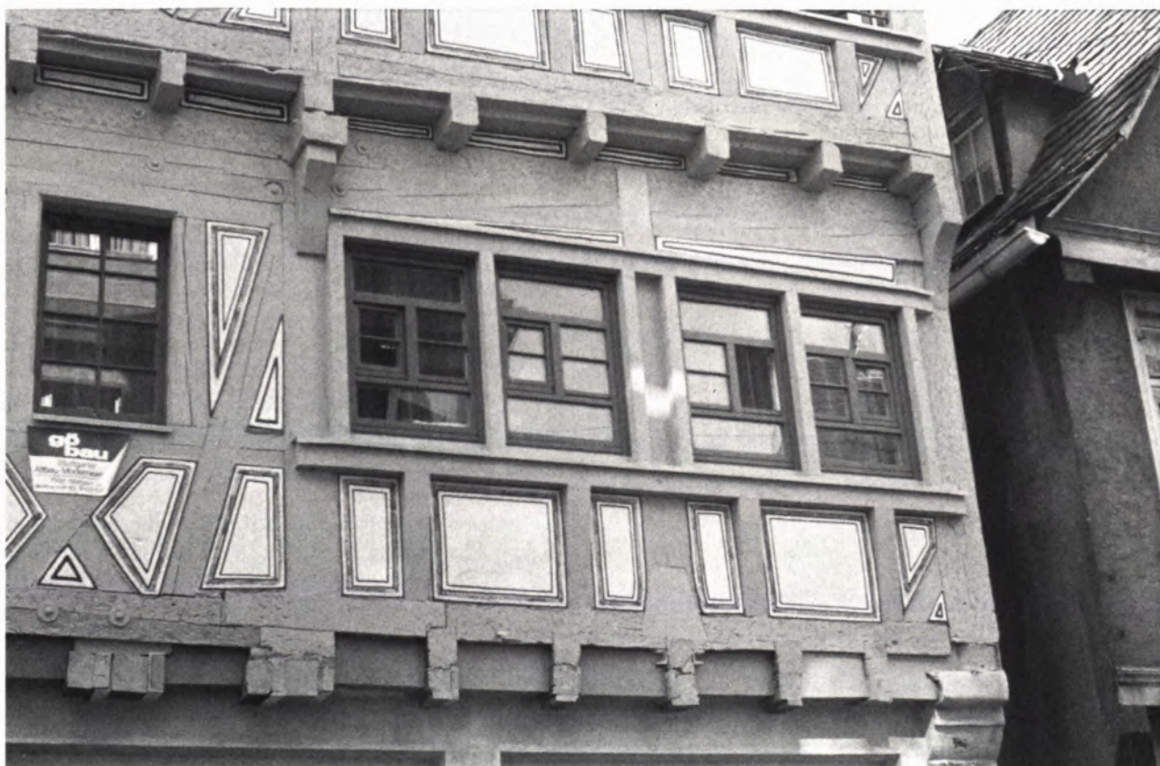
26 REKONSTRUKTIONSKOMPROMISS vorbarocker Fenster mit kleinem Drehflügel. Stuttgart-Bad Cannstatt, Sulzbachgasse 16.
