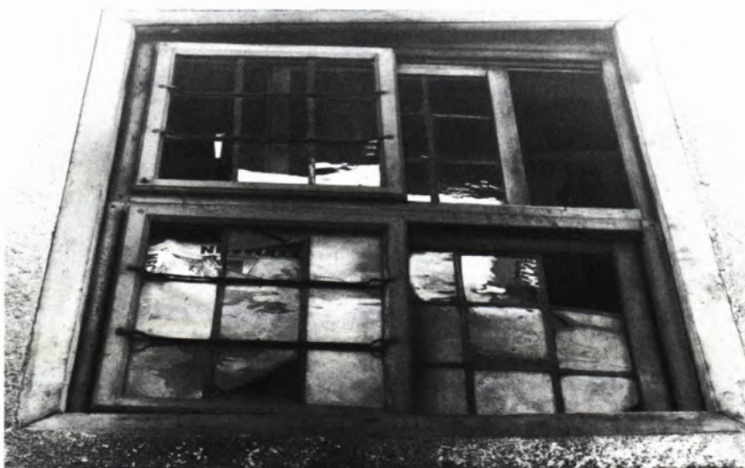
12 TREPPENHAUSENFENSTER in einem Haus bei der Unteren Herrengasse in Schwäbisch Hall, wohl aus der Barockzeit. Bleiverglasung mit Windeisen, zweimal zwei gegeneinander verschiebbare Schieber.
