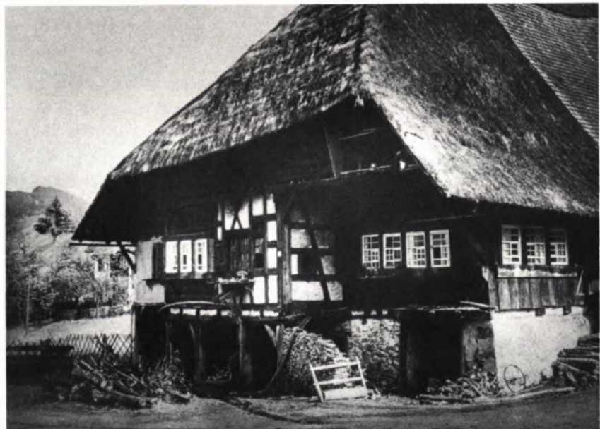
I DIE ALTEN SCHIEBEFENSTER an den Eckstuben sind bei dem Schwarzwälder Bauernhaus (bei Gutach/Kinzigtal) deutlich erkennbar. Die Aufnahme entstand um 1900.
