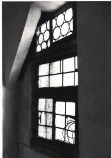
9 SCHIEBEFENSTER in Nürtingen. Dreizonig mit zwei Schiebern oben und unten, Mondscheiben- und Rechteck-Verglasung, vielleicht 17. Jh.
