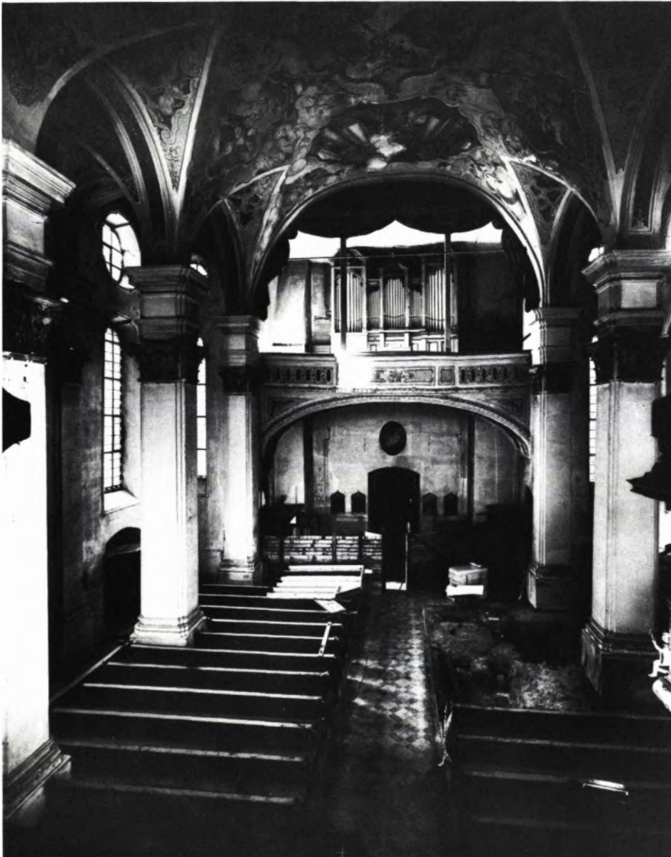
20 DAS KIRCHENSCHIFF während der Bauarbeiten. Blick nach Westen. Die Orgelempore ist vorn stark durchgebogen. An den Hängebalken ist sie in die freitragende Dachkonstruktion aufgehängt.
