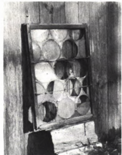
15 und 16 SECHSECK- UND MONDSCHEIBENVERGLASUNG. Die beiden Fenster aus Rottweil haben noch die alte Bleiverglasung.
