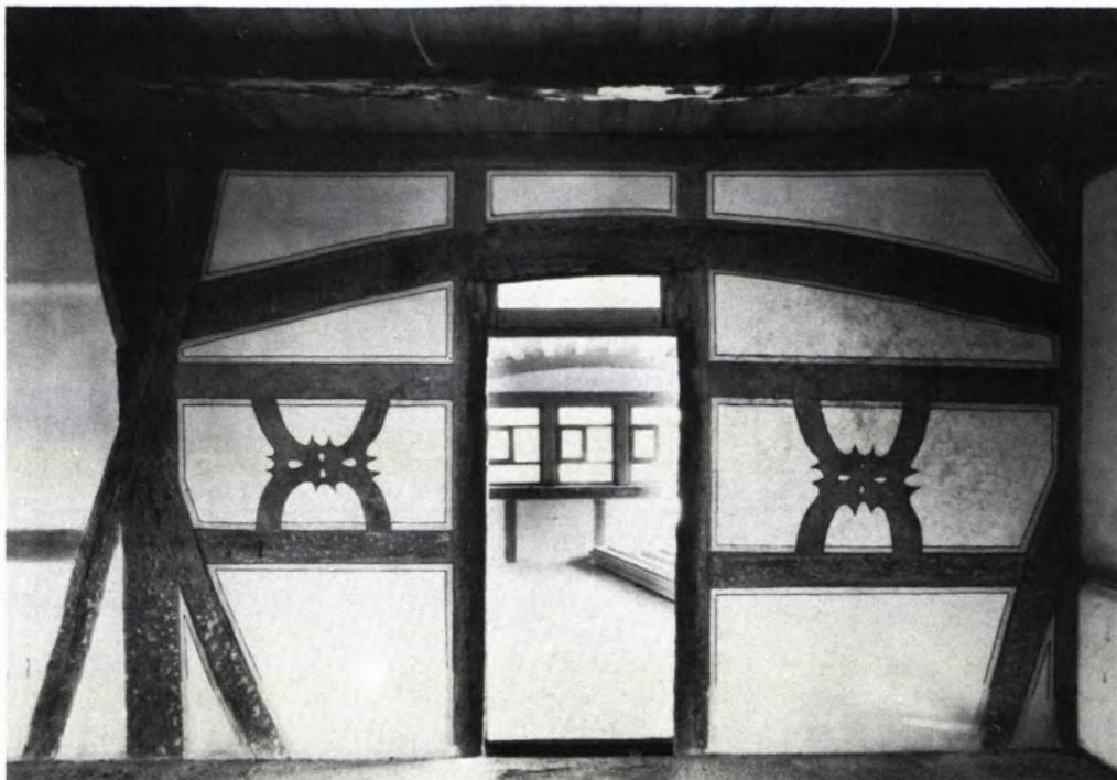
7 DIE FLURWAND mit Durchblick in die Stube mit Bohlenbalkendecke. Der obere Riegel beiderseits der Türe ist ausgemalt, ebenso die „Feuerböcke“. Diese Bemalung wurde im Zuge der Rotfassung des Fachwerkes angebracht. Den Balken folgt ein schwarzer Belegstrich. Über der Türe verläuft der gebogene Auflagerbalken für die Decke.
