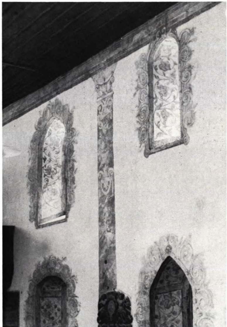
2 DETAIL DER NORDWAND mit der 1921 wiederhergestellten Malerei.
