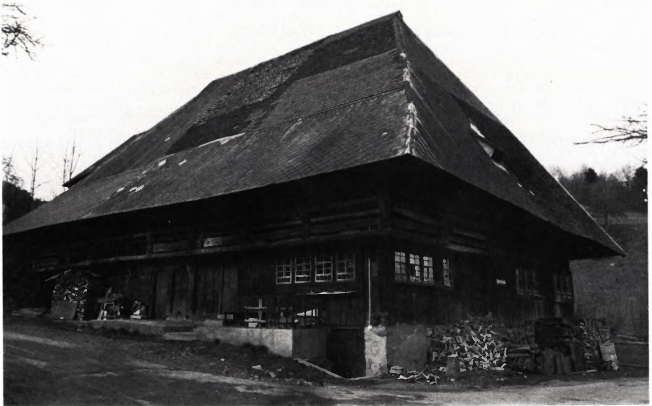
1 DER FUSSENHOF IN KIRCHZARTEN-GEROLDSTAL wurde am 28. 3. 1754 vom Zimmermeister Hans Janz aufgerichtet. Die Firstsäulenkonstruktion, die Walmausbildung und der Wandaufbau sind noch unverändert erhalten geblieben.
