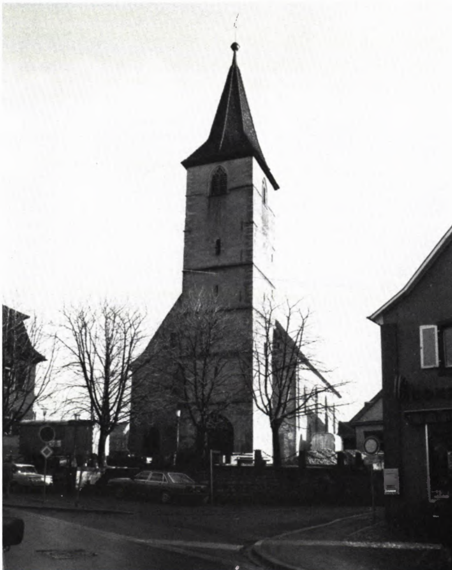
1 KIRCHE ST. MARTIN. Ansicht von Südwesten mit dem aus der Kirchenachse nach Süden verschobenen Westturm.
