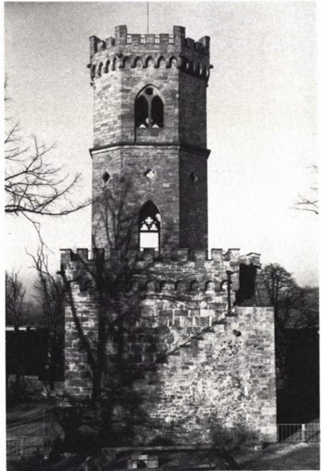
14 DER BERGFRIED nach der Sicherung und Instandsetzung, die 1976 durchgeführt wurden.
