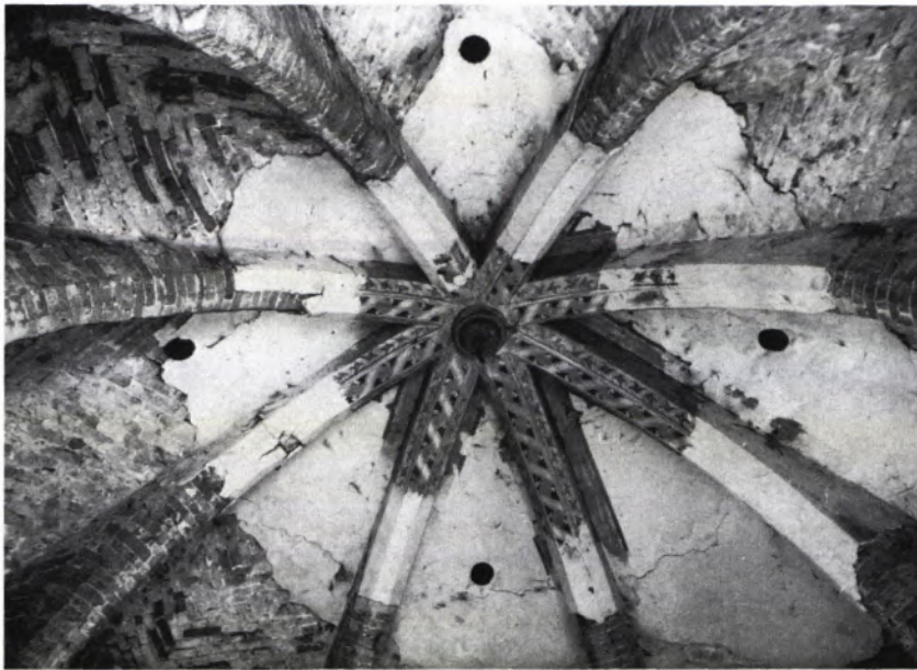
7 DAS GEWÖLBE im oberen Raum des Malerturms mit Resten der ursprünglichen Ausmalung.
