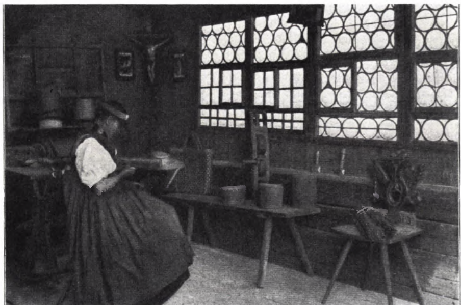
12 AUFNAHME UM 1900. Sie belegt noch die mit Butzenscheiben gefüllten Fenster und den späteren Ersatz.
