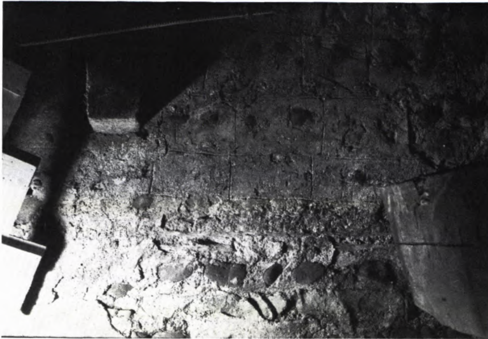
7 QUADERRITZUNG auf dem Verputz. In der Bild- mitte verläuft die in die Mauer eingelassene Nut zum Ein- schieben von Bodenbrettern.
