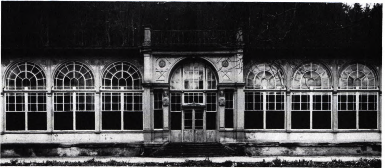
6 DER MITTELTEIL DES KURSAALES mit dem reichverzierten Hauptportal.
