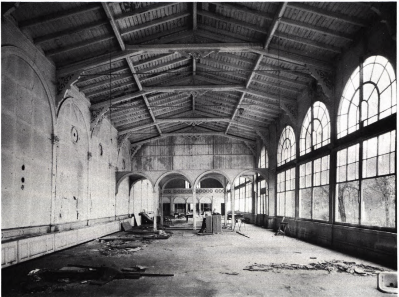
9 INNENANSICHT DES KURSAALES.
