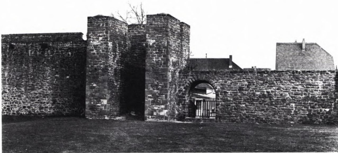
4 MAUERTURM in der Nordostflanke der Stadtmauer mit Schlupfporte.
