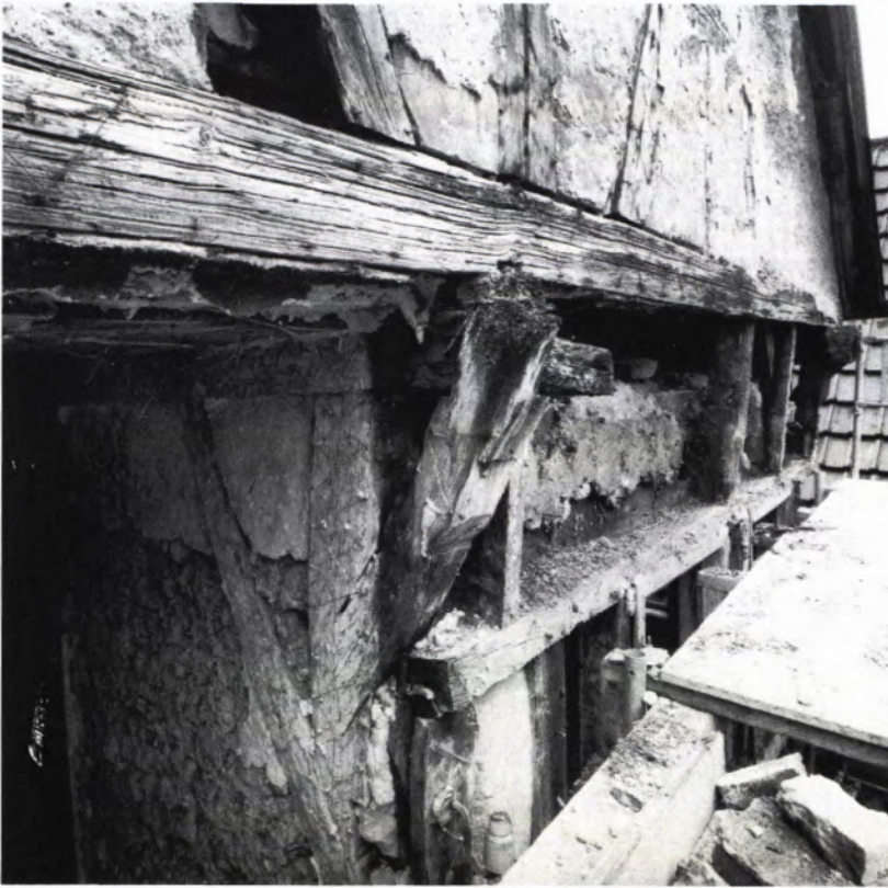
11 SÜDGIEBEL nach teilweiser Entfernung der Ausriegelung. Links Lehm Schlag auf der Bohlenwand der kleinen Stube, Ernseite. Vorne Ständer mit angeblatteter Knagge, darunter Kopfriegel des Fenstererker. Über diesem ist die mit Strohlehm überstrichene Stirnbohle sichtbar. Die senkrechten Pföstchen auf dem Kopfriegel sind lose eingestellt und dienen der Verankerung einer späteren Vermauerung.
