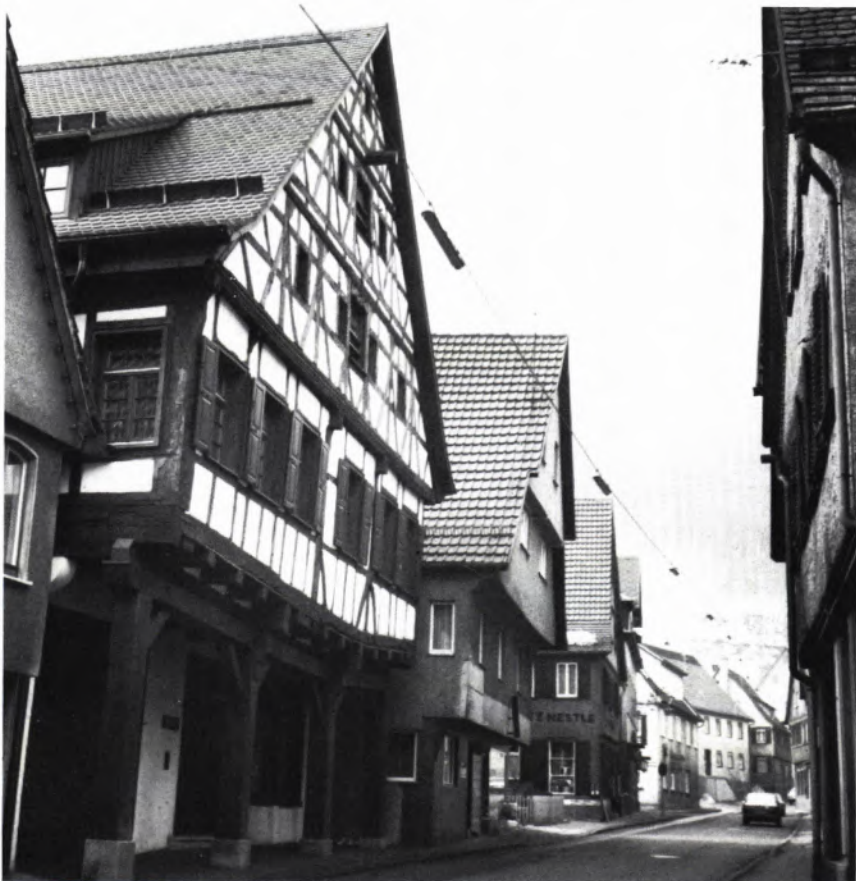
3 GEBÄUDE Marktstraße 13 nach der Fachwerkfrellegung und nach dem Einbau einer Arkade. Während das Fachwerk des aus dem 17. Jahrhundert stammenden Giebels einheitlich ist, ist im Obergeschoß zwischen den vier ursprünglichen Ständern mit teilweise erhaltenen angeblatteten Bändern bei der Änderung der Fenster ein neues Riegelfachwerk eingefügt worden.
