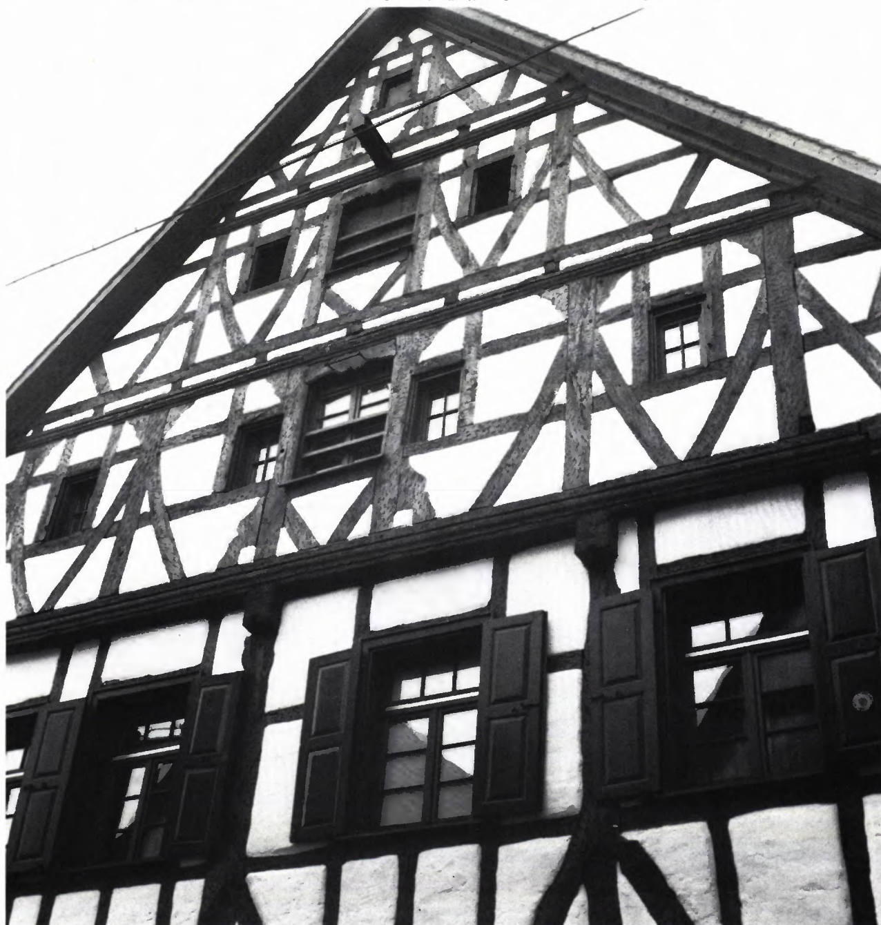
9 AUSSCHNITT DER GIEBELFASSADE. Die ehemaligen Aufzugsöffnungen sind in Fenster umgewandelt worden.
