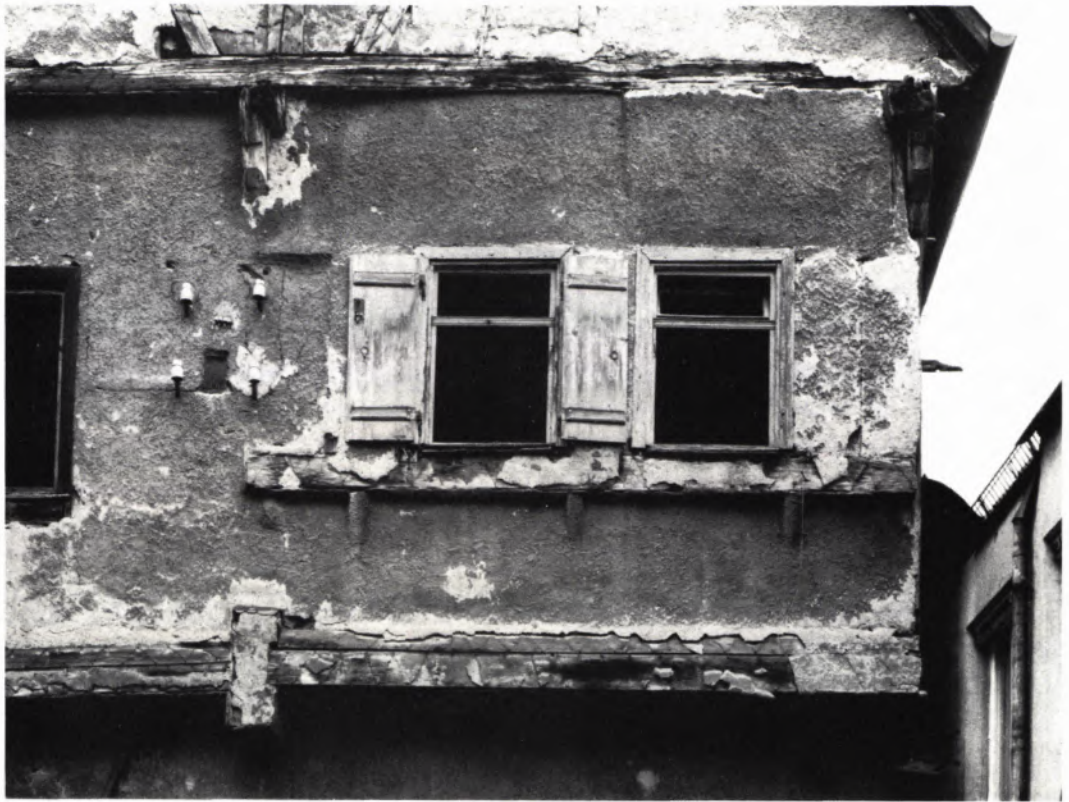
13 DER FENSTERERKER der kleinen Stube zeichnete sich vor der Instandsetzung durch den vorspringenden Brustriegel und die Konsolen bereits im Putz ab.
