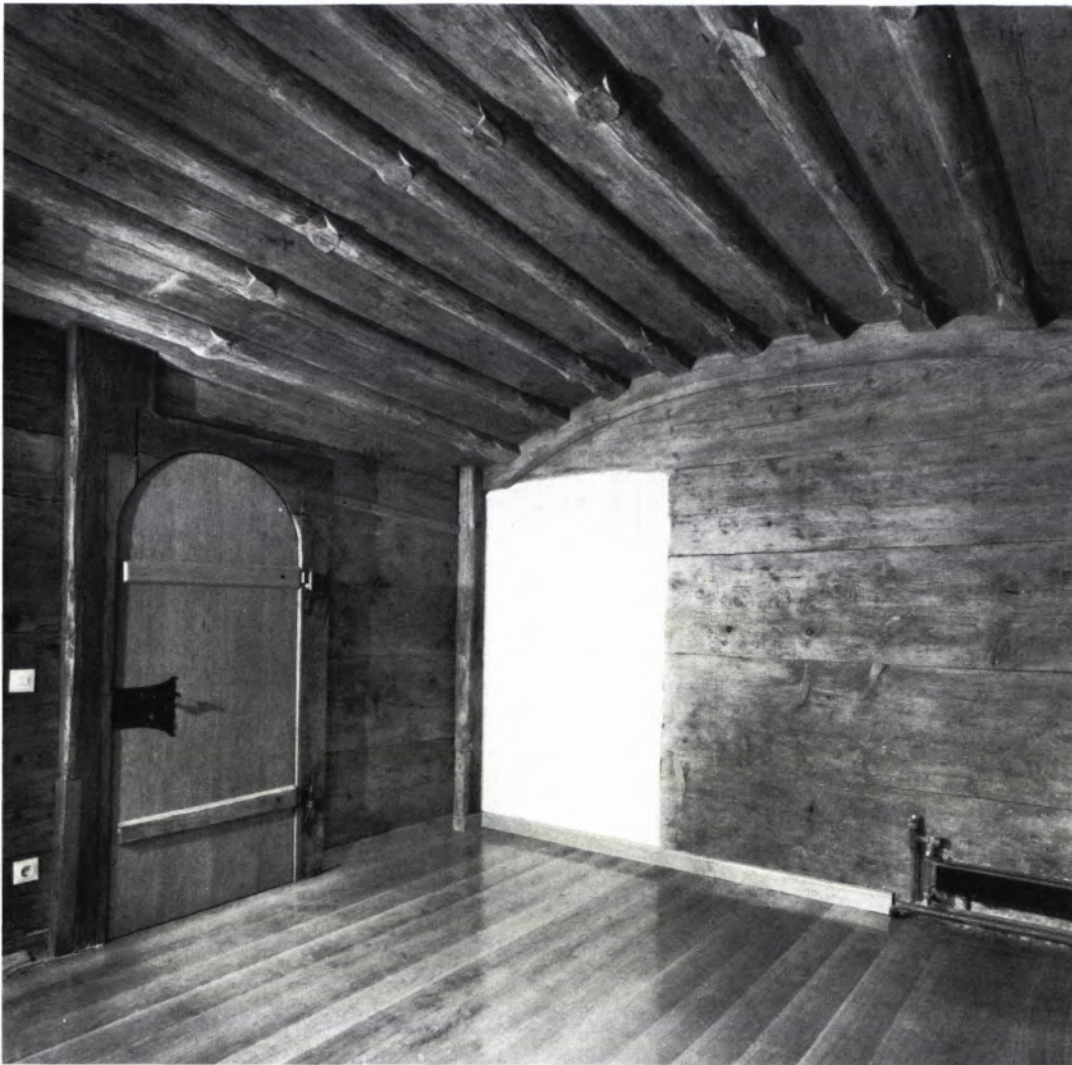
15 KLEINE STUBE nach der Instandsetzung. Das Holz war ursprünglich nicht farbig gefaßt. Die Bohlenwand wurde im Bereich eines Ofens durch eine massive Ausmauerung ersetzt. Der Bogen des Türgewändes war im oberen Bereich erhalten.
