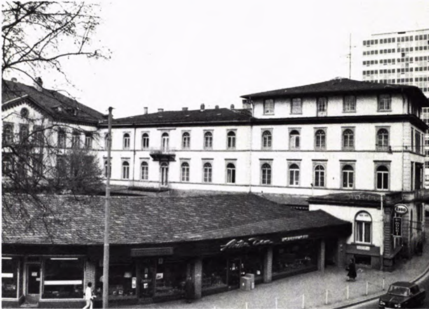
6 HOTEL SCHRIEDER, das älteste der großen Weststadt-Hotels. Es wurde beim ehemaligen Bahnhof um 1840 erbaut und später erweitert.
