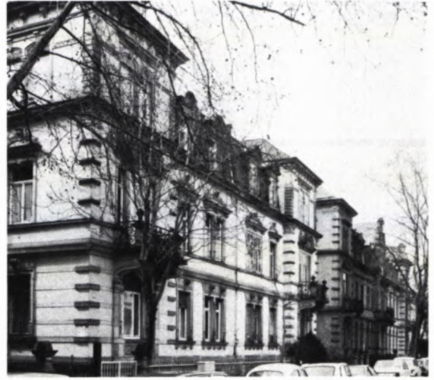
21 DOPPELVILLEN UND REIHENHÄUSER zwischen 1890 und 1903 (vgl. Abb. 22–27). Hier Beispiele an der Kaiserstraße.
