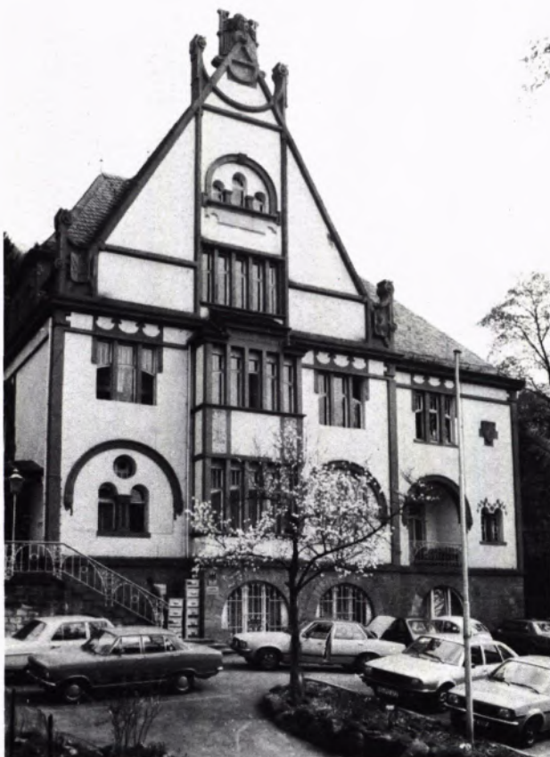
14 EHEM. VILLA FULVIUS, Gaisbergstraße (heute Fernmeldeamt). Bau des Burgen-Restaurators B. Ebhardt, 1899/1900.
