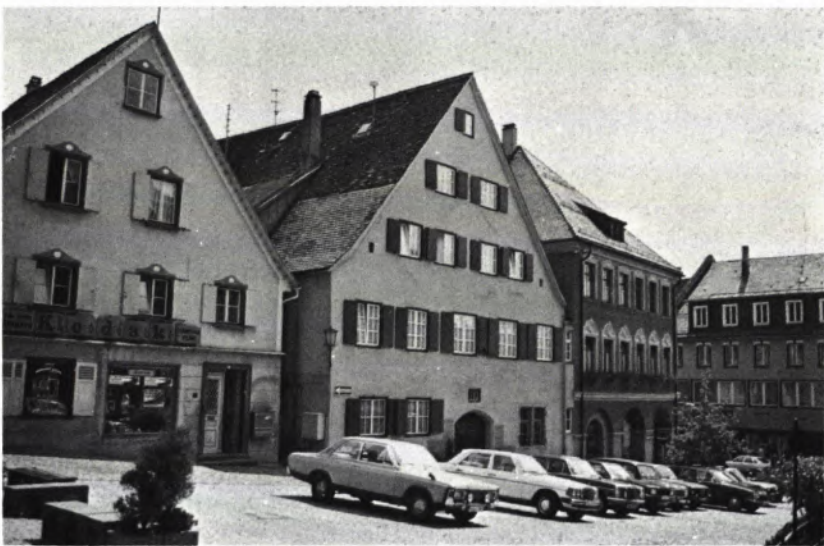
12 DER GÄNSBÜHL, in der Mitte die ehem. Kanzlei, rechts das Rathaus.
