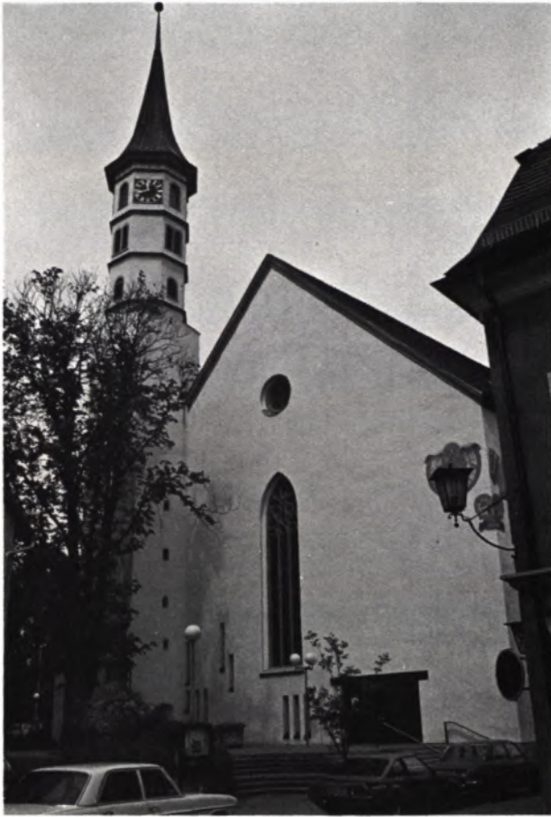
7 EV. DREIFALTIGKEITSKIRCHE. Sie entstand 1613/1615 an der westlichen Stadtmauer.
