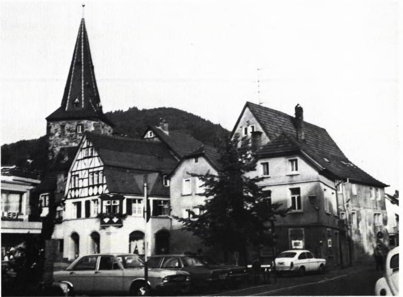
2 GESAMTANSICHT DES BADHAUSES 1965 vom Lindenplatz aus. Am Kernbau ist die Aufstockung des 19. Jahrhunderts sichtbar und die beiden Anbauten, die mit ihrer Giebelseite auf der Stadtmauer aufsitzen. Der rechte Bauteil wurde abgetragen.
