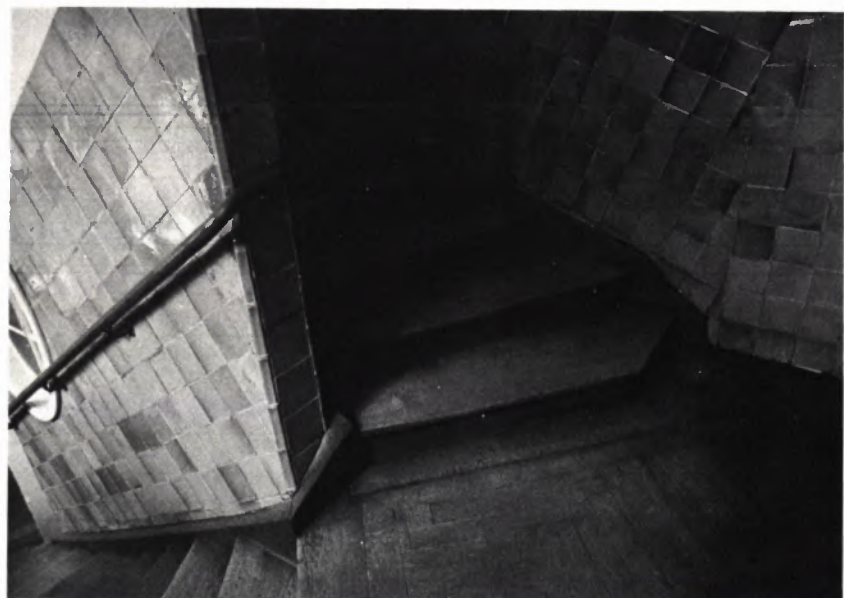
4 TREPPENHAUS zwischen erstem und zweitem Obergeschoß.
