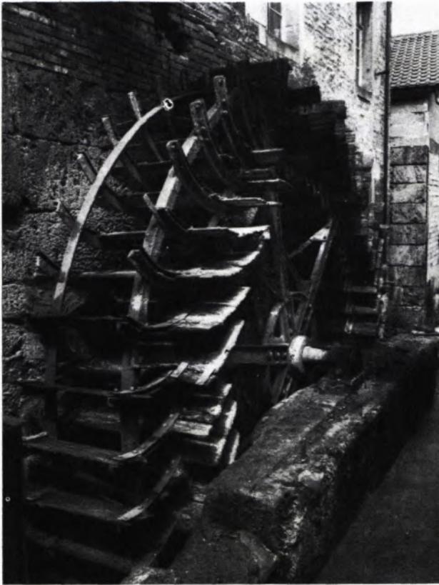
4 WASSERRAD der Uracher Klostermühle vor der Instandsetzung 1980 – ein für die Frühzeit der Industrialisierung typisches großes Rad.
