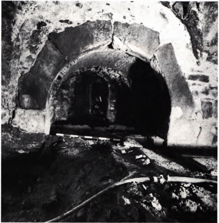
7 ÖFFNUNG ZUM FEUERRAUM vom Badraum im Erdgeschoß aus gesehen.
