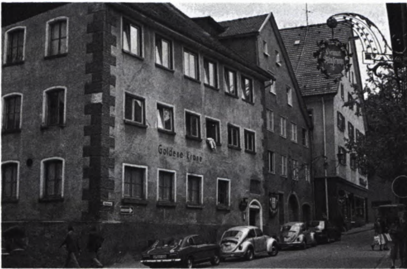
11 DIE KORNHAUSSTRASSE, eine der charakteristischen Querverbindungen zwischen Ev. Kirchgasse und Bachgasse.
