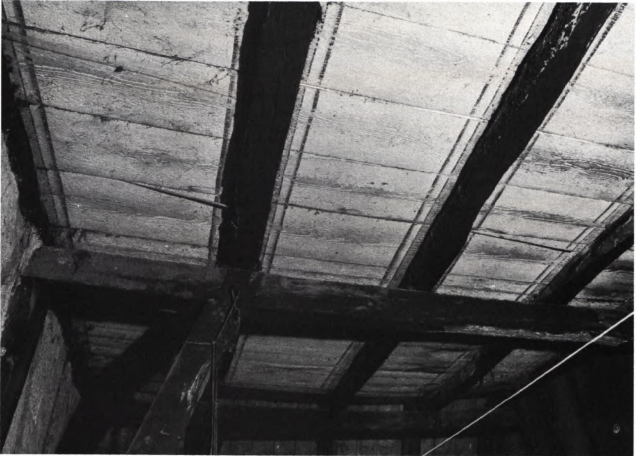
11 MARKTSTRASSE 11. Bemalte Decke im Dachgeschoß.
