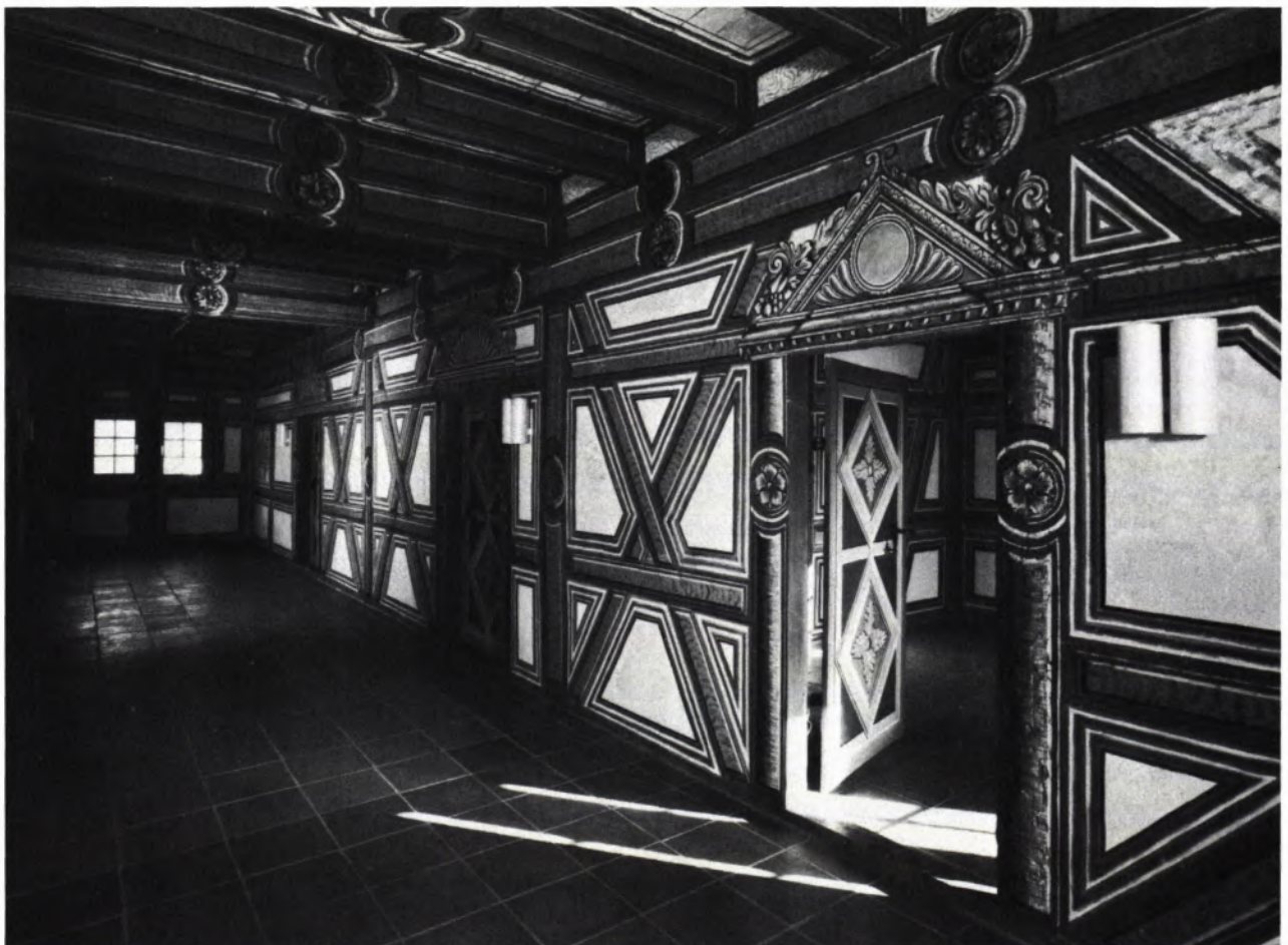
1 BIETIGHEIM, HORNMOLDHAUS nach der Instandsetzung. Sichtbares Fachwerk im Inneren mit reicher Bemalung. ▷
