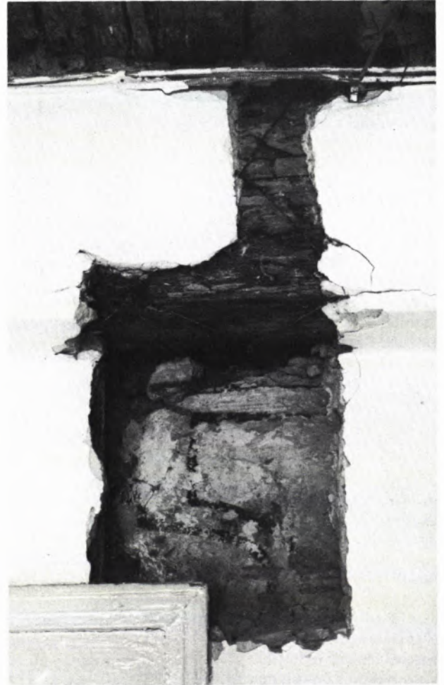
14 EHEM. OBERAMTSGEBÄUDE. Graue und schwarze Begleitstrichmalerei kam unter dicken Putzschichten zum Vorschein.
