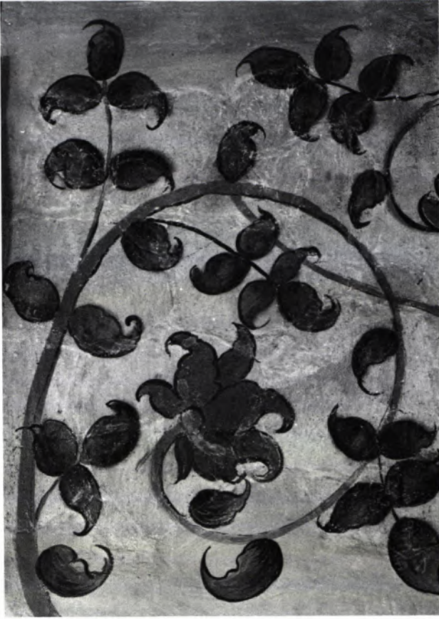
3 SINDELFINGEN, Haus Kurze Gasse 10. Renaissance-Blütenmalerei im Dachgeschoß.
