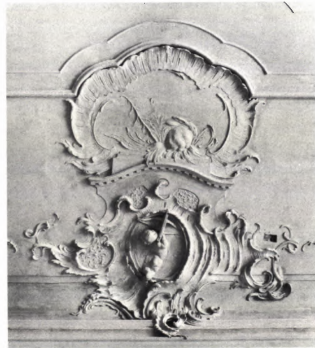
3 NACHHER: Der gleiche Ausschnitt nachdem Schicht für Schicht die Überfassungen des Stucks abgetragen worden waren. Die ursprüngliche modellierte Stuckfläche ist noch – vor der erneuten rekonstruierten Fassung – sichtbar.
