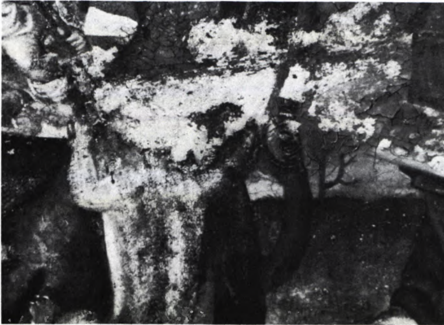
6 DECKENBILD-SCHÄDEN: Der Bildausschnitt zeigt in annähernd natürlicher Größe die schüsselartig aufstehende Malschicht. An den hellen Stellen sind die Malflächen durch Feuchtigkeit reduziert.
