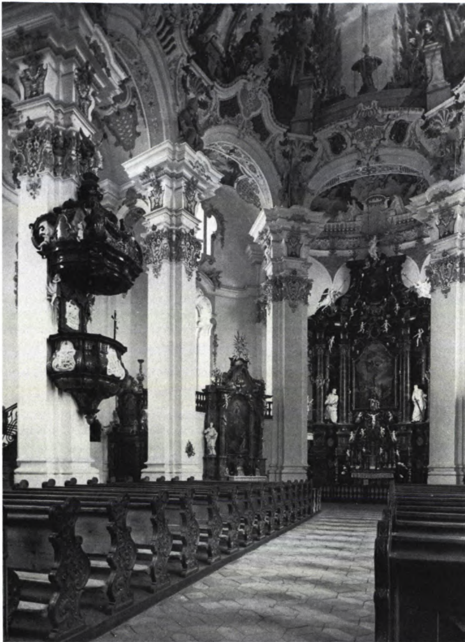
1 STEINHAUSEN, Wallfahrtskirche: Der Blick in den Innenraum zeigt die Pfeilerstellung, den Umgang und die Hauptkuppel, die durch statische Schäden stark gefährdet war.
