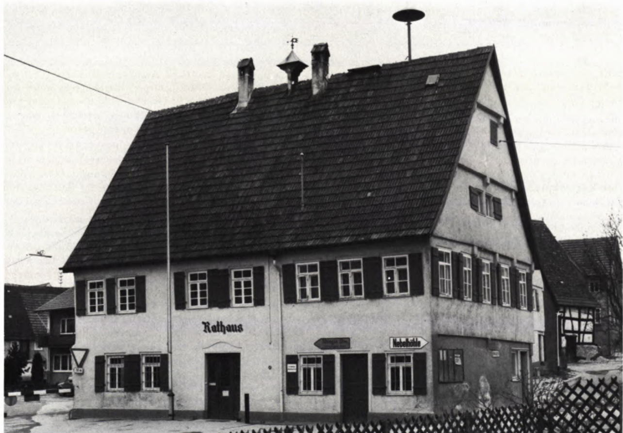
3 BLICK AUF DIE SÜD- UND SÜDOSTSEITE des Rathauses.
