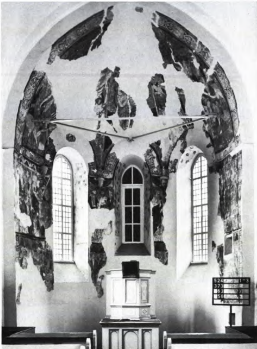
12 MARIENHAGEN, Oberbergischer Kreis. Ev. Kirche nach der Restaurierung von 1959, bei der die Ausmalung konsequent auf den noch erhaltenen originalen Bestand des frühen 14. Jahrhunderts reduziert wurde.
