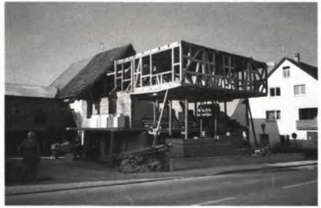
3 „SCHWÄBISCHER UMBAU“. Erhaltung des Fachwerkgerippes im Obergeschoß und Neubau von Erdgeschoß und Dach.
