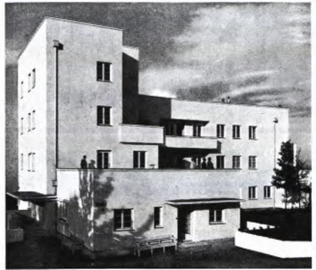
20 MIETSHAUS VON PETER BEHRENS. Zustand von 1929 und 1984 (nach der Renovierung).
