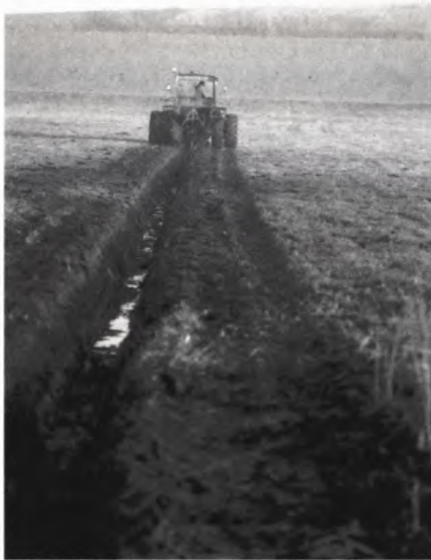
12 EINE GRABENFRÄSE zur Entwässerung der Feuchtwiesen im Federseemoor.
