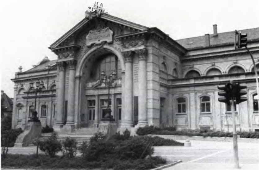
1 RAVENSBURG, KONZERTHAUS. Das 1896/97 nach Plänen von Ferdinand Fellner errichtete Gebäude gehört nach Entwurf und Ausführung zu den Hauptwerken des späten Historismus im süd-deutschen Raum.
