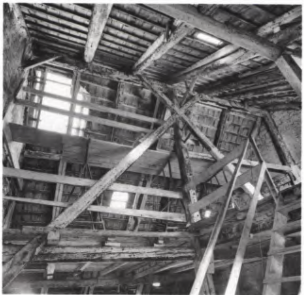
6 RAVENSBURG, MARKTSTRASSE 36, Blick in den 1379 datierten Dachstuhl.
