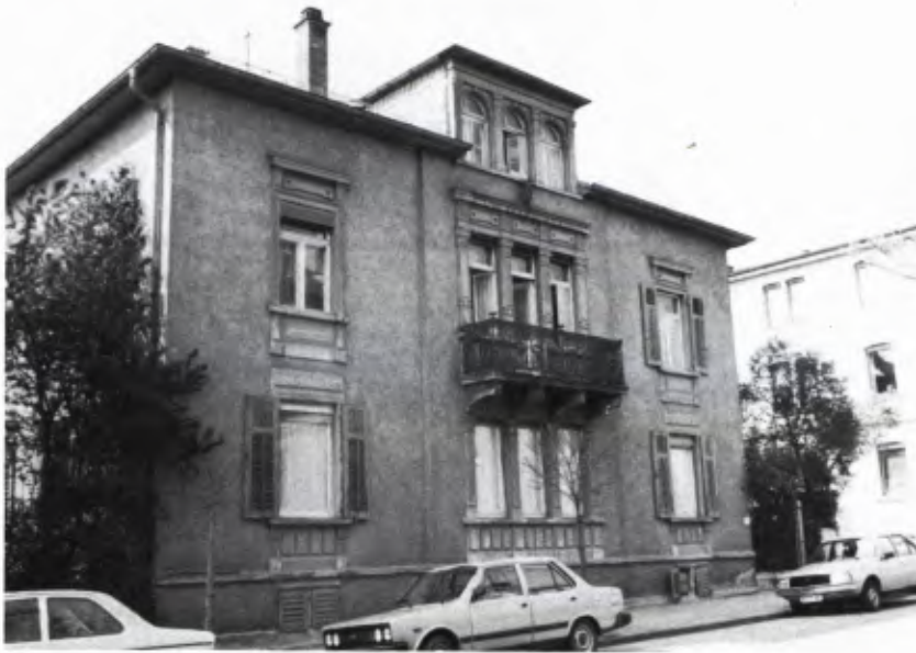
4 RAVENSBURG, SEESTRASSE 28. Diese kleine Villa, 1874 von dem Ravensburger Architekten Kiderlen erbaut, dokumentiert das Wohnideal eines mittelständischen Bürgers der Gründerzeit.
