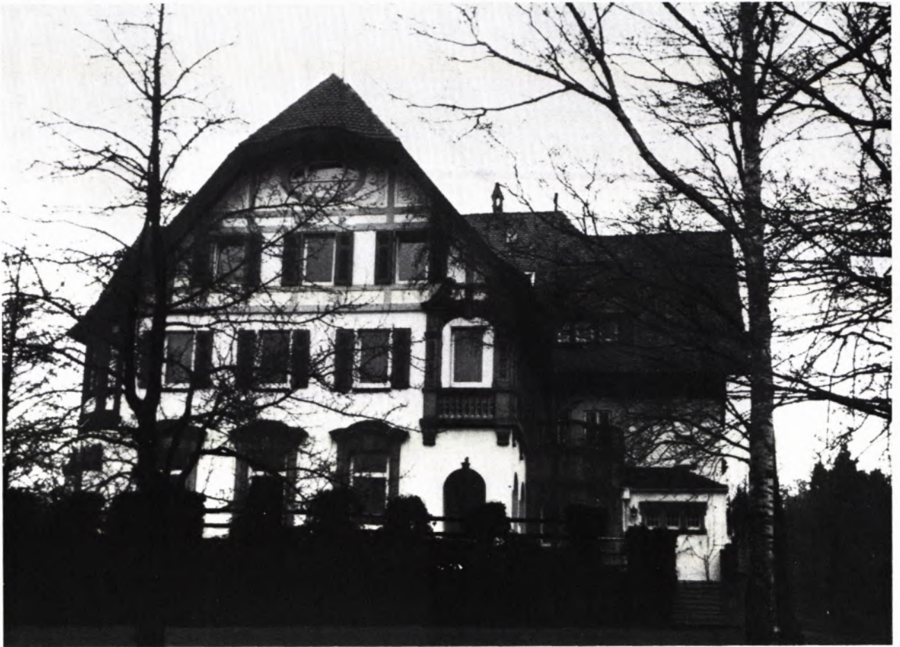
2 NORMANNENHAUS. WESTANSICHT. Das Fachwerk im Giebel ist heute grau gestrichen, so daß es das Erscheinungsbild des Hauses kaum noch bestimmt. Entsprechend tritt das Erkerfenster rechts stärker hervor und wirkt als Bauglied an jenem Platz zu schwer.
