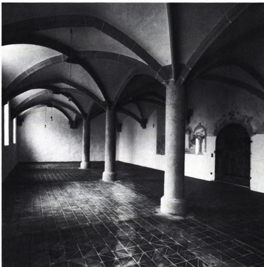
9 KAPITELSAAL im Ostflügel der Klausur. Der Tonplattenboden wurde neu verlegt, Wände und Gliederungen erhielten die ursprüngliche Farbfassung der Rietheim-Zeit.
