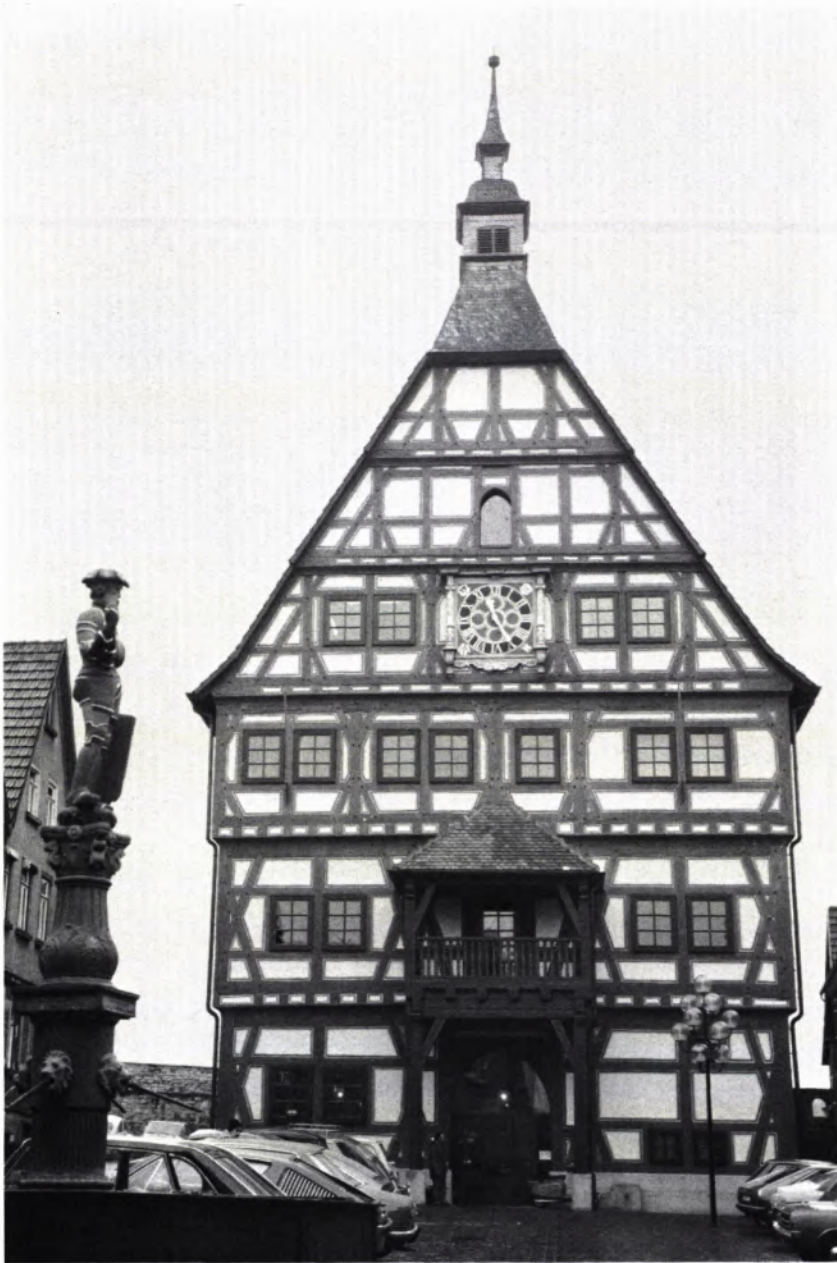
1 DAS RATHAUS IN BESIGHEIM, Kreis Ludwigsburg, das 1459 mit „alemanischem“ Fachwerk erbaut wurde, nach der Restaurierung. Im Vordergrund der Marktbrunnen mit dem Standbild eines Markgrafen von Baden.
