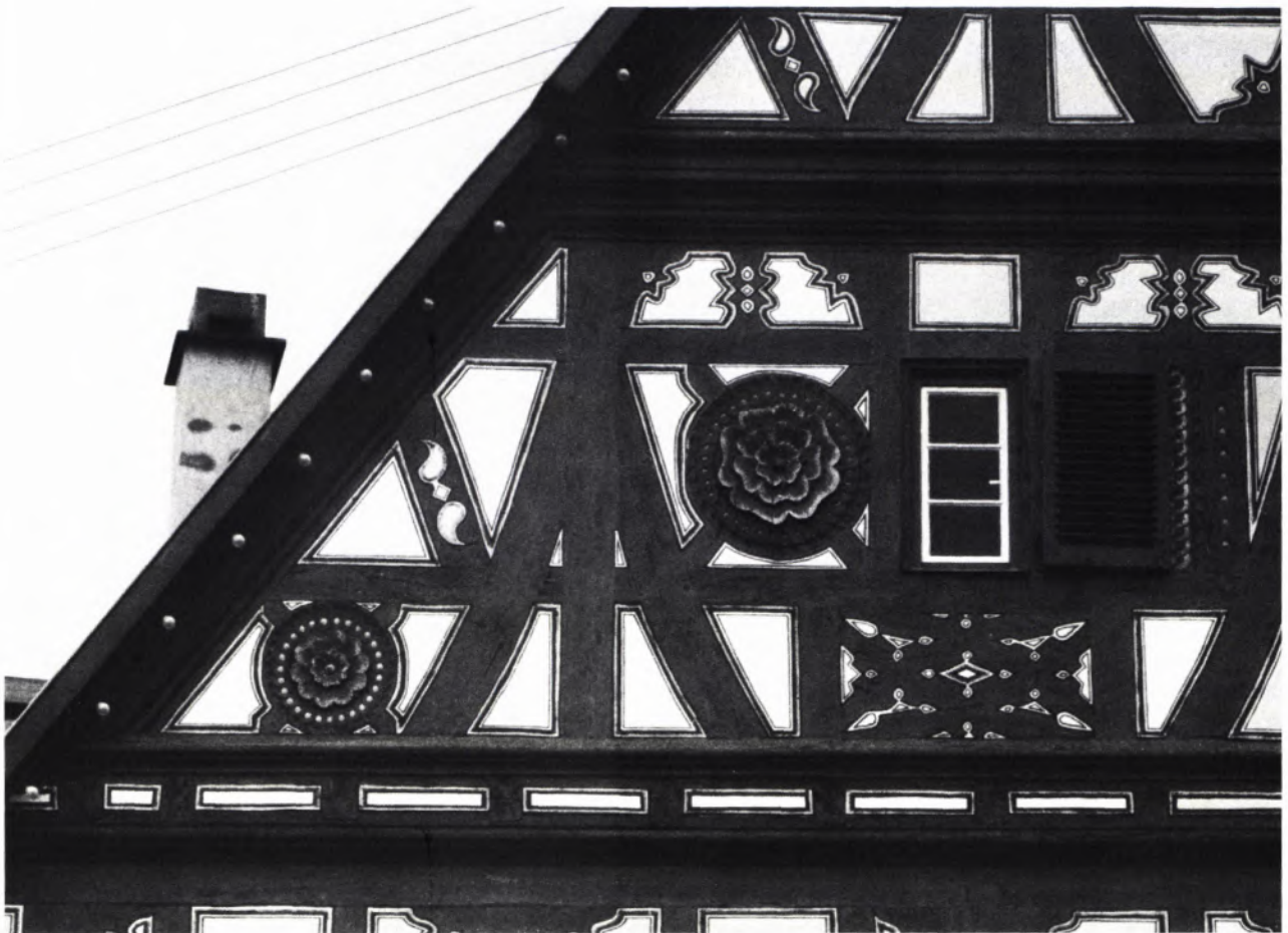
6 HAUS KIELMEYER IN ESSLINGEN. Wiedererstellte Fassung des „fränkischen“ Fachwerks (zur Farbe vgl. das Titelbild).
