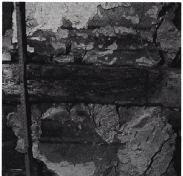
7 HAUS KUPFERGASSE 1 IN ESSLINGEN. Reste des aufgemalten Sturzriegels am Bohlenzimmer im ersten Obergeschoß der Nordfassade.
