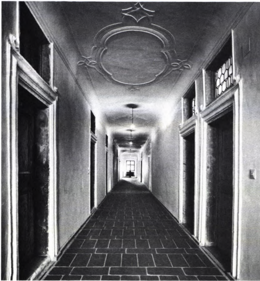
11 FLUR IM WESTLICHEN ZELLENTRAKT des Klausurober- geschosses. Stuck um 1720.
